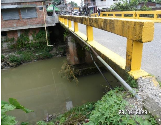
Cruce aéreo sobre la quebrada Las Ánimas. La tubería de gas se encuentra encamisada con una tubería metálica
