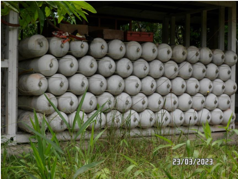
Vista del estado actual de la plataforma de almacenamiento del gas en la estación descompresora.
