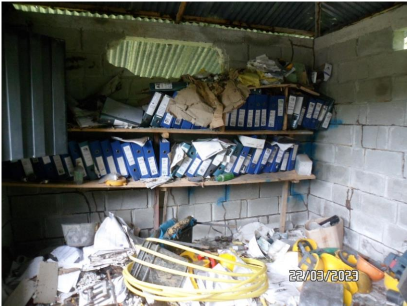
Vista del interior del cuarto de control u operación donde se observa que las instalaciones fueron abandonadas dejando documentos y accesorios para mantenimiento de redes, así como elementos de protección personal EPP y herramientas varias.
