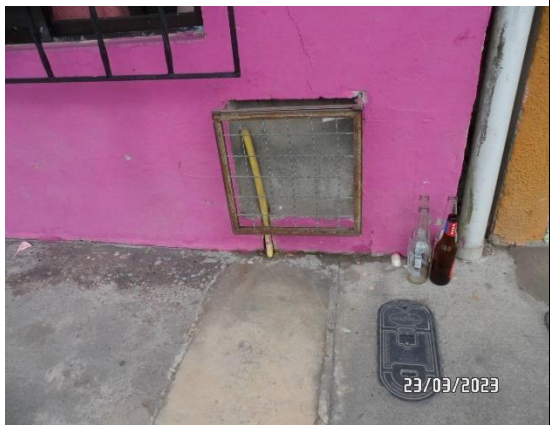
Acometida domiciliaria e internas instaladas. Se observa la reparación del andén.
