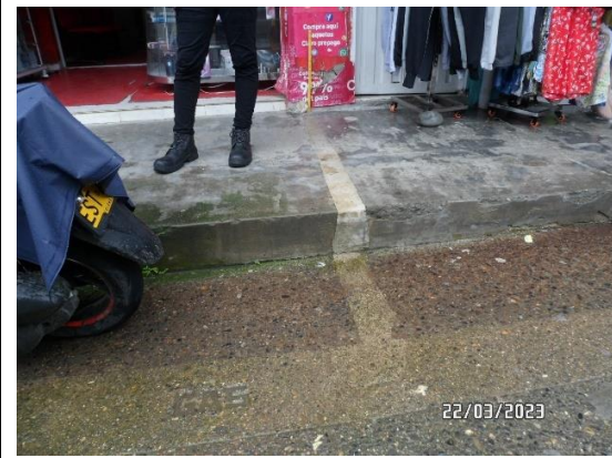
Se evidencia la reparación de la vía y del andén al instalarse la acometida domiciliaria
