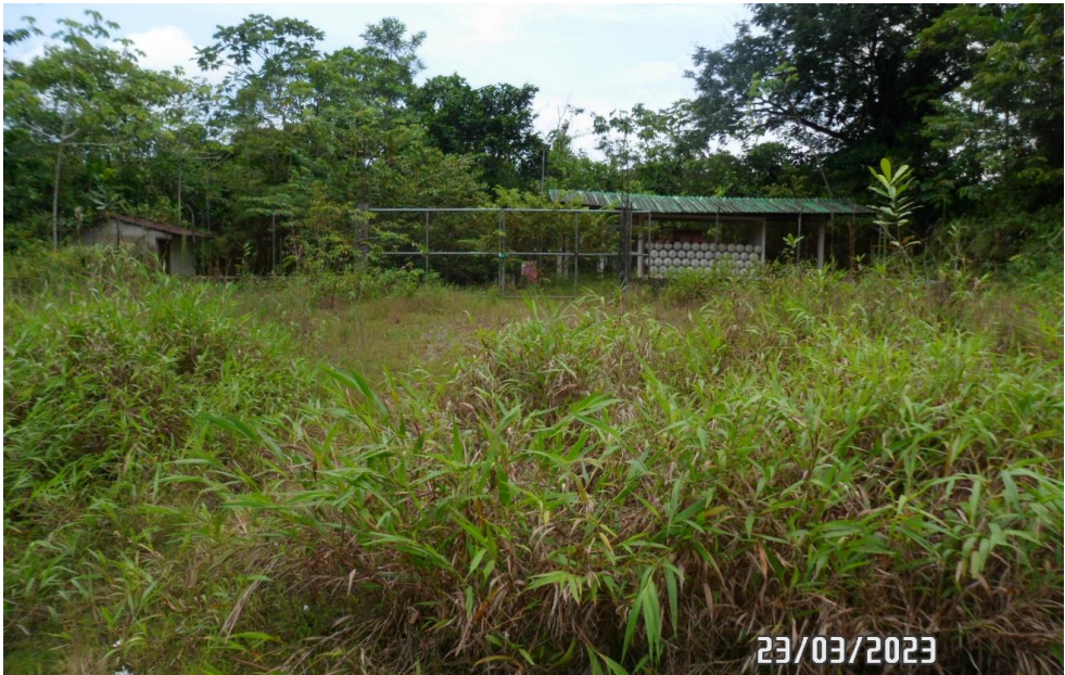
Vista general de la estación descompresora de gas natural en cercanías a Unión Panamericana, observándose abandono y falta de mantenimiento en general.
