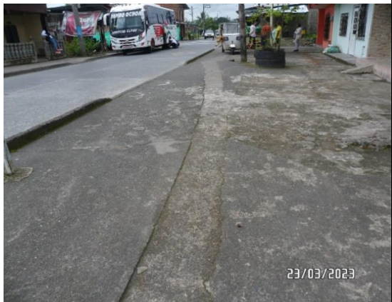
Se evidencia la instalación de la red de distribución por los arreglos que se encuentran en la vía y los andenes.
