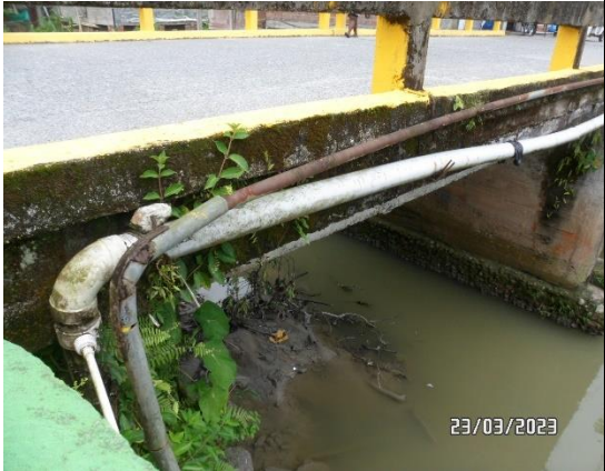
Cruce aéreo sobre la quebrada Las Ánimas en el otro costado del puente vehicular. Se observa que la tubería de gas se encuentra encamisada con una tubería metálica
