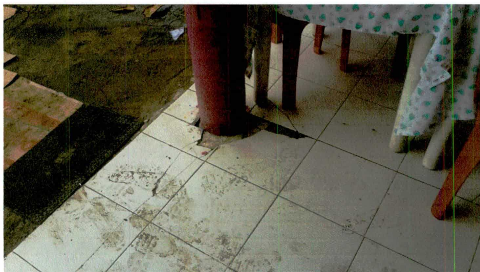
FOTO No.10 – Detalle de acabados de piso afectados en local comercial
