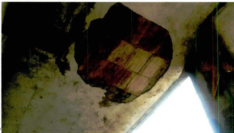
FOTO No.15 – Detalle de cielo raso afectado (desprendimiento pañete)
