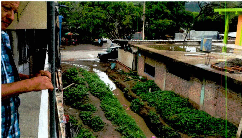
FOTO No.5 – Estancamiento de aguas en zanja de alcantarillado
