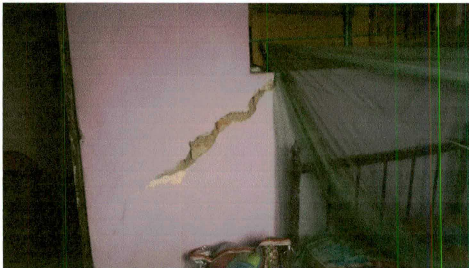
FOTO No.19 – Detalle de muros afectados (fisuras - grietas )
