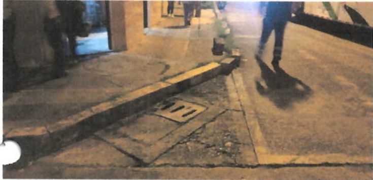
FOTOGRAFIA DEL LUGAR DE LOS HECHOS TOMA PUNTO DE REFERNCIA A TAPA DE ALCANTARILLA FOTOGRAFIA 3
