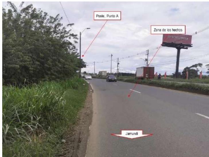
**Fotografía No.9 y 10 Plano General:** fotografía tomada sentido Jamundí – Cali donde se observan las características generales del tramo de vía curva, plana, estado bueno, asfalto, una calzada, dos carriles, único sentido de circulación, señalización horizontal línea de borde blanco , central segmentada.
