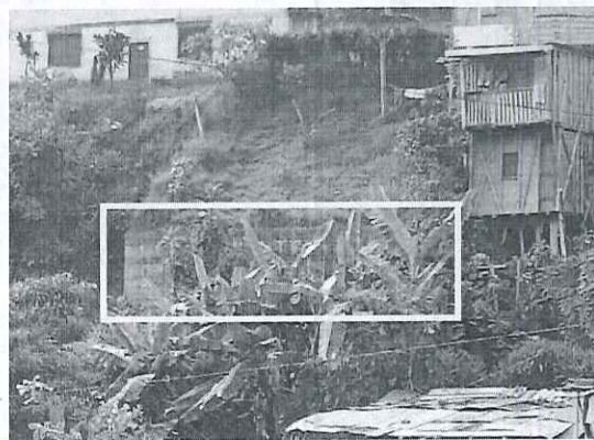
Imagen 7. Vista de un muro de contención localizado a media ladera que forma parte de la ATG No. 61.
