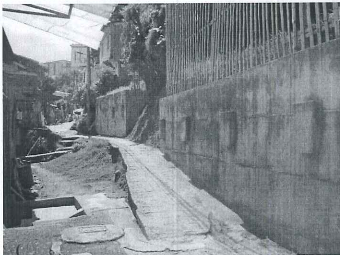
Vista general de los muros reforzados construidos por CORPOCALDAS, EN EL AÑO 2012 en el año 2013.
