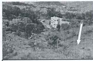
Entrega de aguas lluvias sobre la ladera, sin obras.
