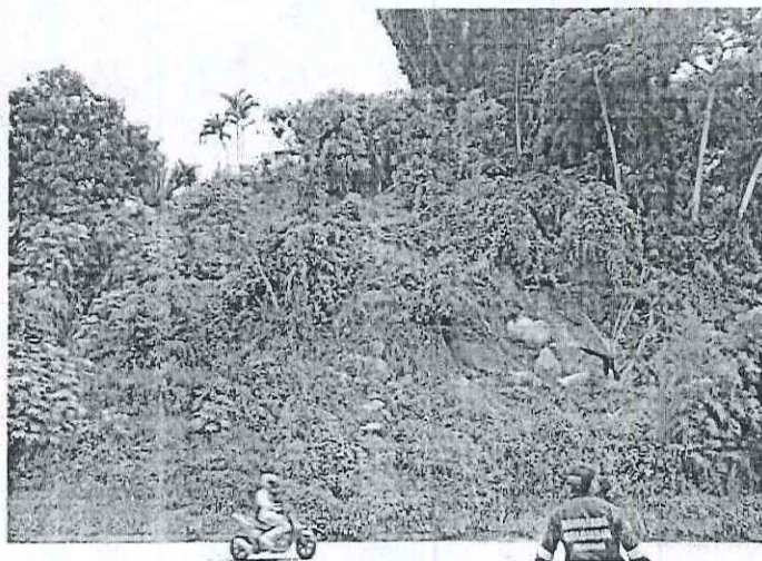
Imagen 1. Ladera con procesos de inestabilidad.
