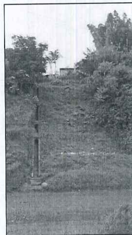
Foto 2: imagen del canal de rápidas que descende por un costado de la ladera donde se ubican las viviendas de la problemática
