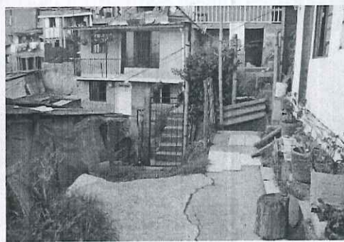
Almacenamiento de agua reciclada y fisuras en andén
