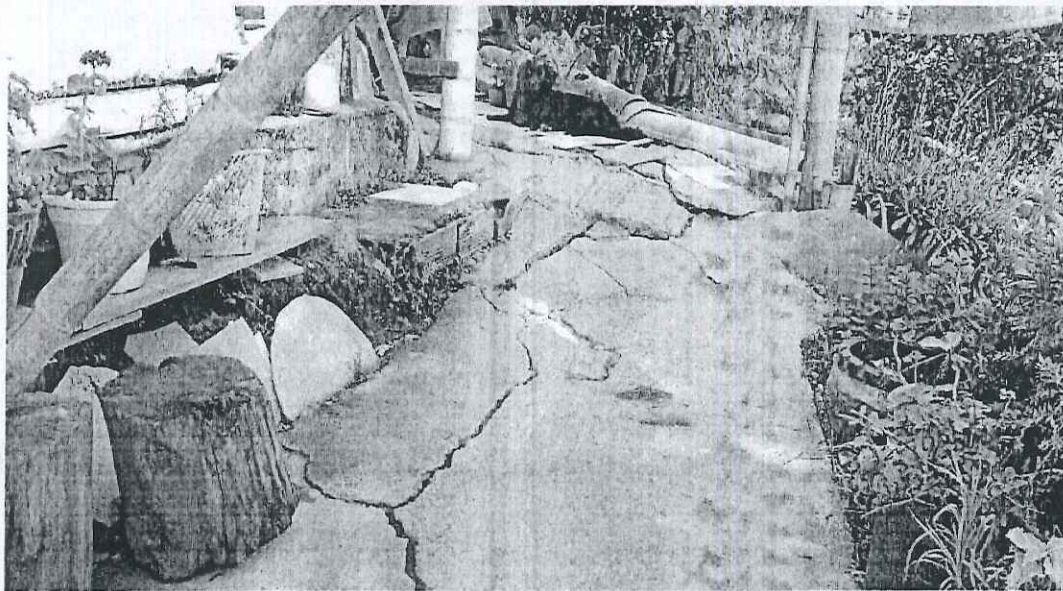
Imagen 1. Agrietamiento en losa de concreto – Patio de vivienda.
