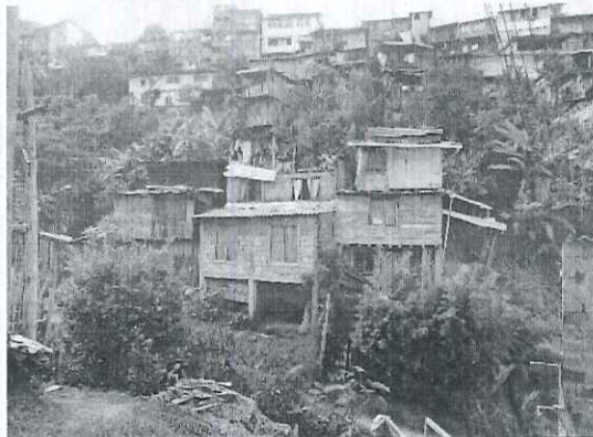
Imagen 6. Vista de las viviendas localizadas en la parte baja de la ladera (Calle 48D).
