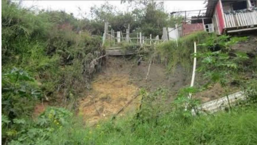
Figura 128. Detalle del movimiento en masa en el sector central del área.
