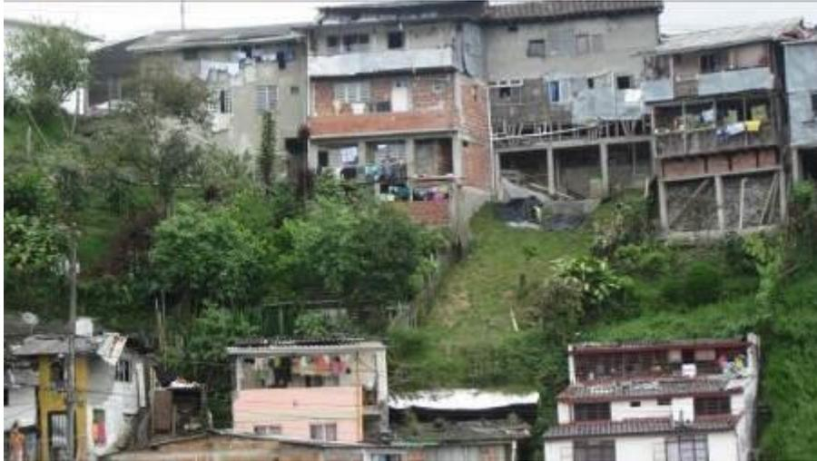
Figura 114. Se muestran viviendas localizadas en la corona y base de la ladera, las cuales pueden resultar afectadas ante la ocurrencia de un movimiento en masa.
