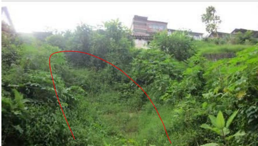
Figura 152. En el Sitio 7 se tiene un movimiento en masa que genero considerables a daños en las viviendas localizadas en la parte baja de la ladera. La línea roja marca el deslizamiento
