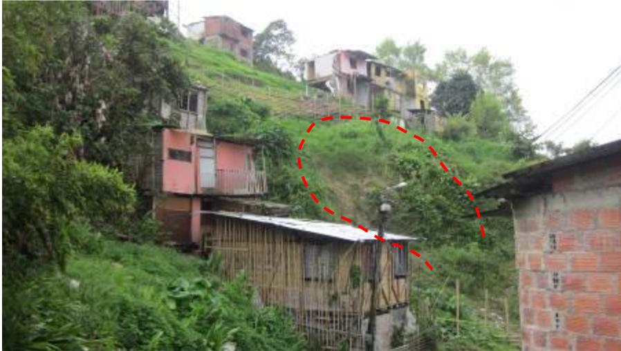
Figura 86. Panorámica del deslizamiento que afectó la parte media y baja de la ladera.
