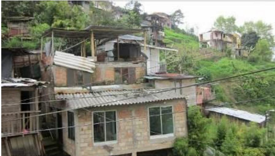
Figura 101. Es notable en las viviendas de la base de la ladera, la ausencia de canales y bajantes para el manejo de las aguas de las cubiertas, condiciones que permite la saturación de los suelos, y la acción erosiva de las aguas de escorrentía.
