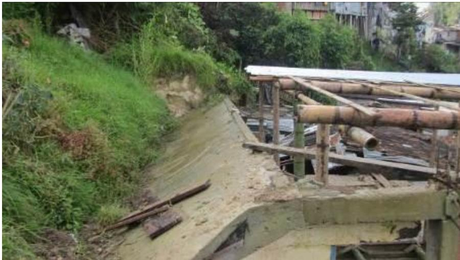
Figura 108. **Detalle de los daños provocados por el movimiento en masa del sector norte que afectó una de las viviendas localizada en la base de la ladera.**
