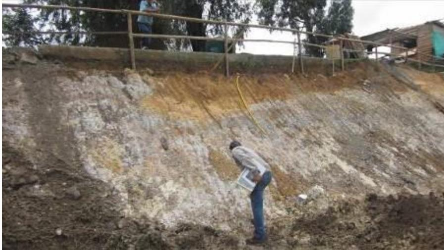
Figura 78. **Aspecto del depósito de flujo de escombros de la Formación Casabianca hacia la corona del talud de interés, zona en la cual el alto grado de meteorización de esta unidad es evidente ante la variedad de colores.**
