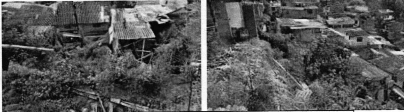
Imagen 2 y 3. Vista de algunos de los procesos en taludes internos a viviendas.
