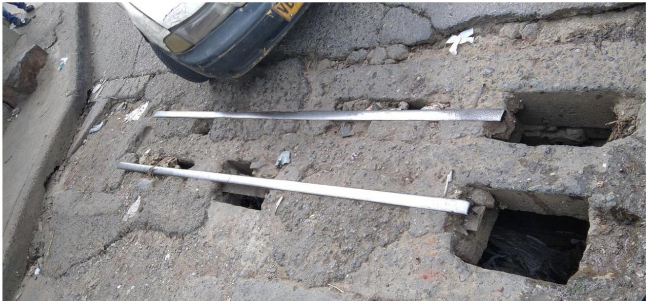
Como se puede observar, no se trata de un hueco en la vía, se trata de una rejilla de un sumidero o alcantarilla de aguas lluvias.
