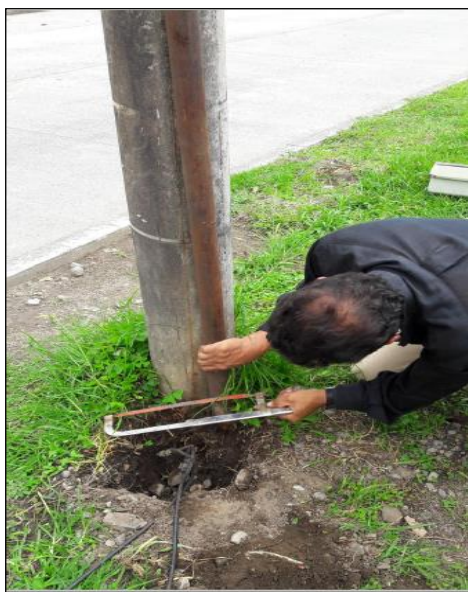
Tubo que conduce el cableado eléctrico
