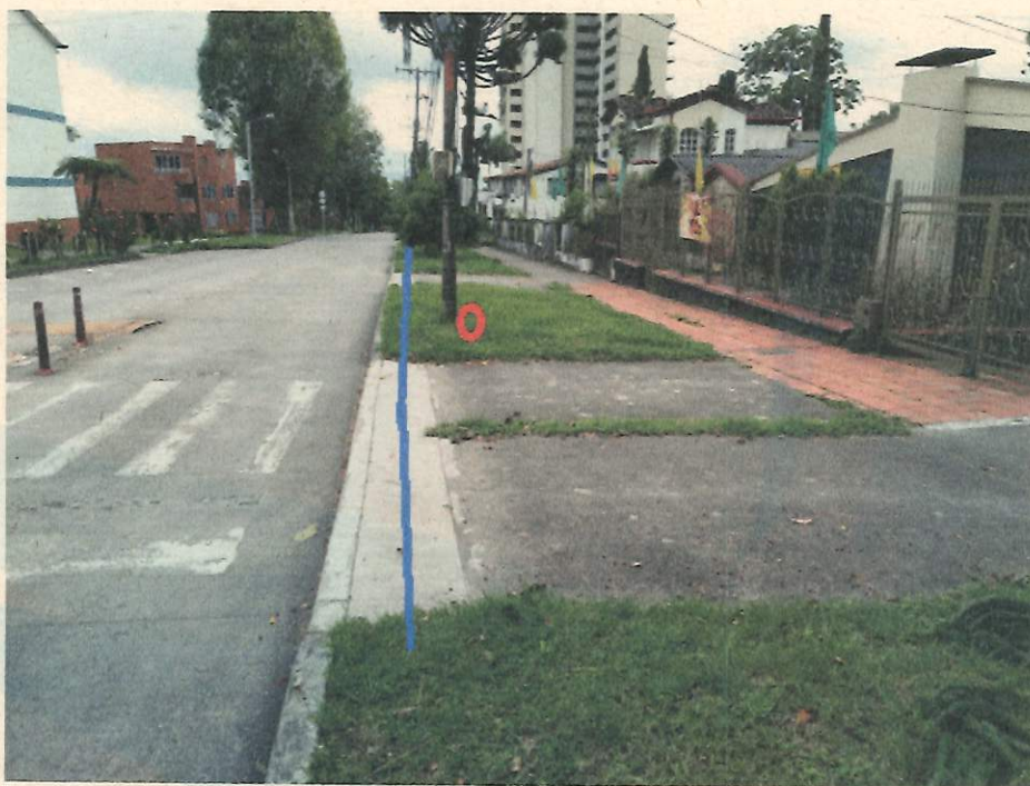
Línea Azul, tubería instalada, círculo rojo daño en la acometida. La franja de pavimento nuevo indica el ancho intervenido
