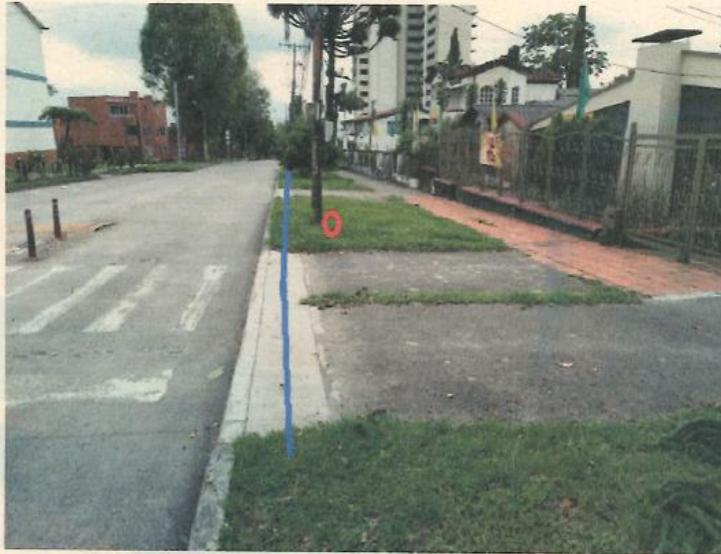
Línea Azul, tubería instalada, círculo rojo daño en la acometida.
