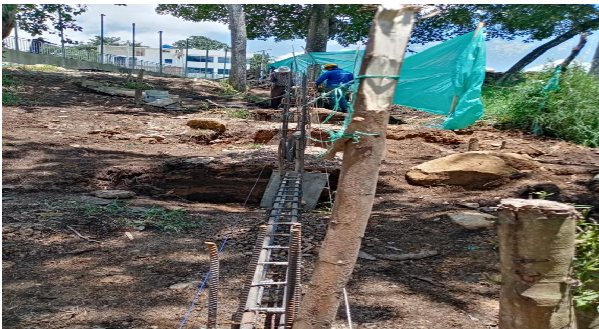
Figure 53 Instalación de estructura para vigas
