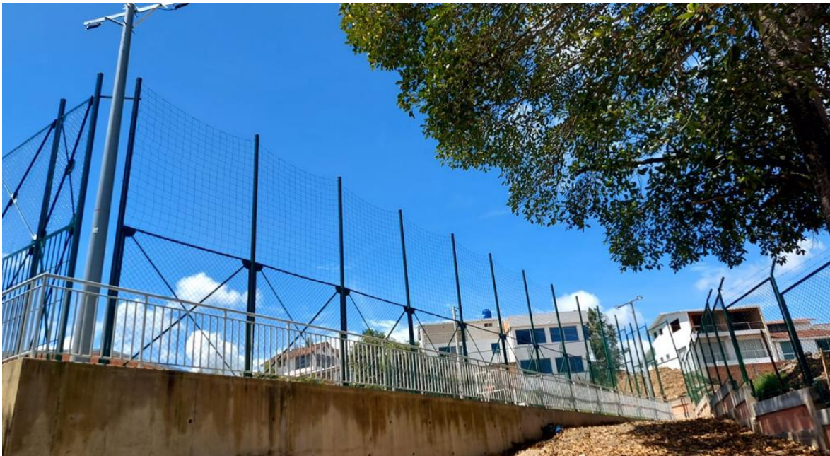
Figure 25 Cerramiento contra impacto instalado
