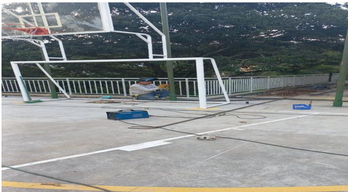
Figure 6 Marcando para instalación de cerramiento contra impacto
