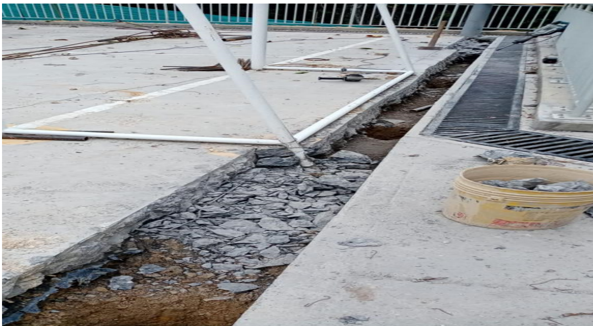
Figure 59 Demolición de placa maciza
