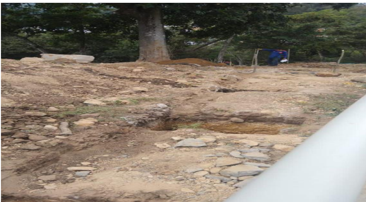
Figure 31 Excavación para zapatas
