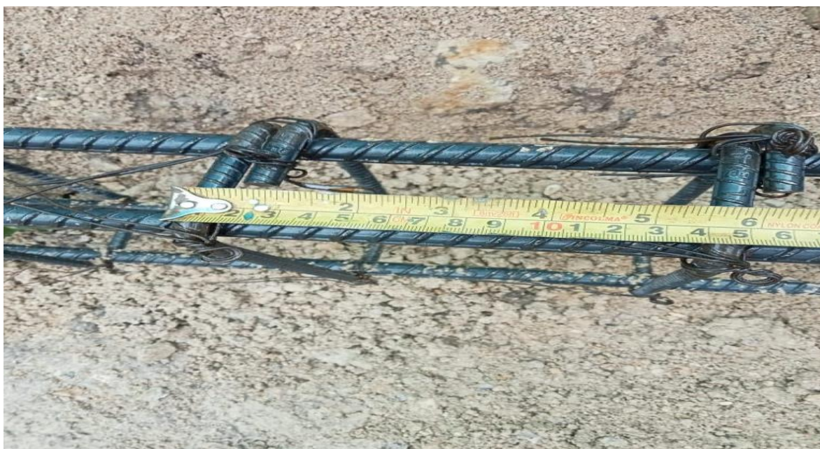
Figure 41 Distancia entre flejes
