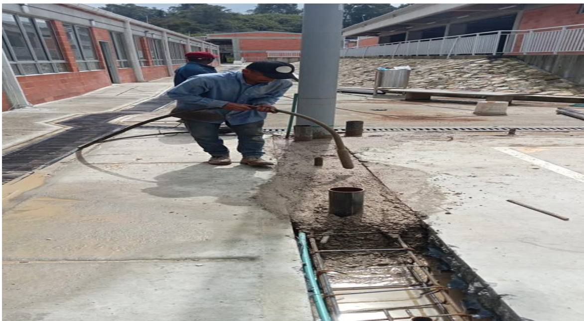
Figure 15 Fundición de concreto tremie 3000 PSI para pilotes
