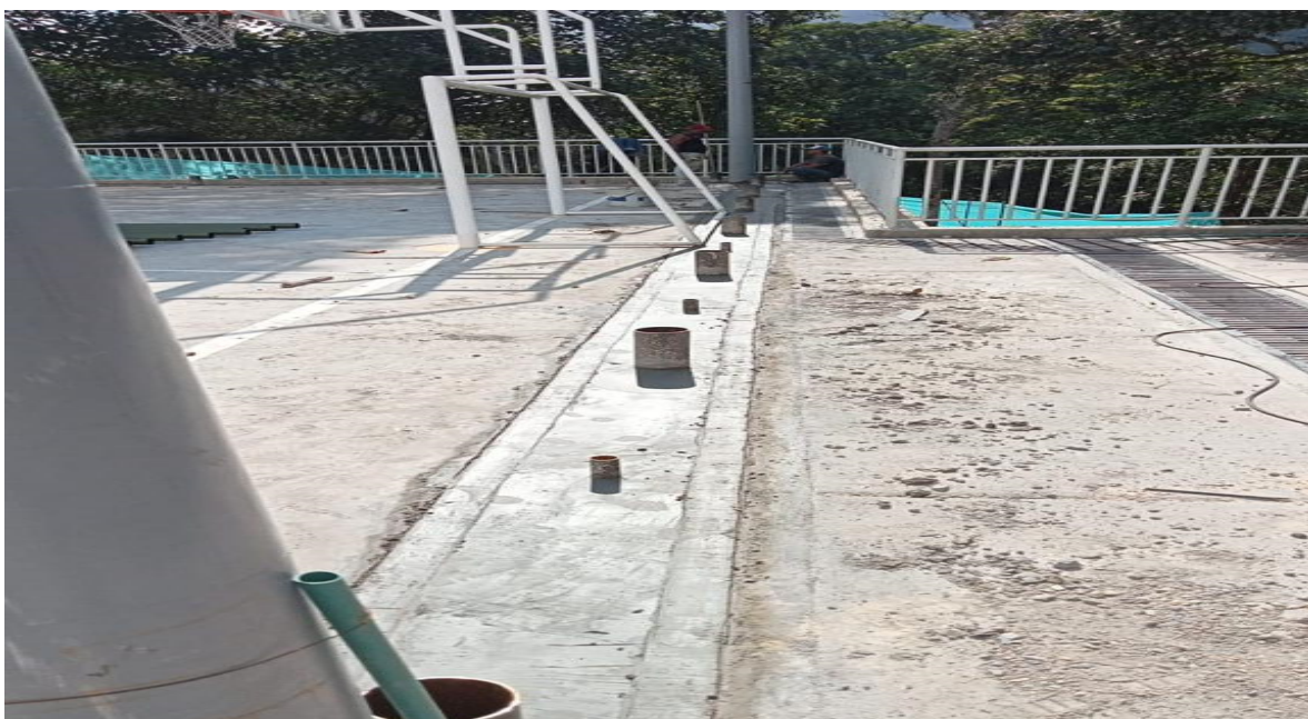
Figure 6 Viga para cerramiento contra impacto
