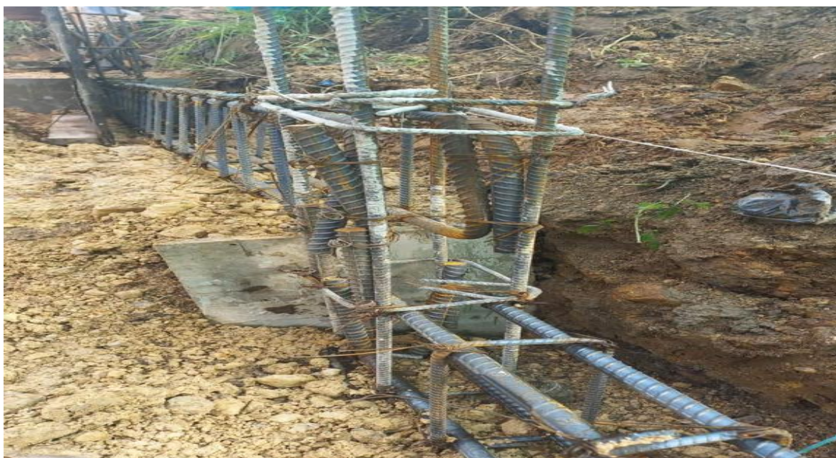
Figure 29 Estructura de viga
