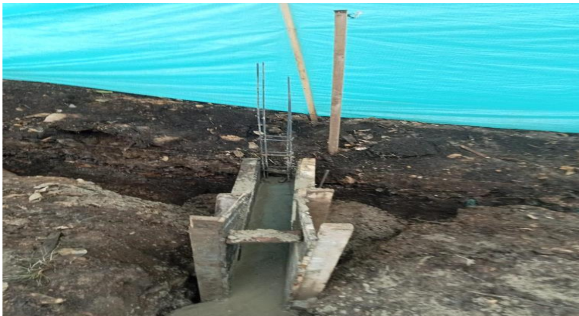
Figure 44 Viga de cimentación
