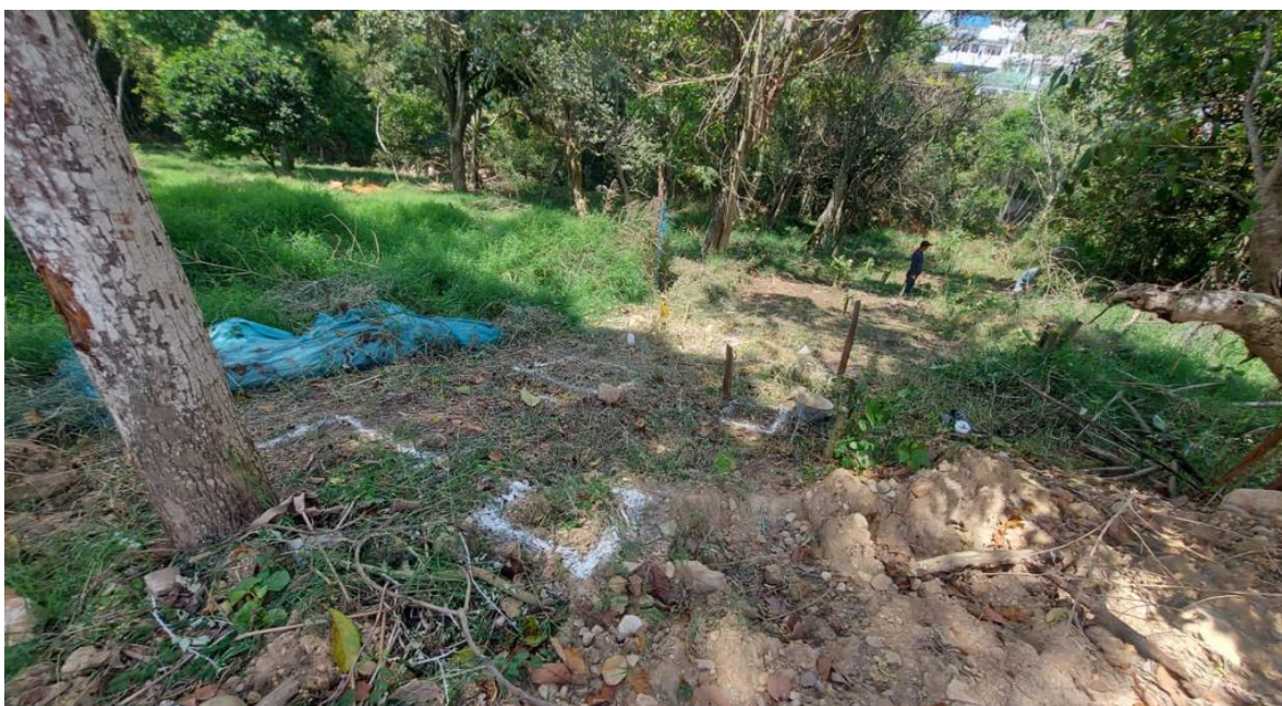
Figure 6 Replanteo de zapatas y vigas
