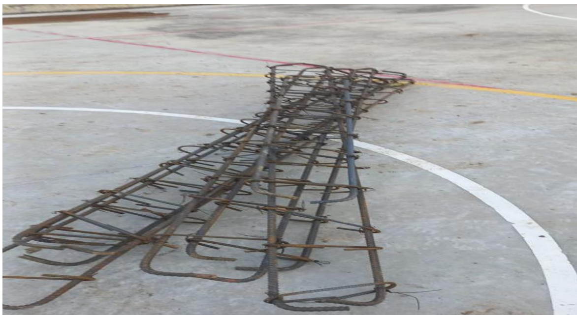
Figure 40 Estructura de viguetas
