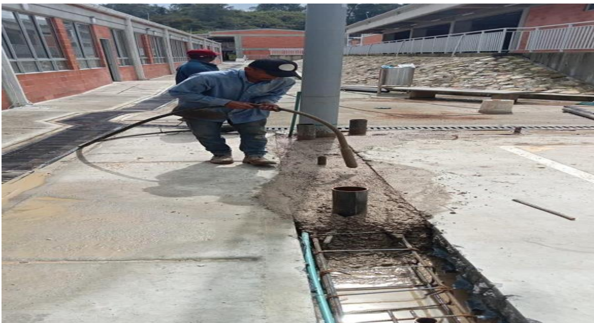
Figure 15 Fundición de concreto tremie 3000 PSI para pilotes
