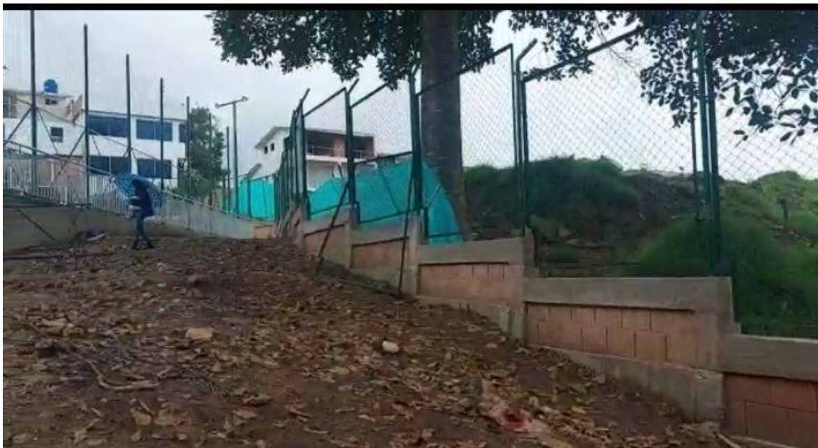
Figure 65 Instalación de malla eslabonada para cerramiento perimetral
