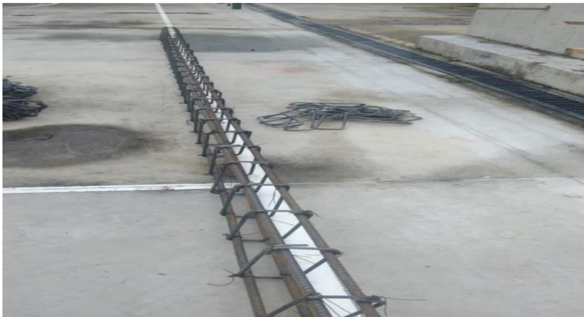
Figure 20 Estructura para viga
