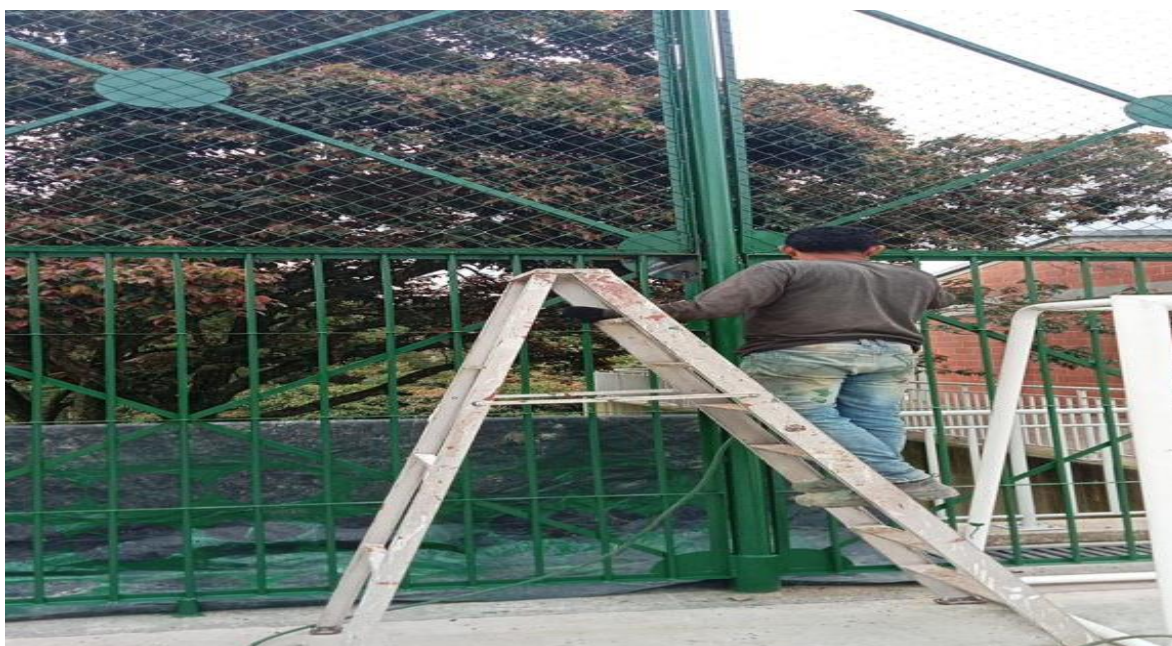
Figure 30 Aplicación de pintura en esmalte
