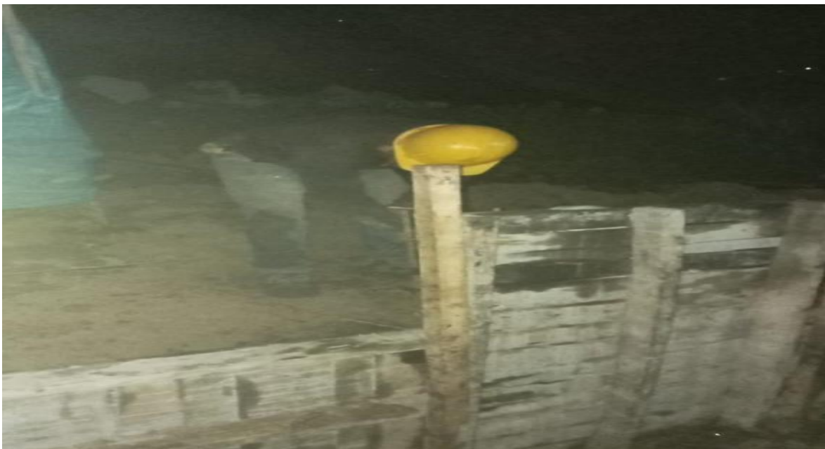
Figure 43 Relleno con recebo común
