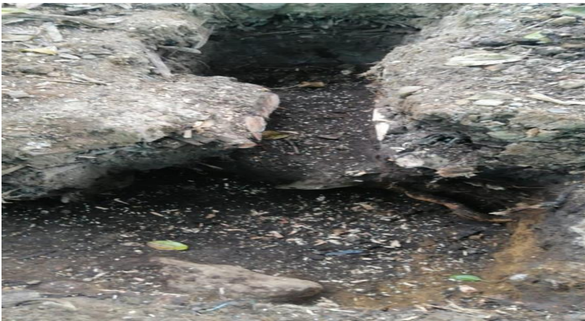
Figure 22 Extracción de roca para dado
