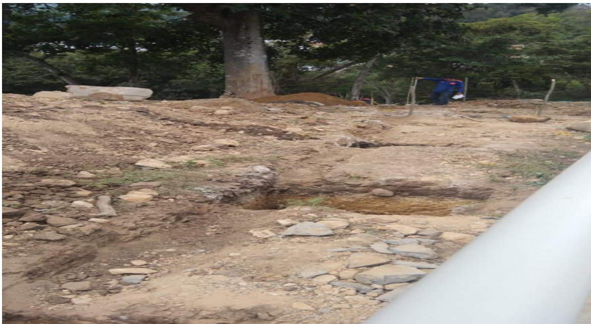
Figure 31 Excavación para zapatas
