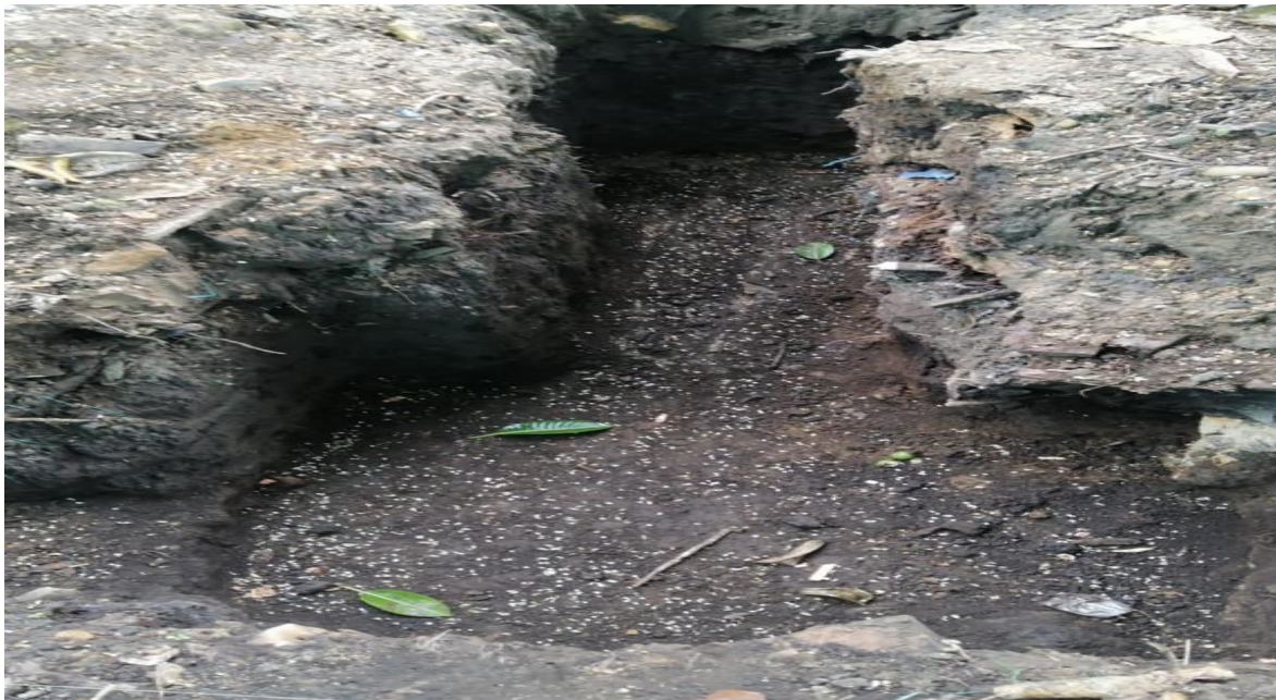
Figure 21 Excavación de dado y viga
