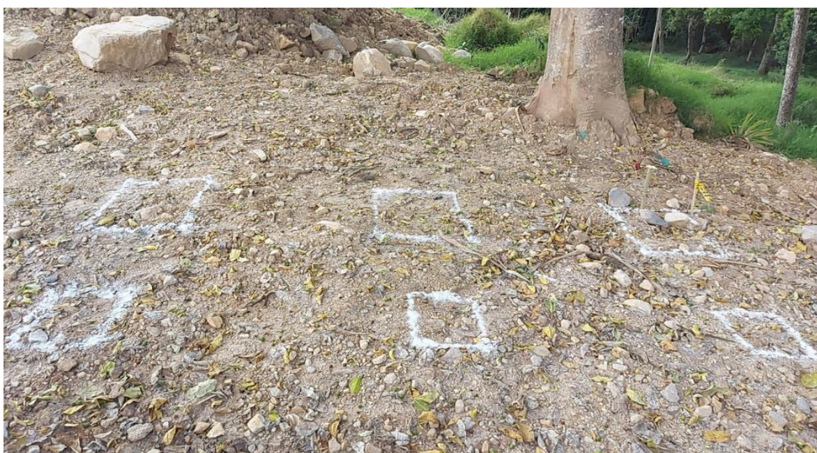
Figure 3 Replanteo de zapatas
