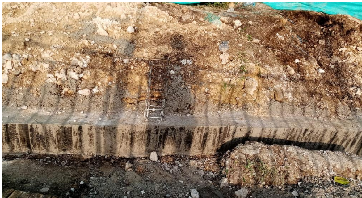
Figure 48 Viga de cimentación
