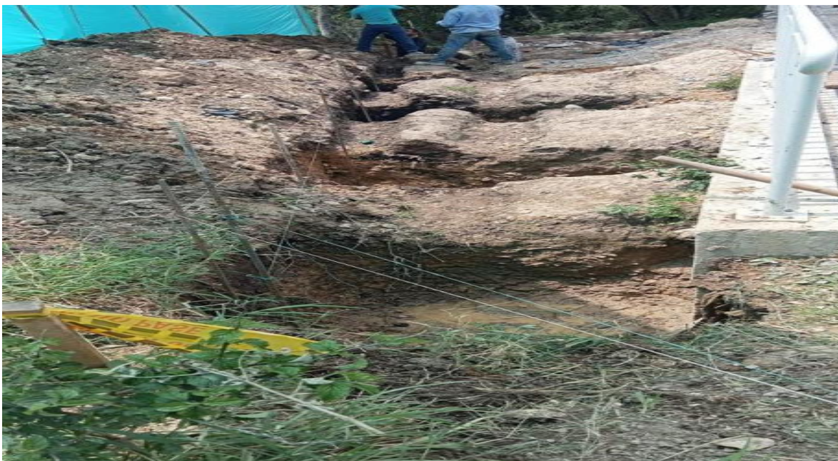
Figure 9 Excavación de dados y vigas
