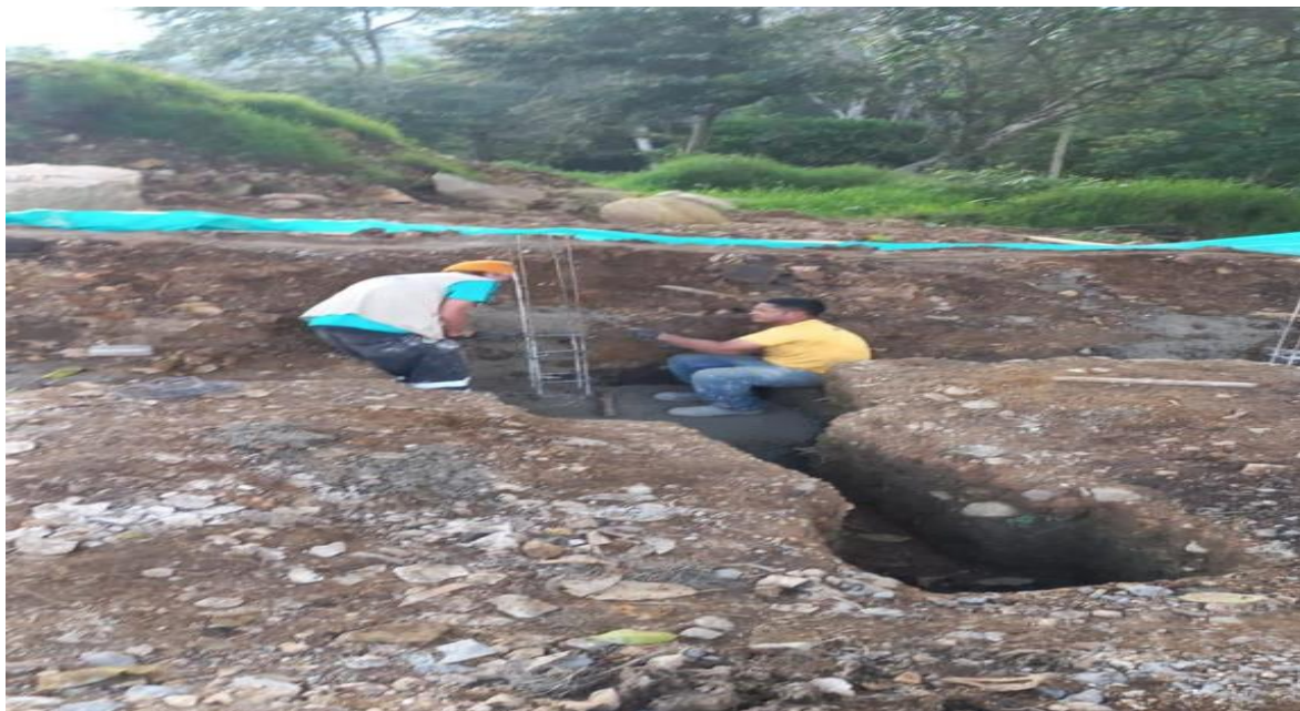
Figure 22 Elaboración de zapata
