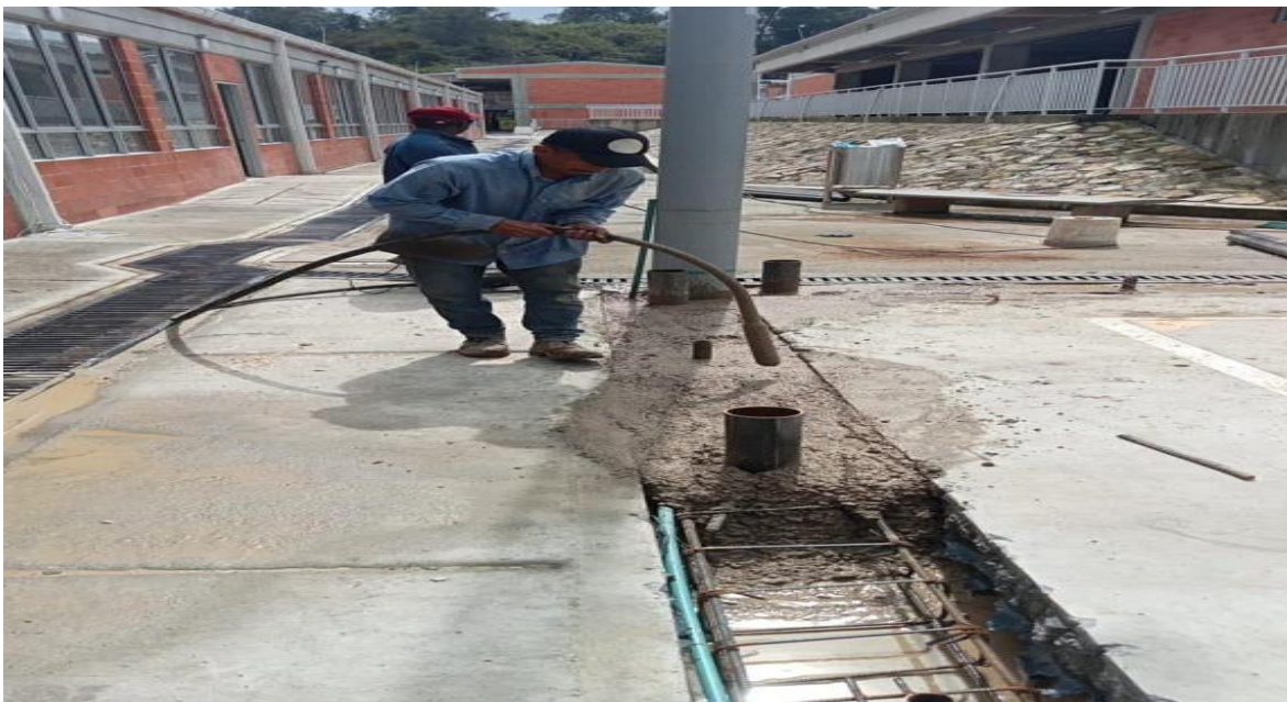
Figure 15 Fundición de concreto tremie 3000 PSI para pilotes
