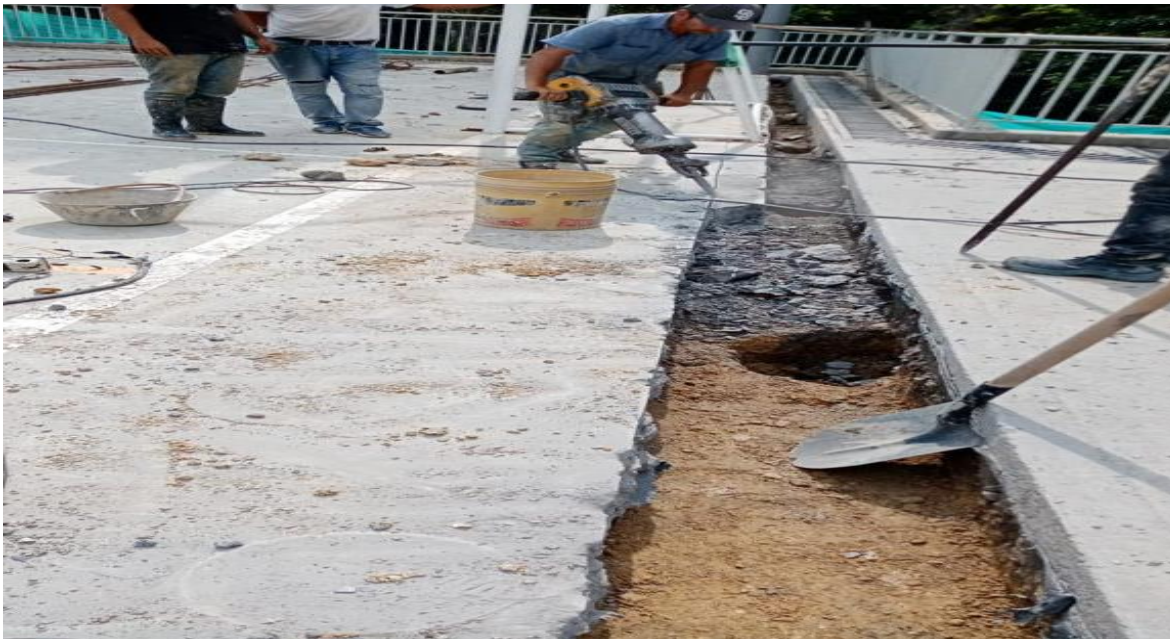
Figure 60 Demolición de placa maciza
