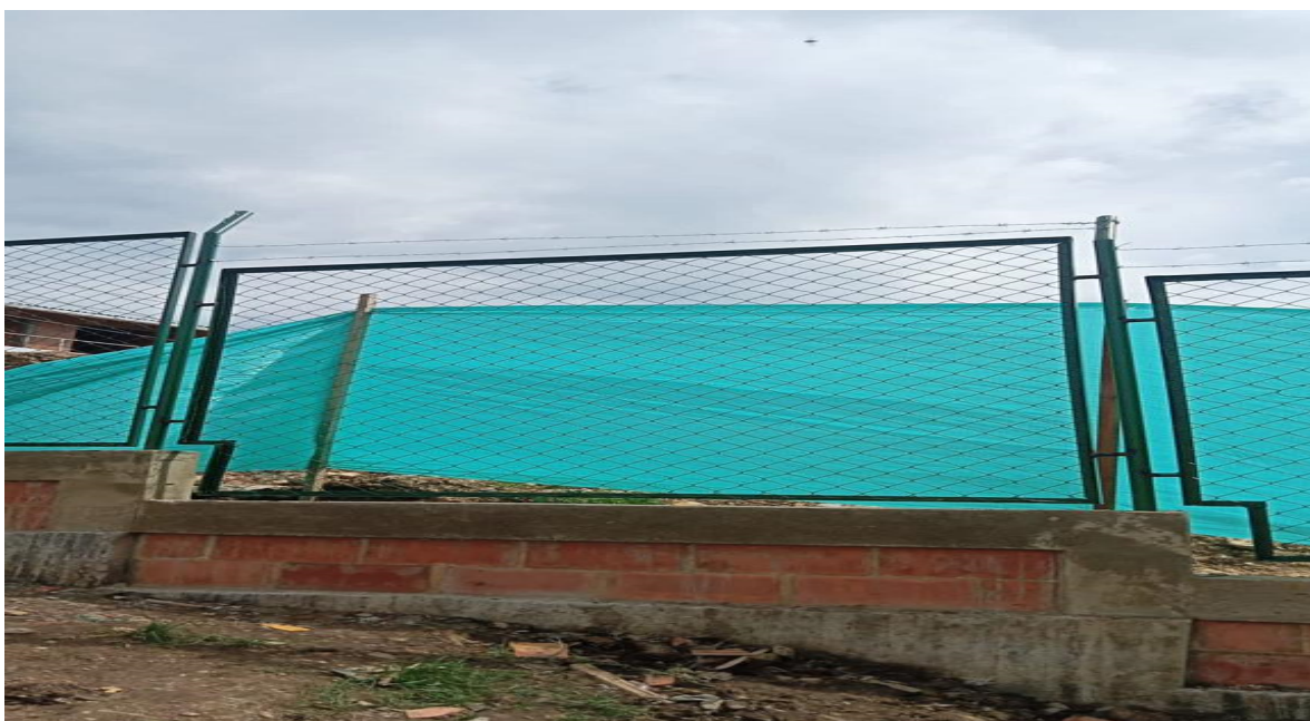
Figure 68 Instalación de alambre de púas
