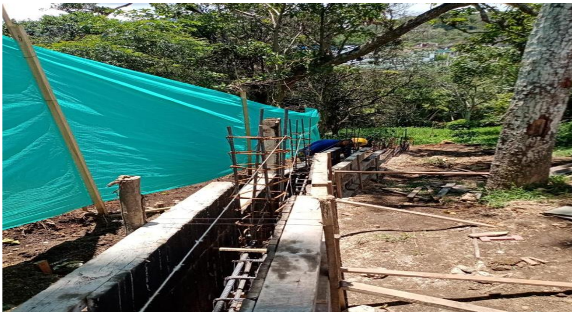
Figure 52 Estructura para vigas de cimentación y columnetas
