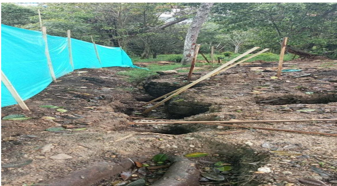
Figure 28 Excavación de vigas y dados
