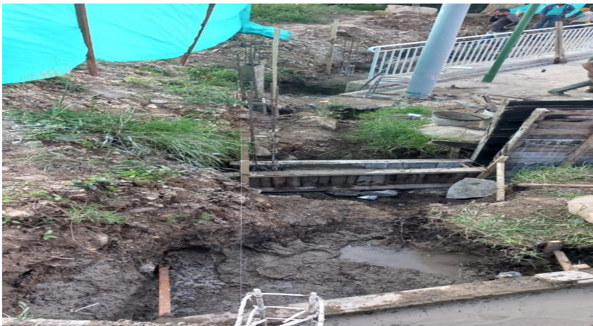
Figure 31 Instalación de formaleta
