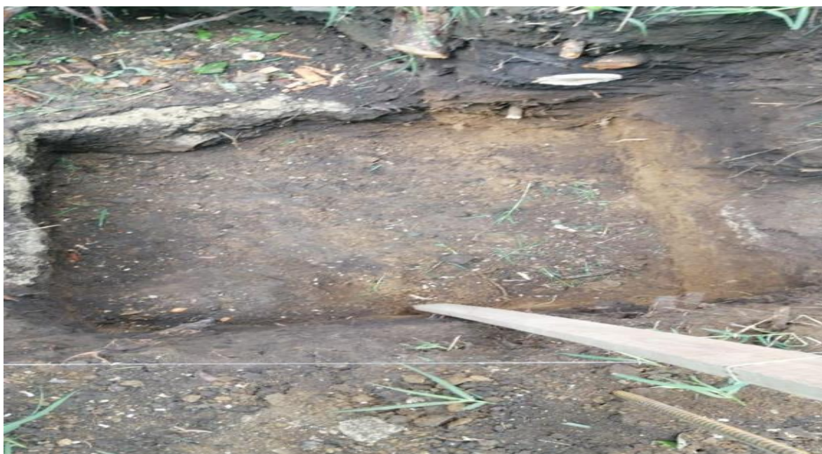
Figure 19 Excavación de dado
