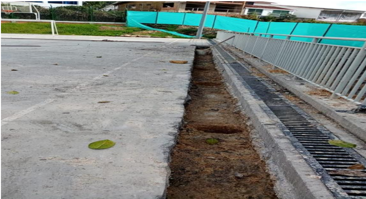
Figure 58 Demolición de placa maciza
