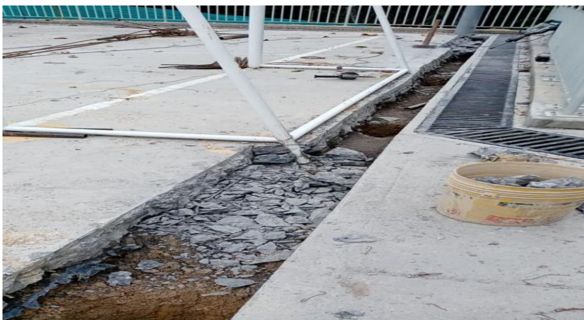
Figure 59 Demolición de placa maciza
