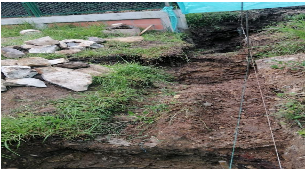
Figure 24 Excavación para viga
