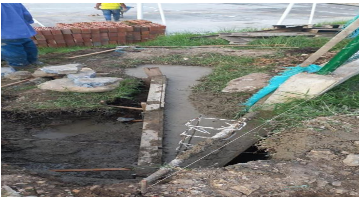
Figure 39 Fundida de zapata y viga de cimentación
