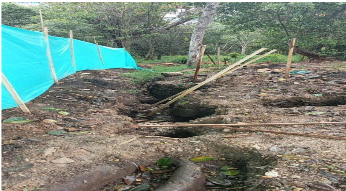
Figure 28 Excavación de vigas y dados
