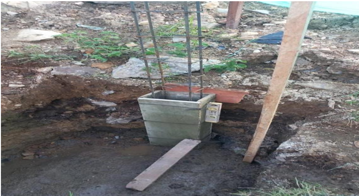
Figure 34 Construcción de columneta
