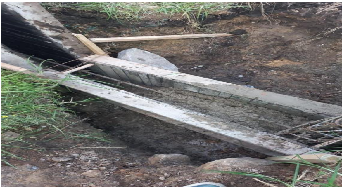
Figure 35 Fundida de viga de cimentación
