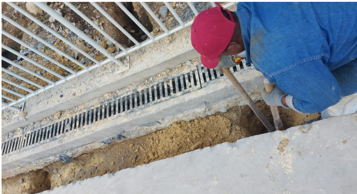
Figure 70 Pre huecos para pilotes
