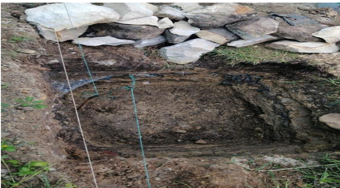
Figure 27 Excavación de zapata
