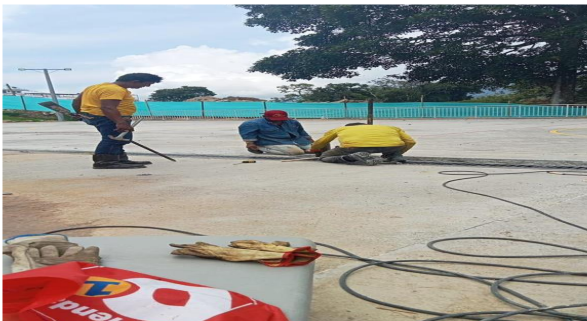
Figure 55 Demolición de placa maciza
