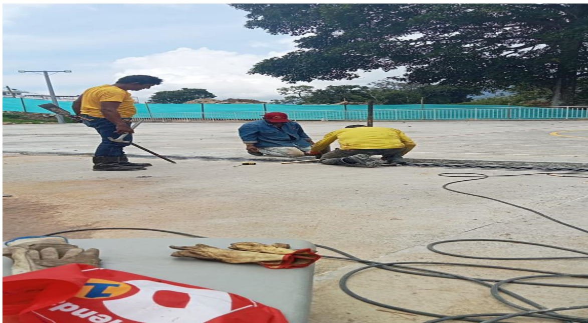
Figure 55 Demolición de placa maciza
