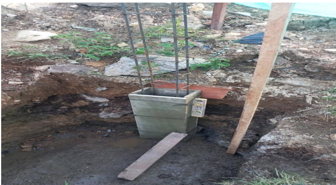
Figure 34 Construcción de columneta
