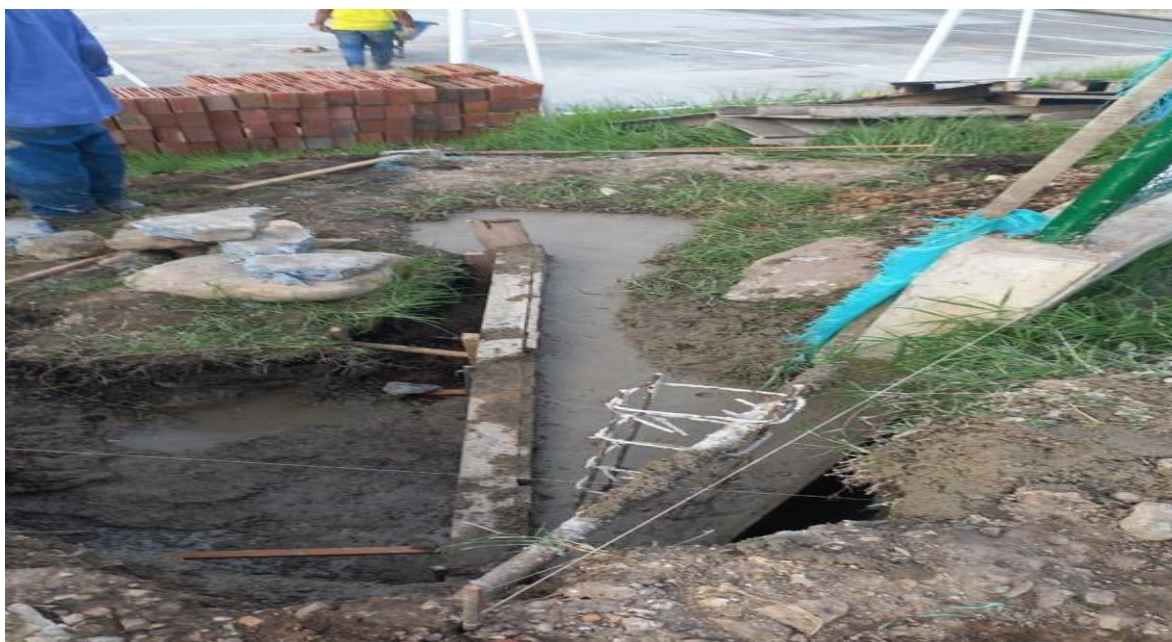
Figure 39 Fundida de zapata y viga de cimentación
