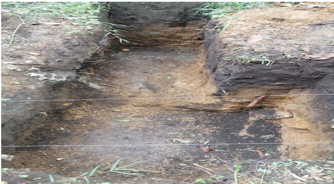
Figure 17 Excavación de dado
