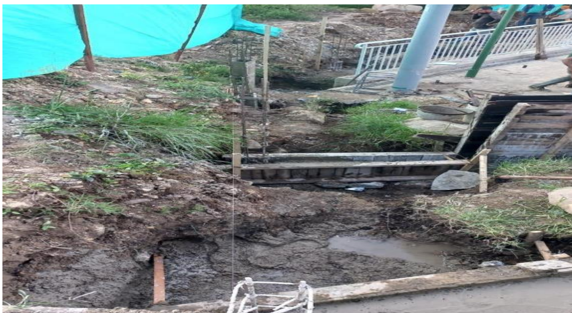
Figure 31 Instalación de formaleta
