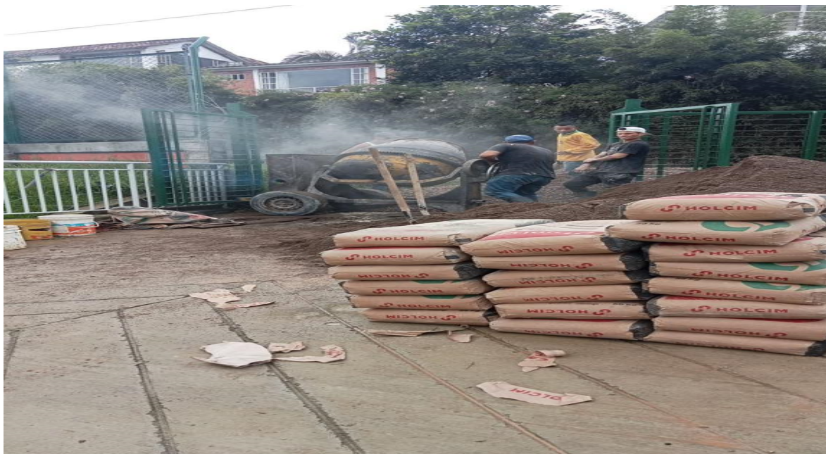
Figure 9 Mezcla para fundir zapatas
