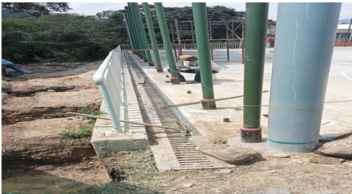
Figure 3 Instalación de cerramiento contra impacto
