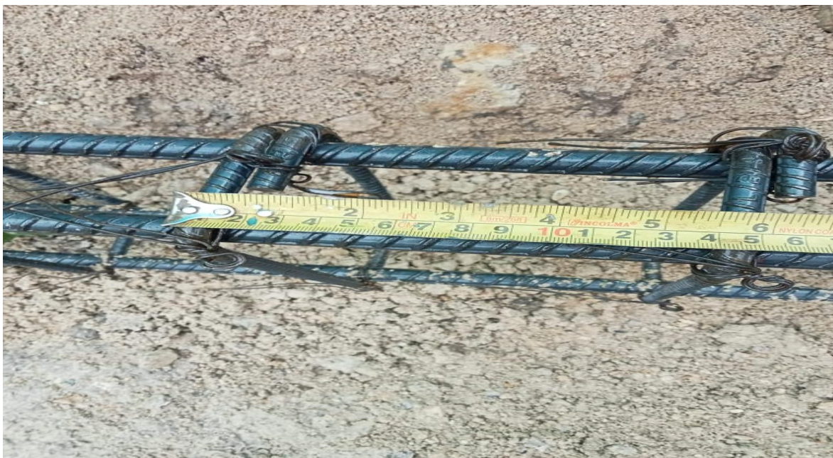
Figure 41 Distancia entre flejes
