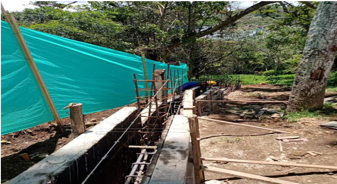
Figure 52 Estructura para vigas de cimentación y columnetas
