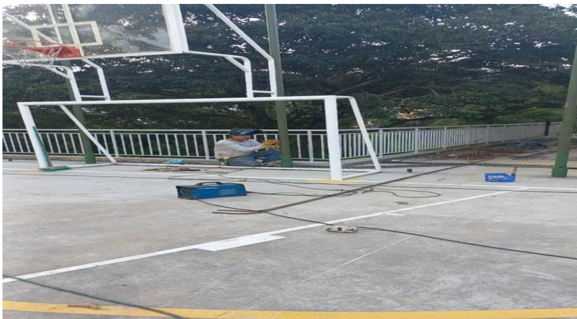
Figure 6 Marcando para instalación de cerramiento contra impacto
