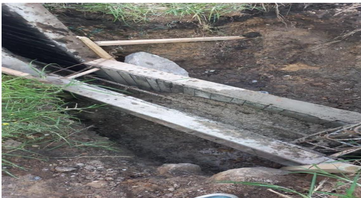
Figure 35 Fundida de viga de cimentación
