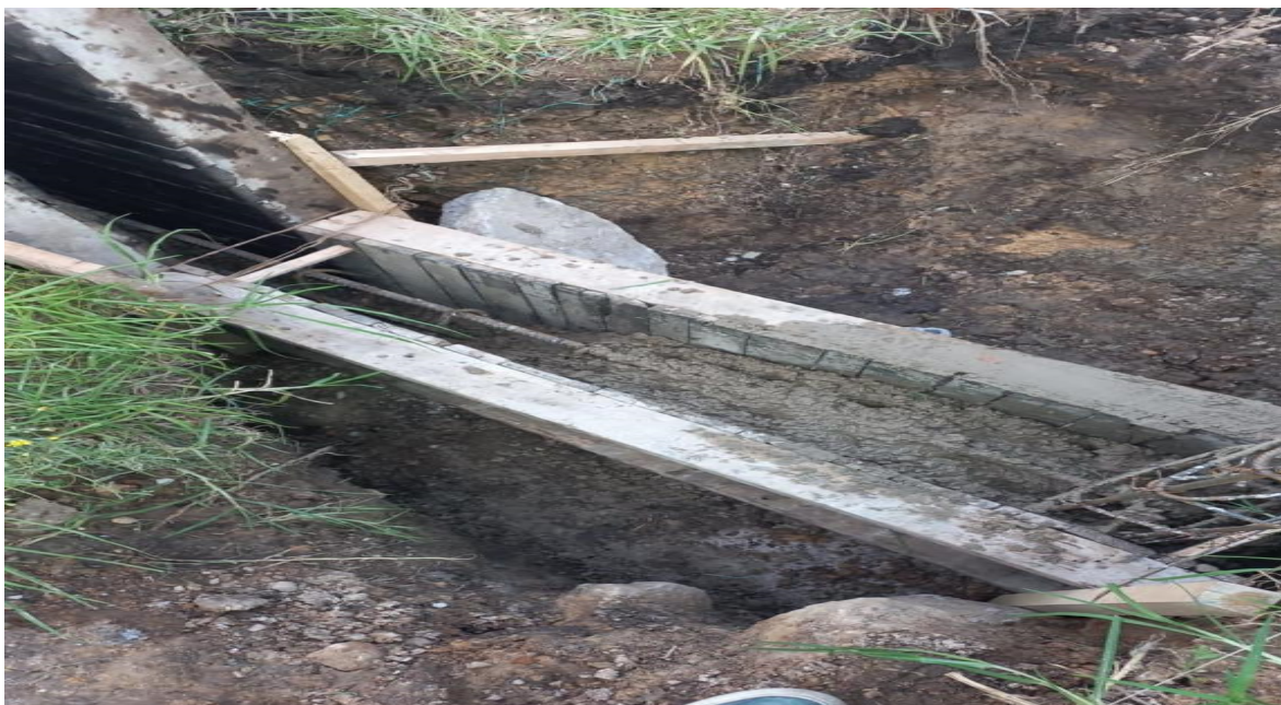
Figure 35 Fundida de viga de cimentación
