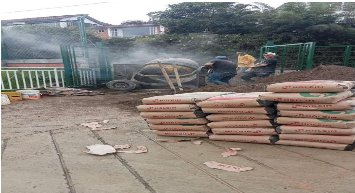
Figure 9 Mezcla para fundir zapatas
