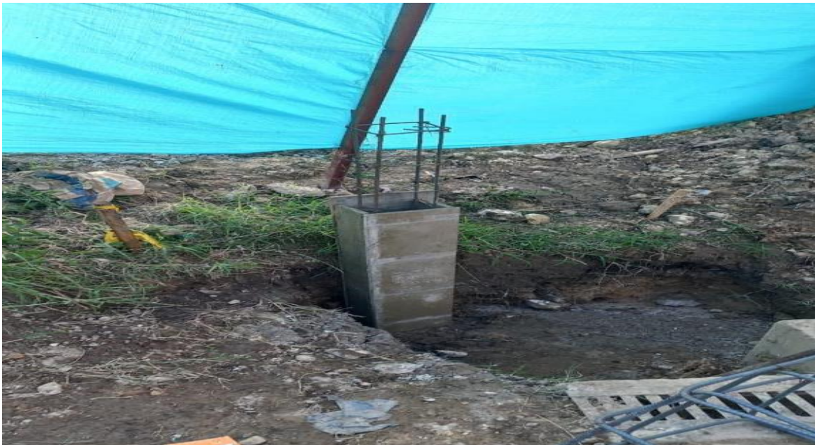
Figure 36 Fundida de columneta
