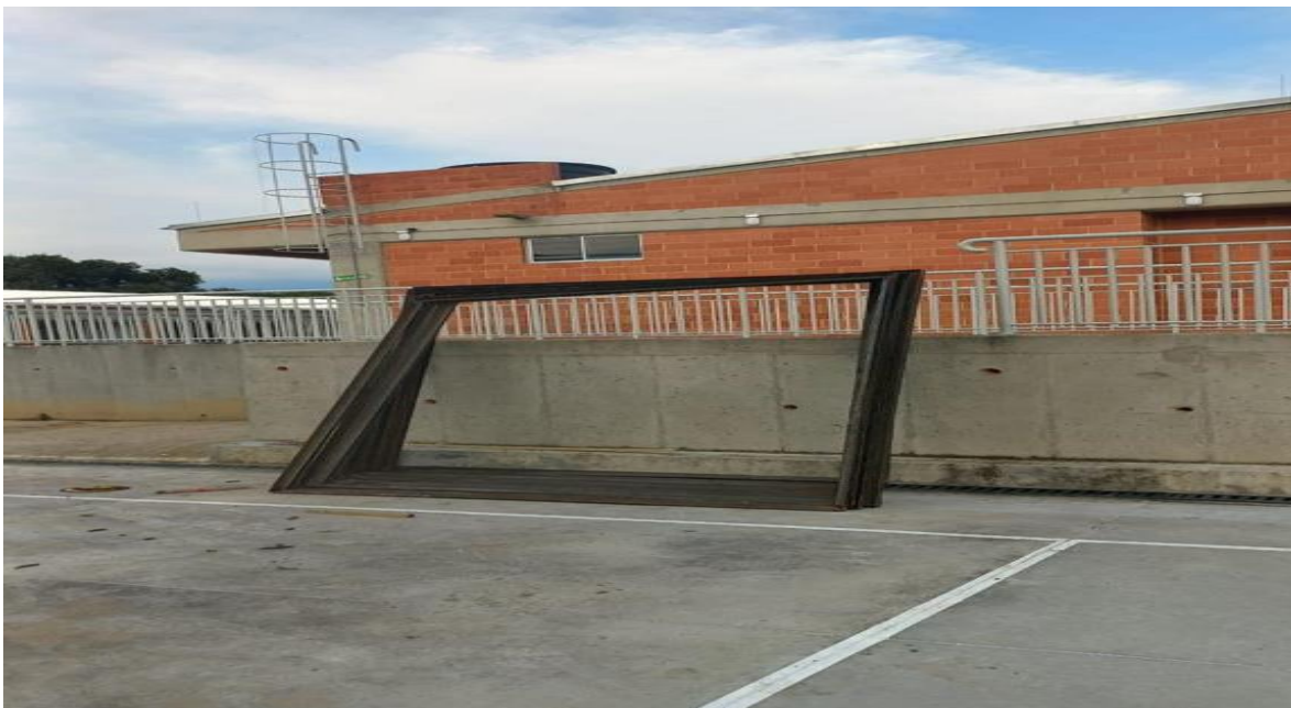
Figure 8 Estructura en ángulos para cerramiento contra impacto
