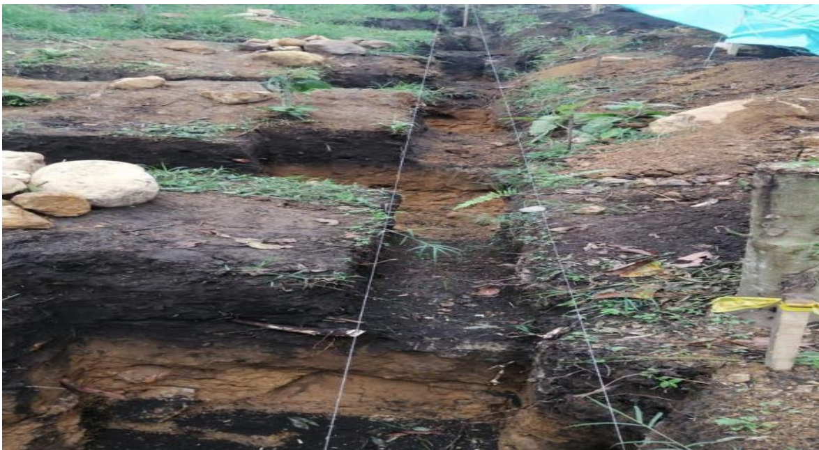
Figure 16 Excavación de vigas
