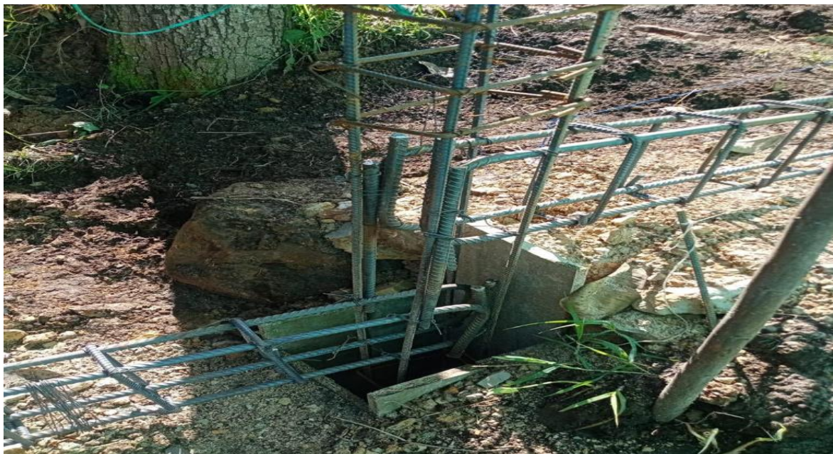
Figure 54 Estructura para vigas
