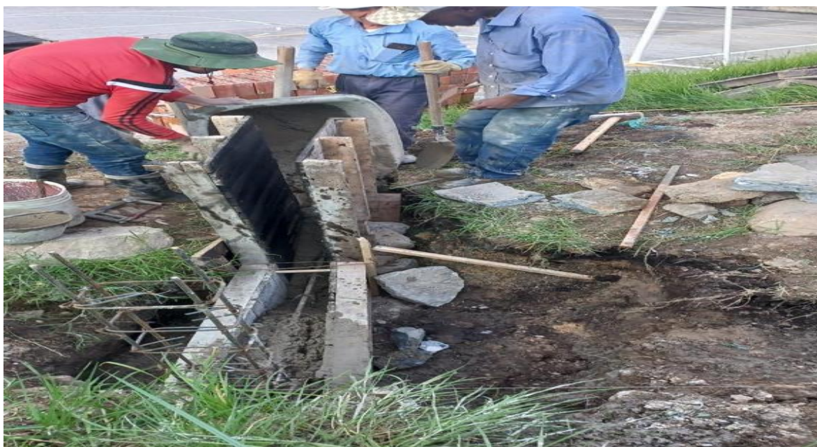
Figure 27 Fundición de viga de cimentación
