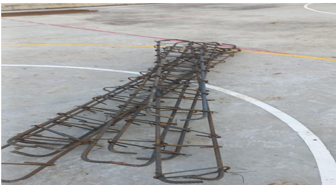
Figure 40 Estructura de viguetas
