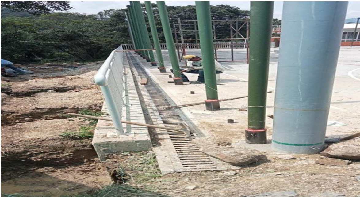
Figure 3 Instalación de cerramiento contra impacto
