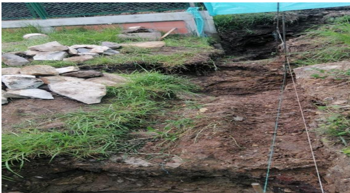
Figure 24 Excavación para viga
