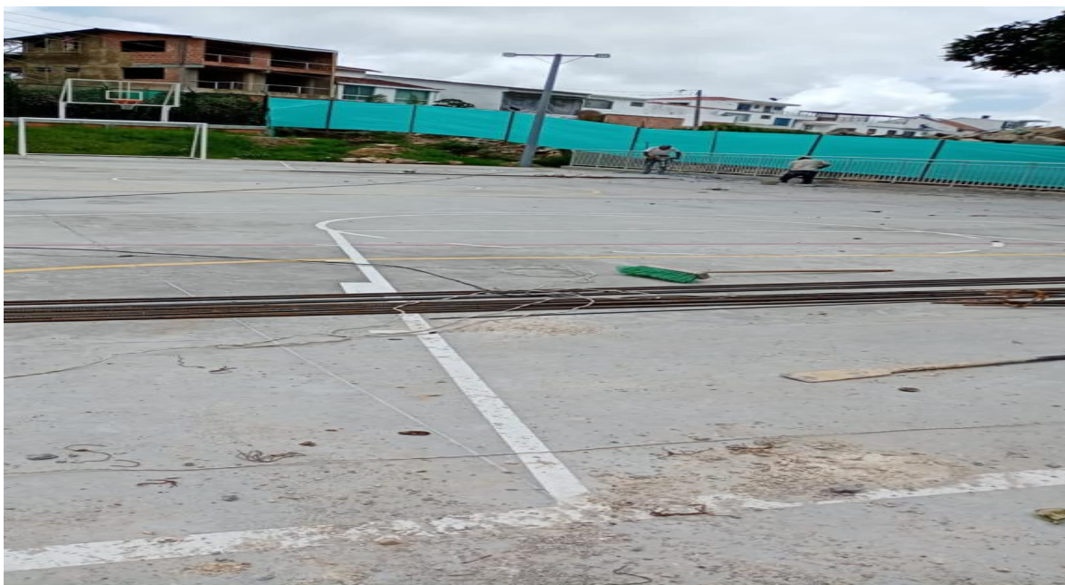
Figure 7 Demolición de placa maciza
