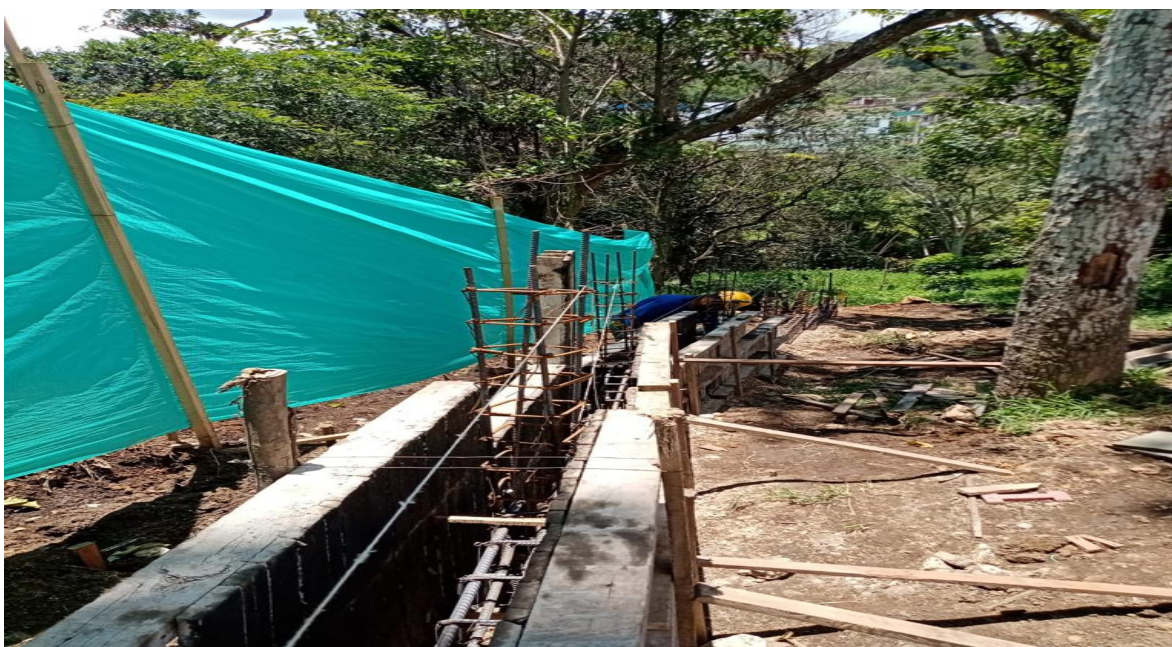
Figure 52 Estructura para vigas de cimentación y columnetas
