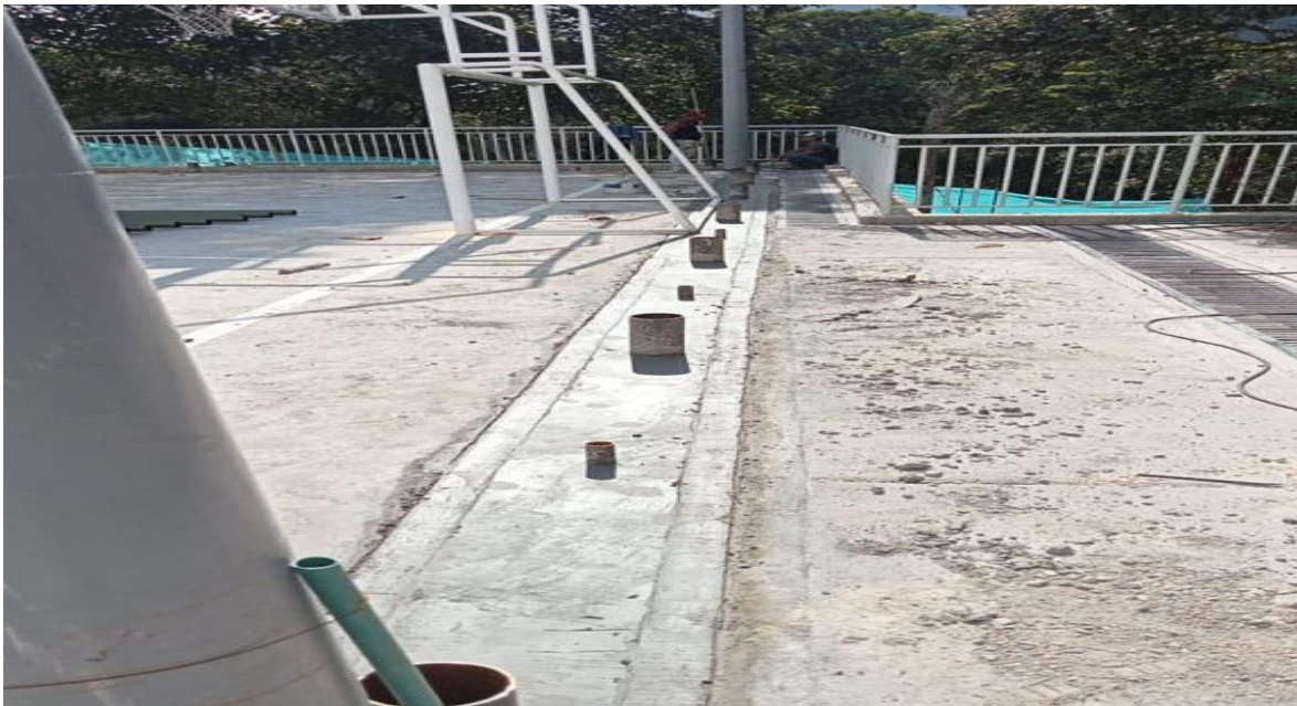
Figure 6 Viga para cerramiento contra impacto
