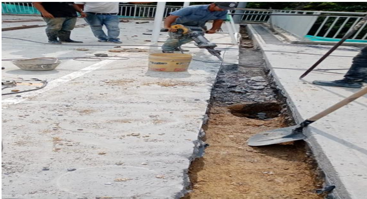
Figure 60 Demolición de placa maciza
