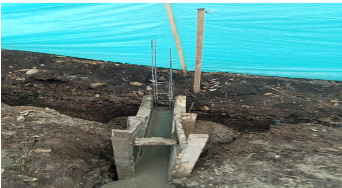
Figure 44 Viga de cimentación
