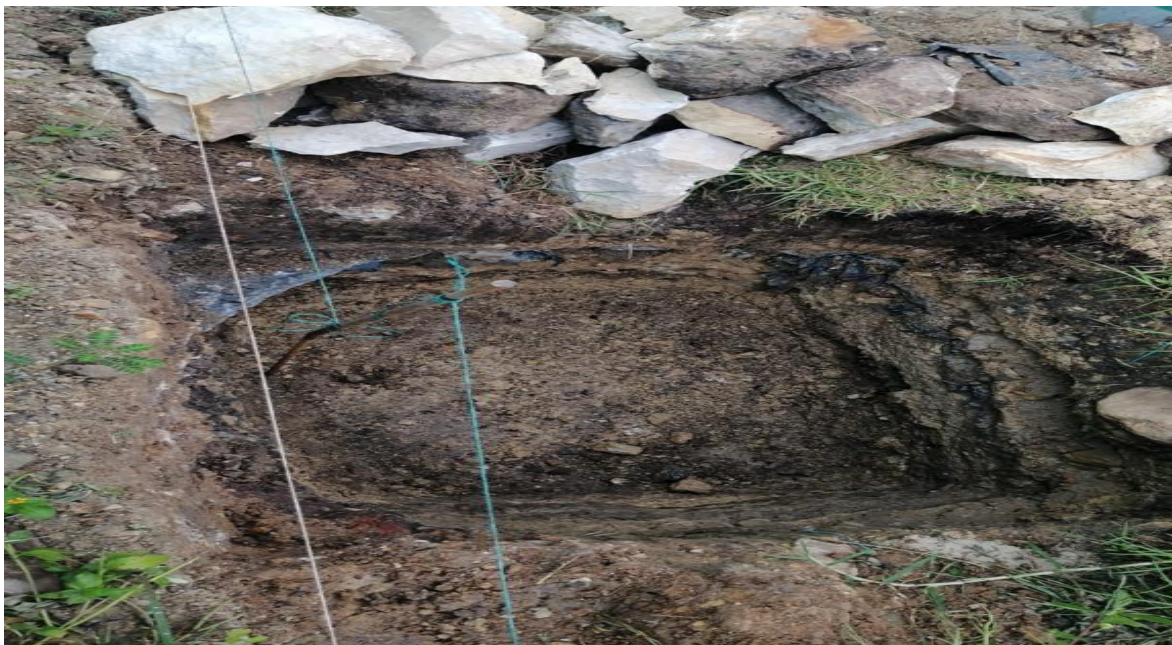
Figure 27 Excavación de zapata
