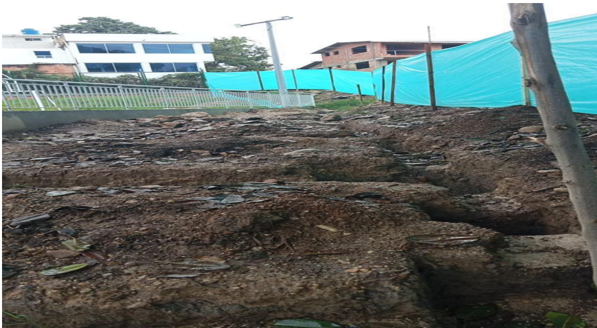
Figure 29 Excavación de vigas
