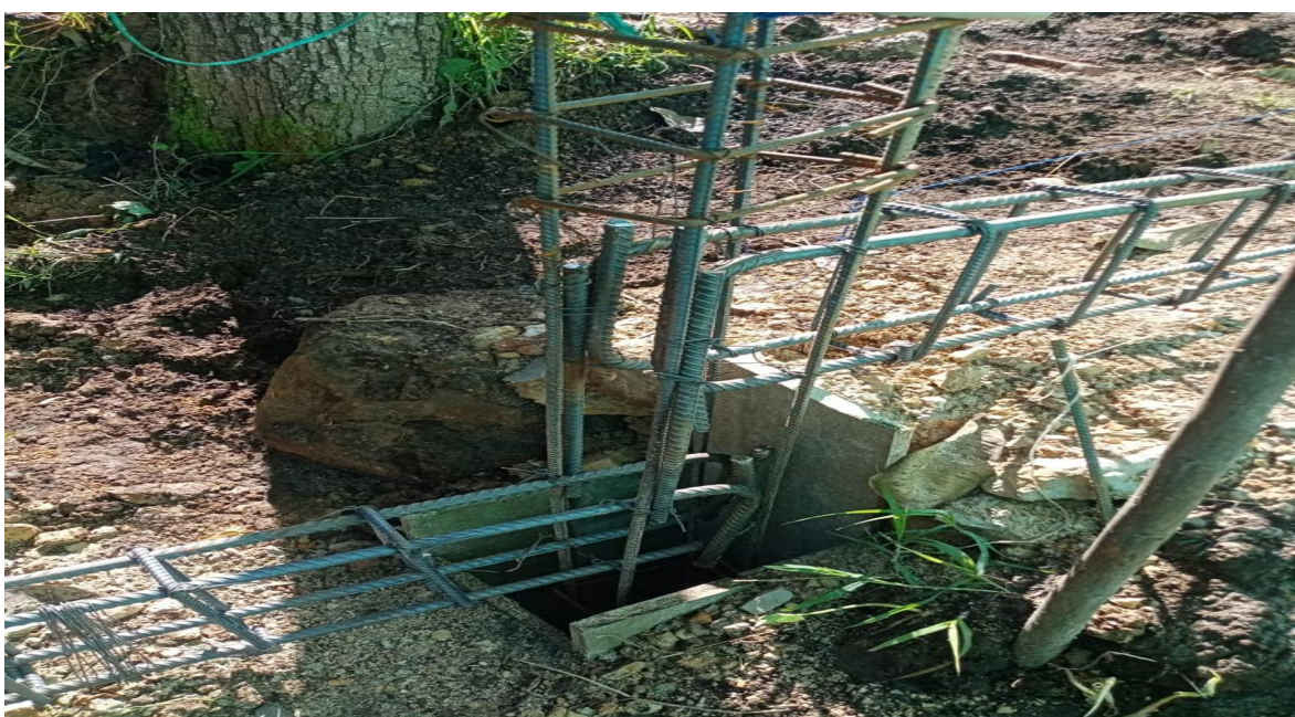
Figure 54 Estructura para vigas
