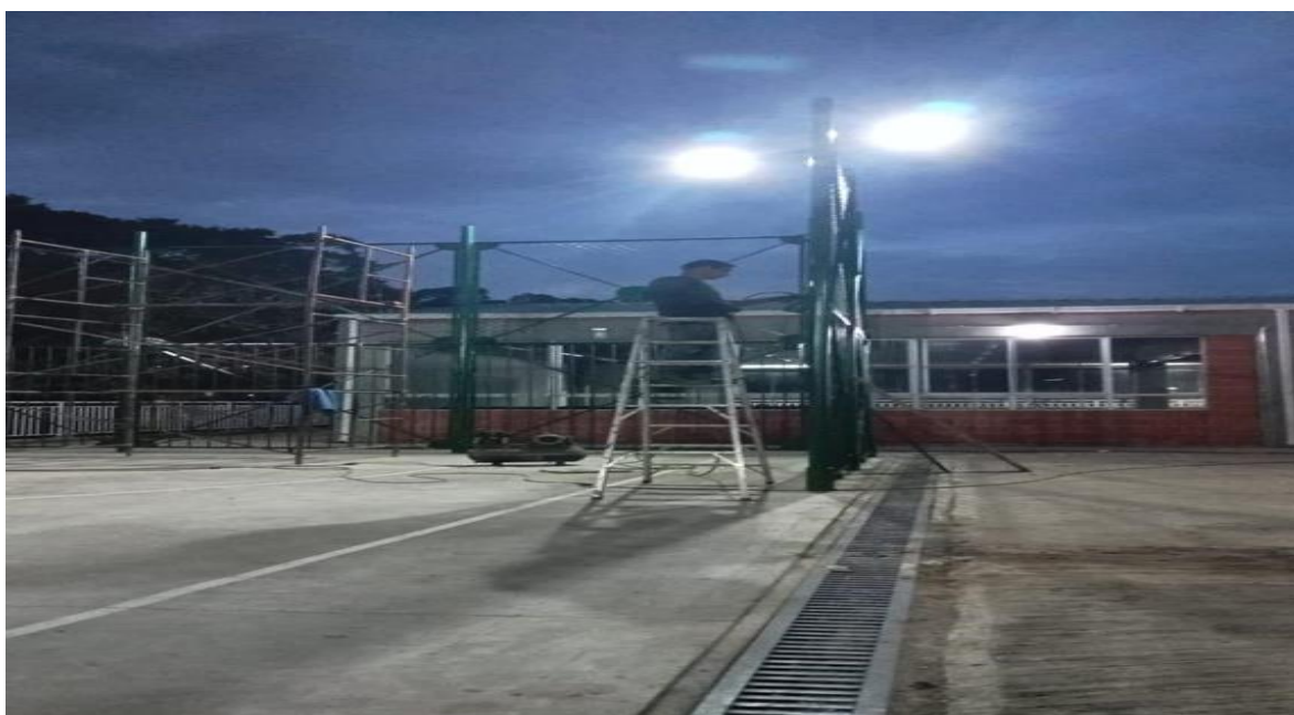
Figure 28 Aplicación de pintura en malla
