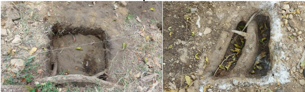
Imagen 2. Raíces identificadas en los puntos de localización de zapatas
