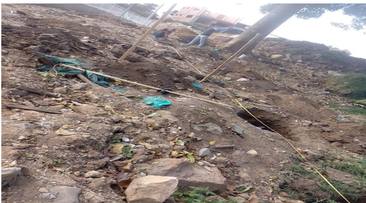
Figure 32 Replanteo de vigas
