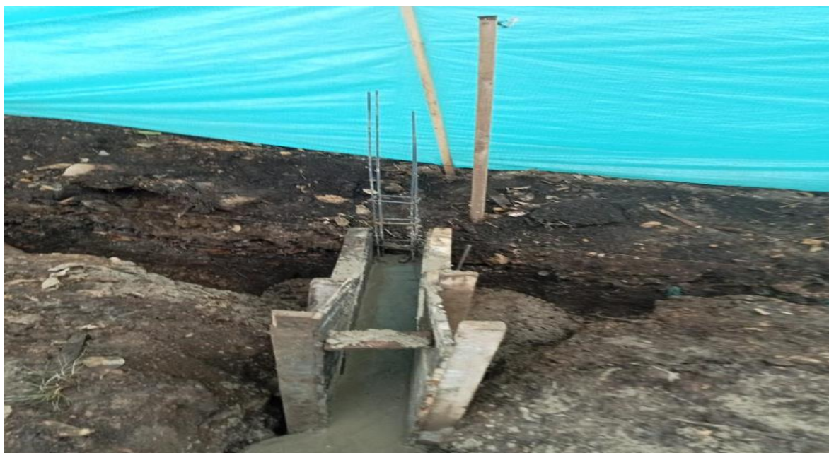
Figure 44 Viga de cimentación
