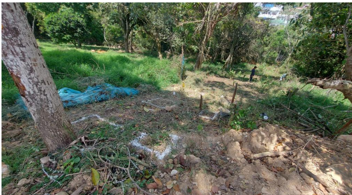
Figure 6 Replanteo de zapatas y vigas
