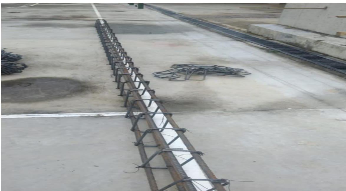
Figure 20 Estructura para viga
