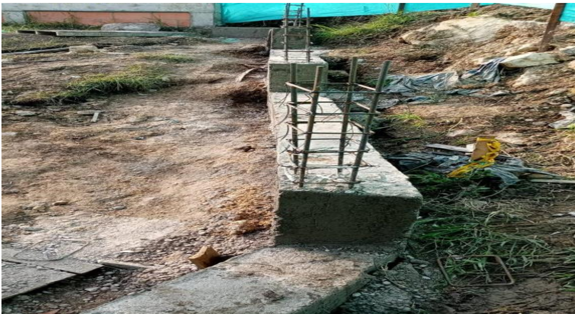
Figure 51 Relleno con recebo común
