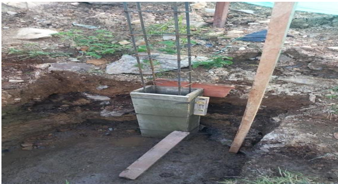
Figure 34 Construcción de columneta
