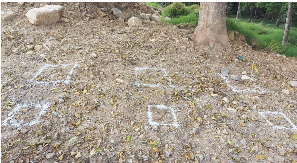
Figure 3 Replanteo de zapatas
