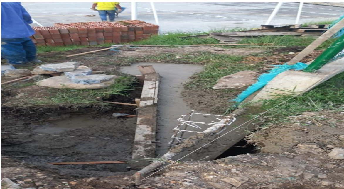
Figure 39 Fundida de zapata y viga de cimentación
