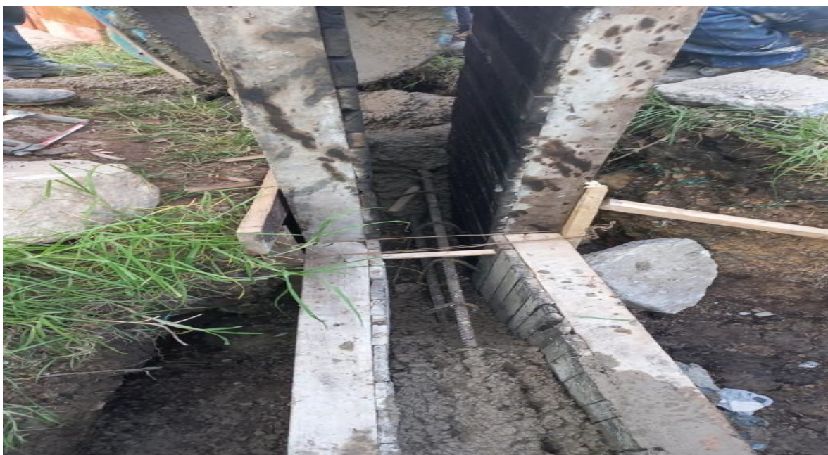
Figure 26 Viga de cimentación
