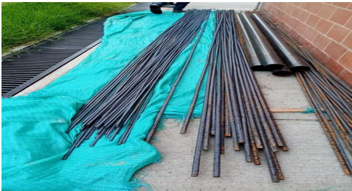
Figure 61 Almacenamiento de acero de refuerzo
