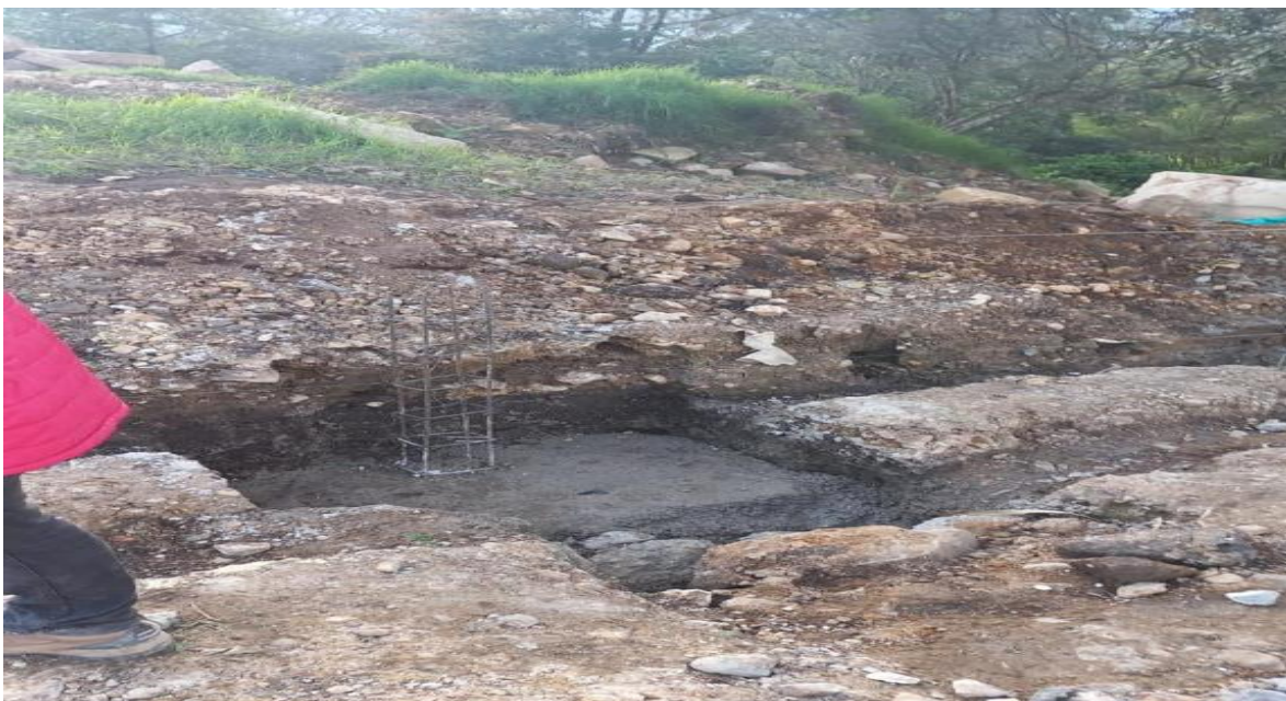
Figure 33 Construcción de zapata
