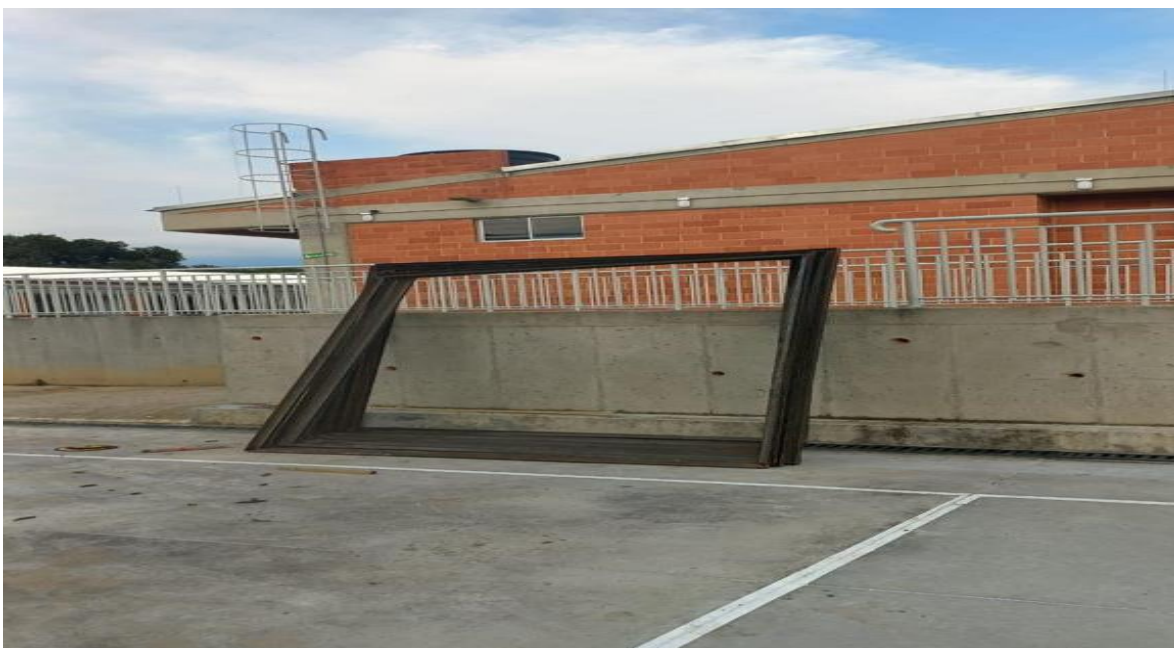
Figure 8 Estructura en ángulos para cerramiento contra impacto
