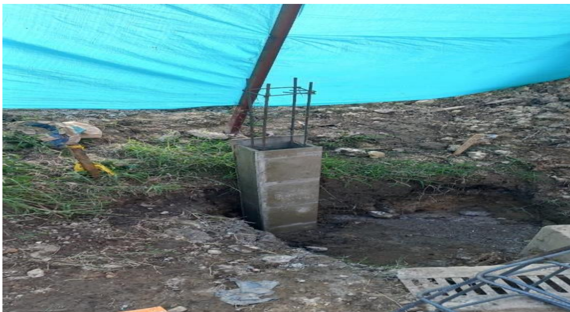
Figure 36 Fundida de columneta
