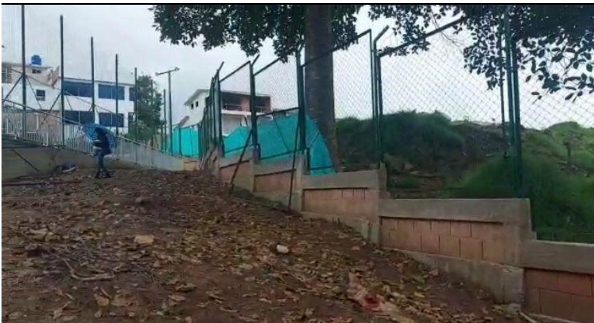
Figure 65 Instalación de malla eslabonada para cerramiento perimetral
