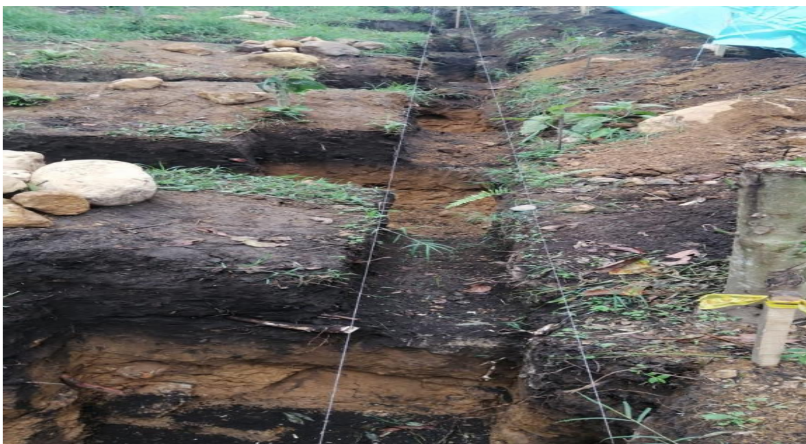
Figure 16 Excavación de vigas
