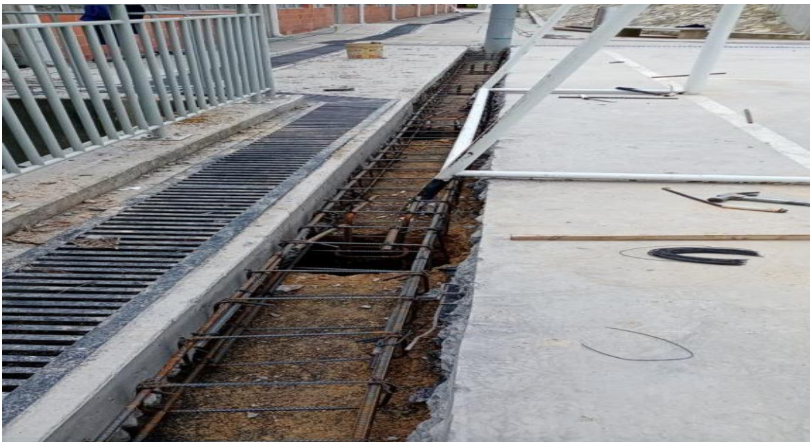
Figure 57 Instalación de estructura para viga de cerramiento contra impacto
