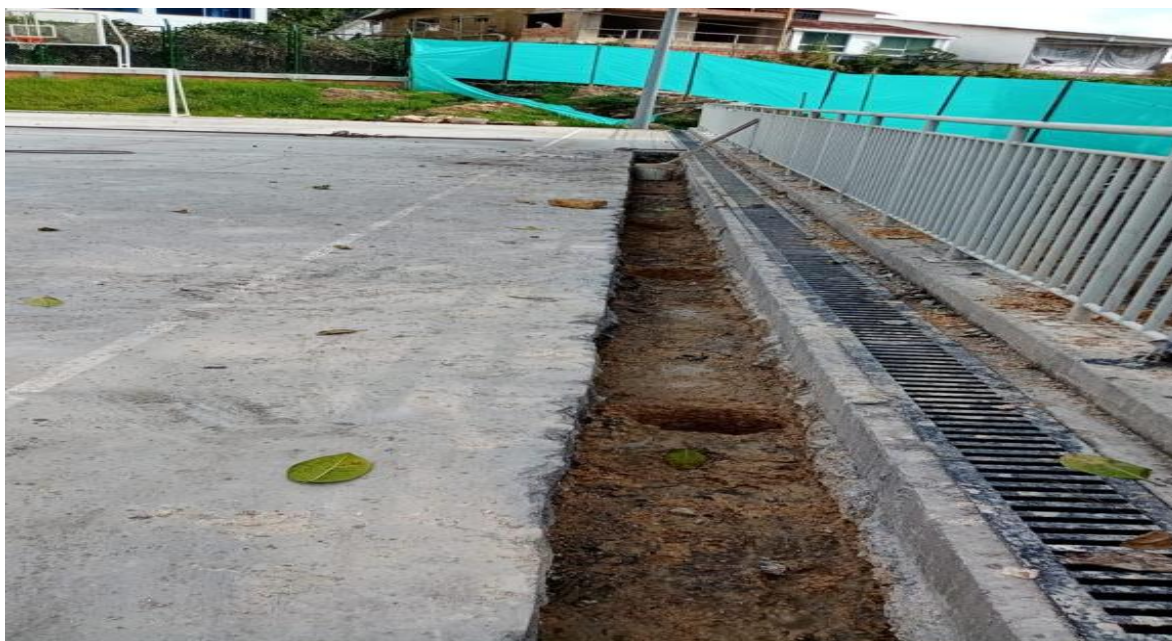
Figure 58 Demolición de placa maciza
