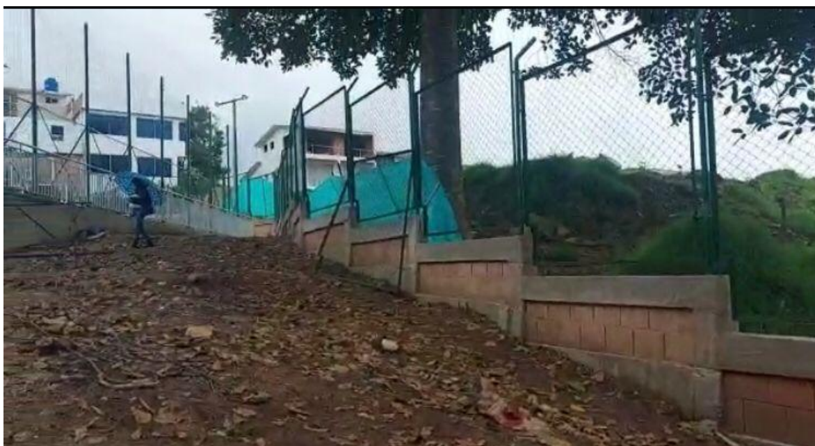
Figure 65 Instalación de malla eslabonada para cerramiento perimetral
