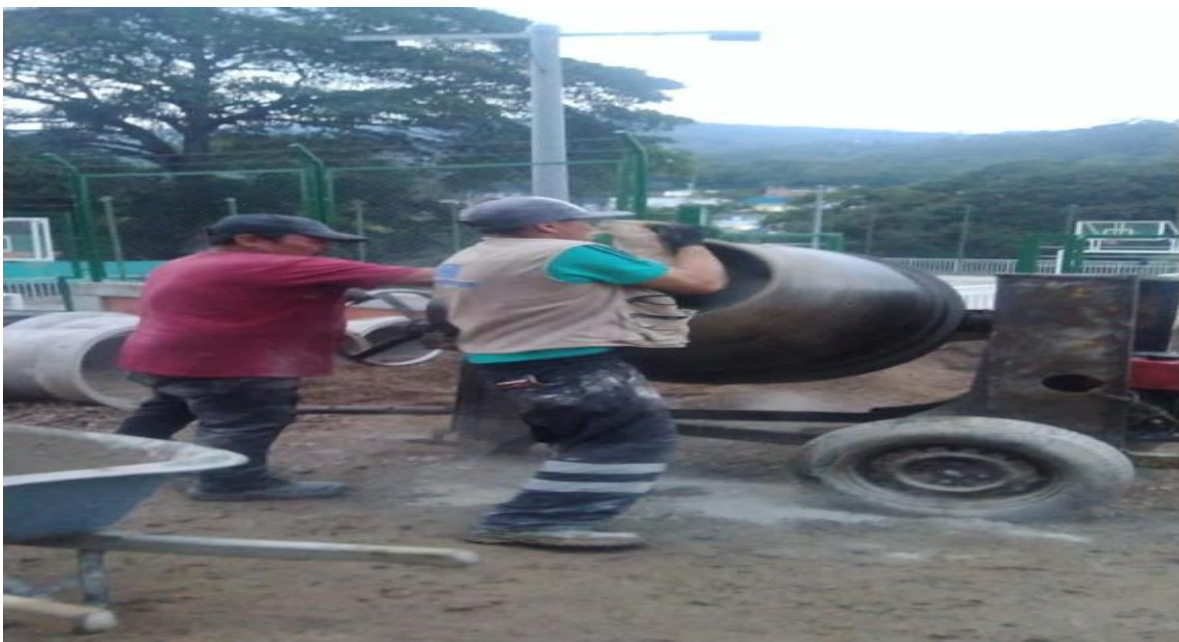
Figure 17 Elaboración de mezcla
