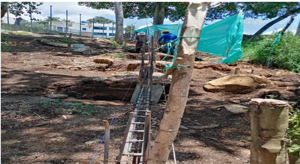
Figure 53 Instalación de estructura para vigas
