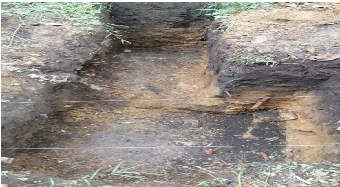
Figure 17 Excavación de dado
