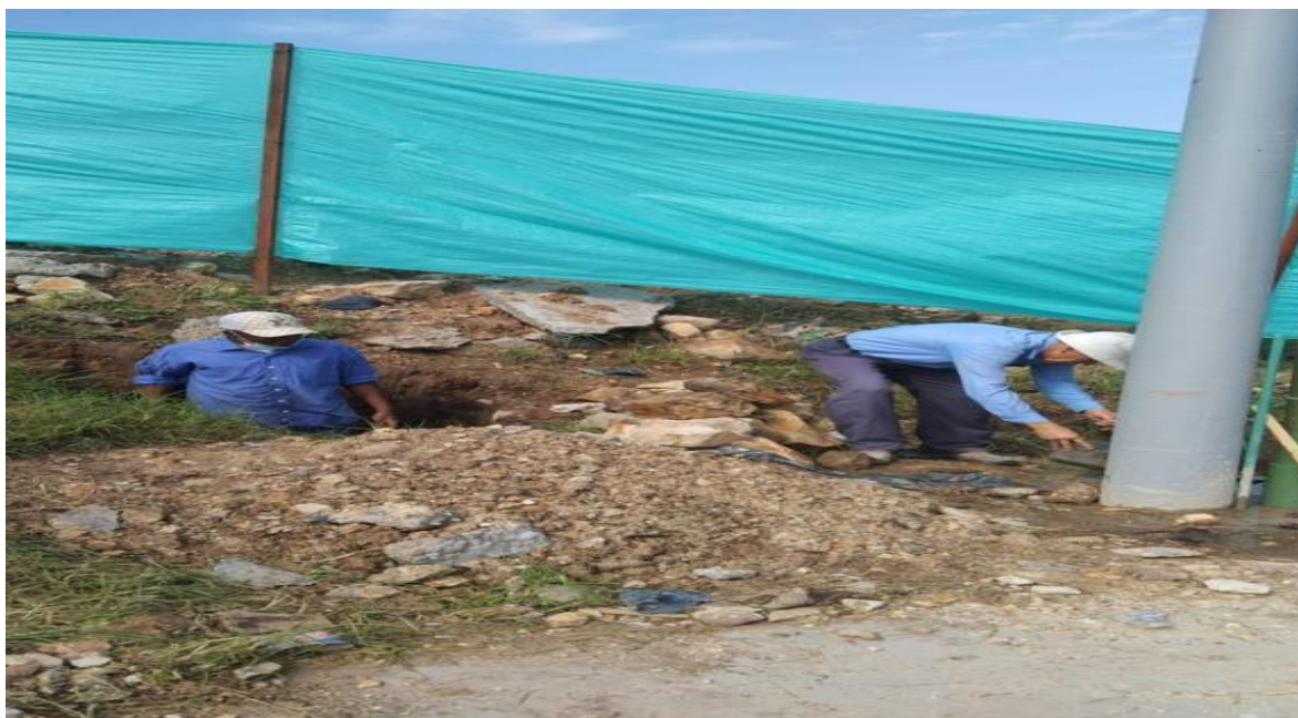
Figure 12 Excavación de dados
