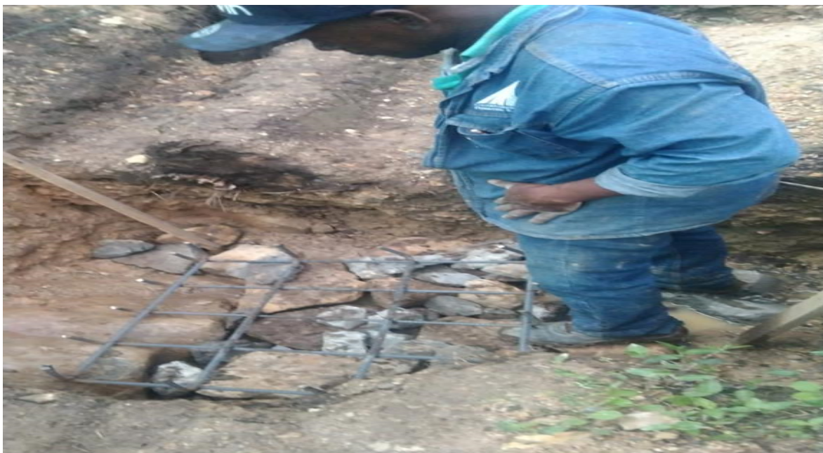
Figure 21 Concreto ciclopeo
