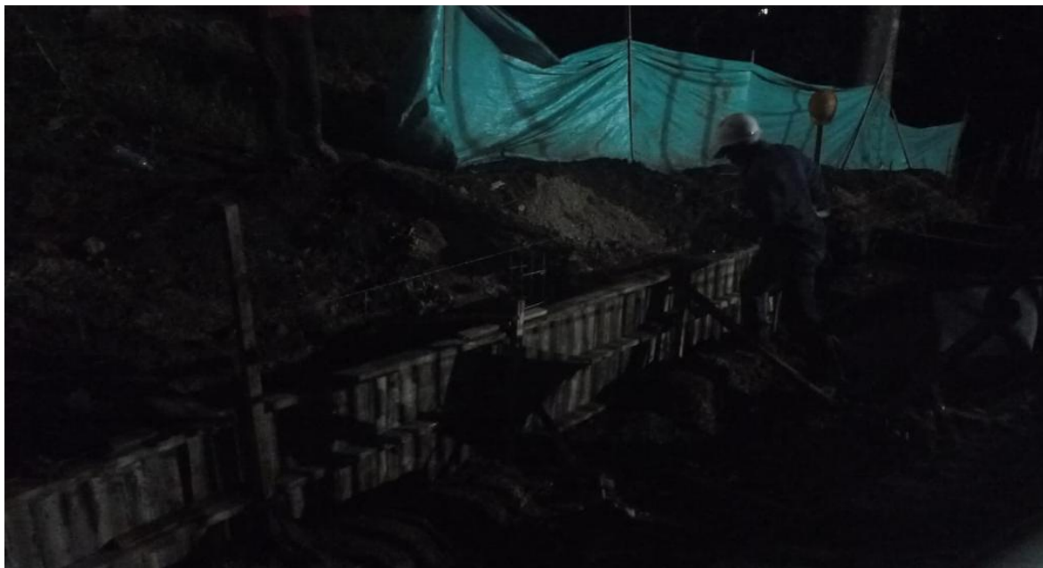
Figure 24 Fundición de vigas de cimentación
