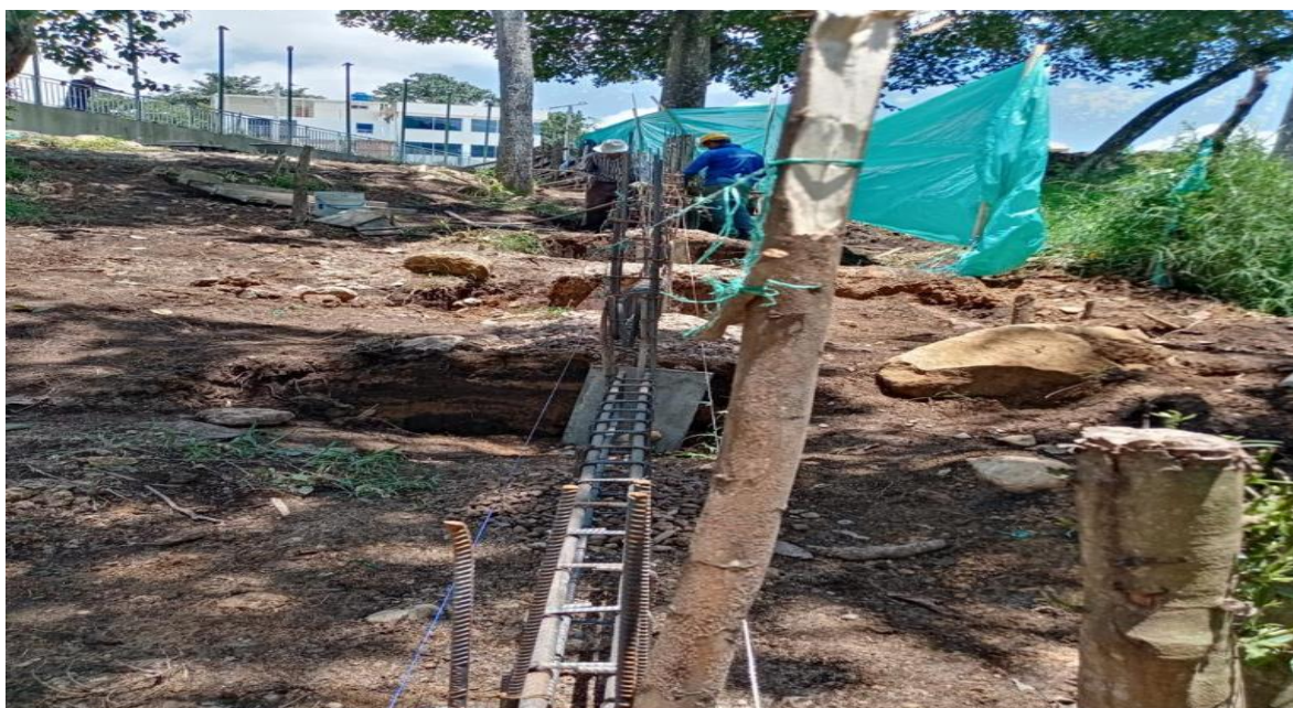
Figure 53 Instalación de estructura para vigas
