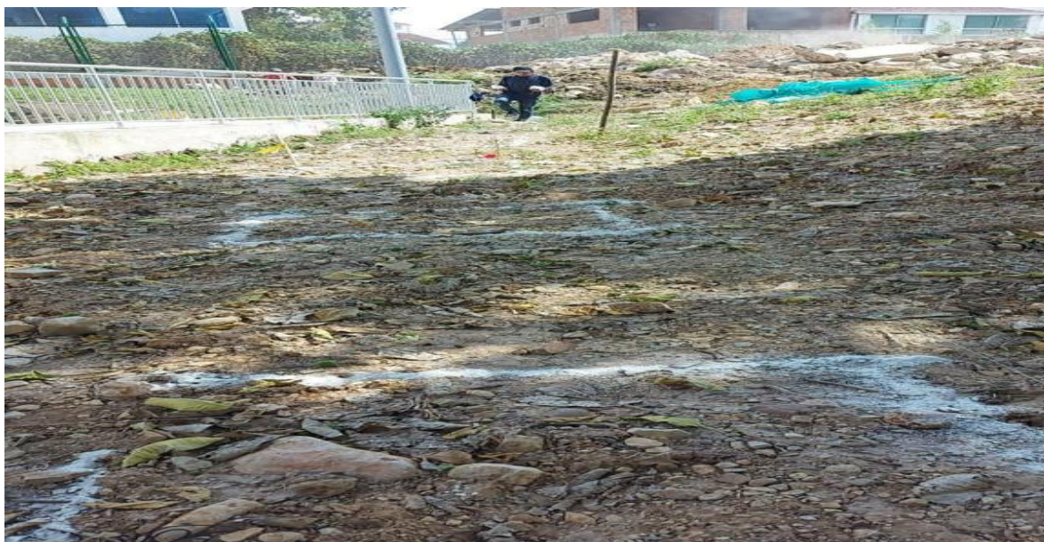
Figure 2 Replanteo de zapatas
