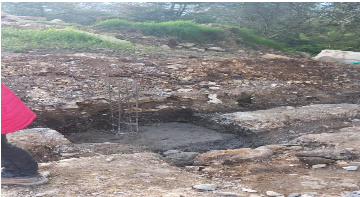
Figure 33 Construcción de zapata
