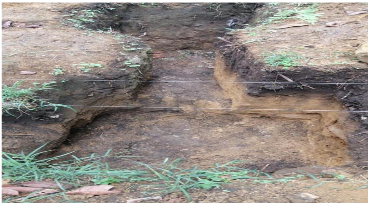
Figure 18 Excavación de viga
