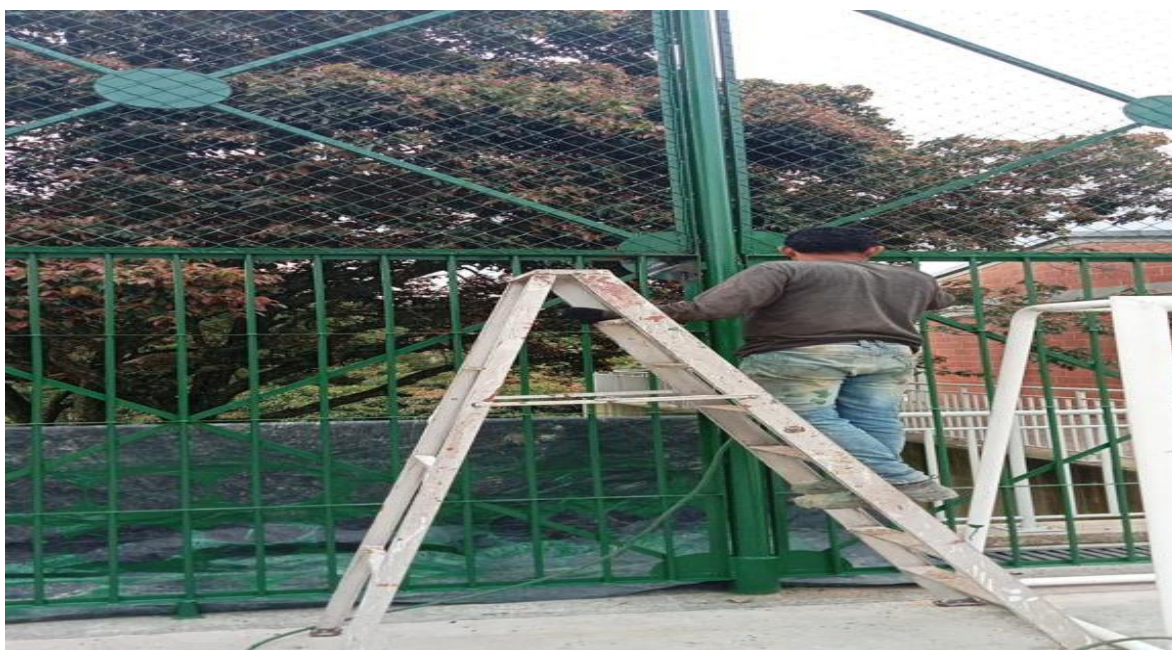
Figure 30 Aplicación de pintura en esmalte
