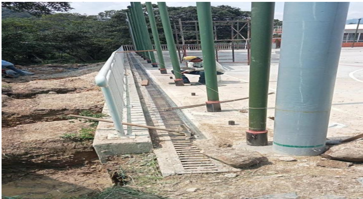
Figure 3 Instalación de cerramiento contra impacto
