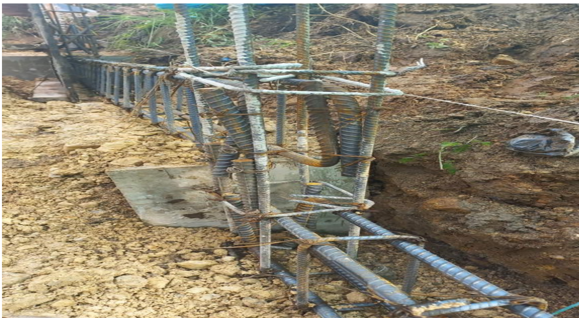
Figure 29 Estructura de viga
