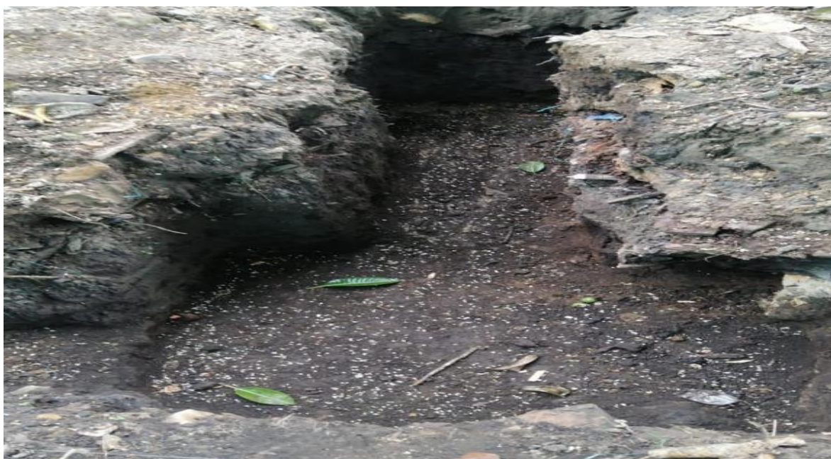
Figure 21 Excavación de dado y viga
