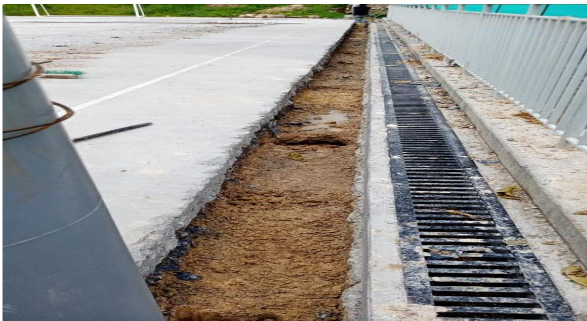
Figure 62 Pre huecos para pilotes
