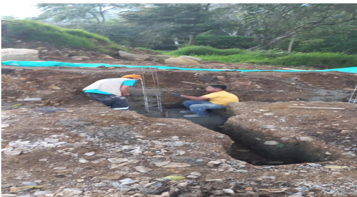
Figure 22 Elaboración de zapata
