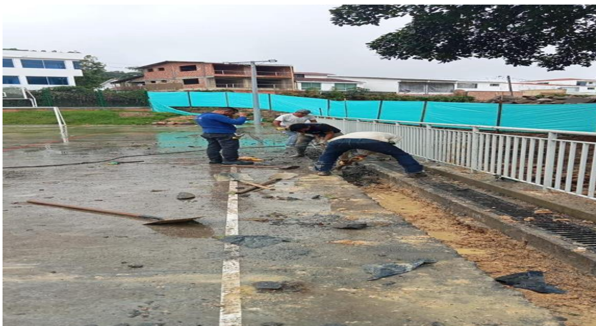
Figure 63 Demolición de placa maciza
