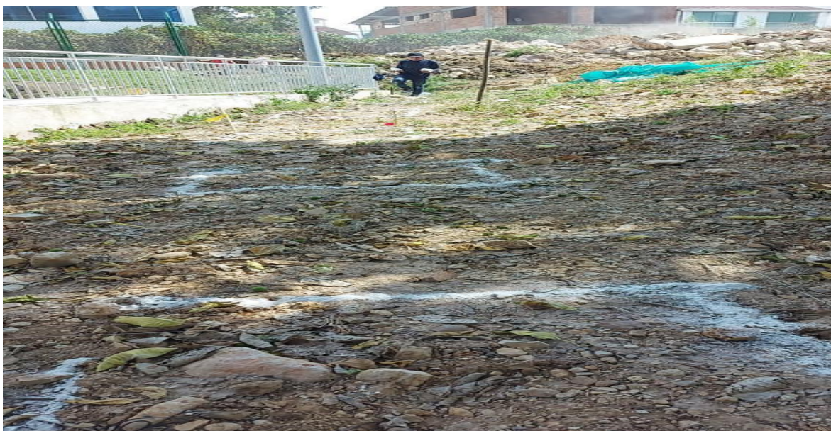
Figure 2 Replanteo de zapatas
