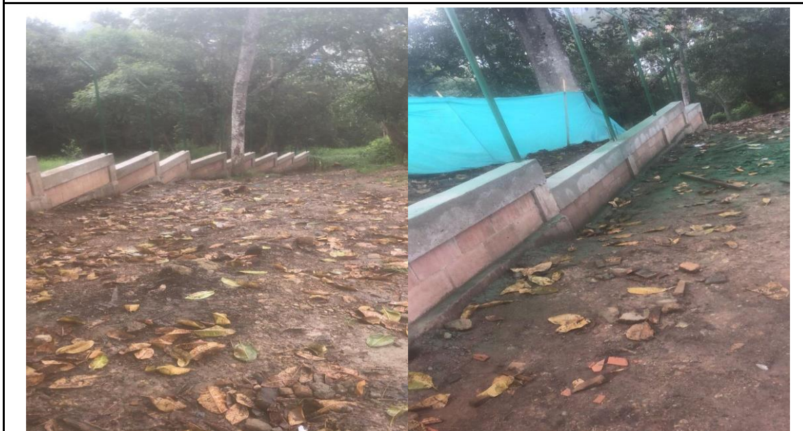
NP2 COLUMNETA DE CONFINAMIENTO 20*25 PARA CERRAMIENTO EN CONCRETO 3000 PSI
