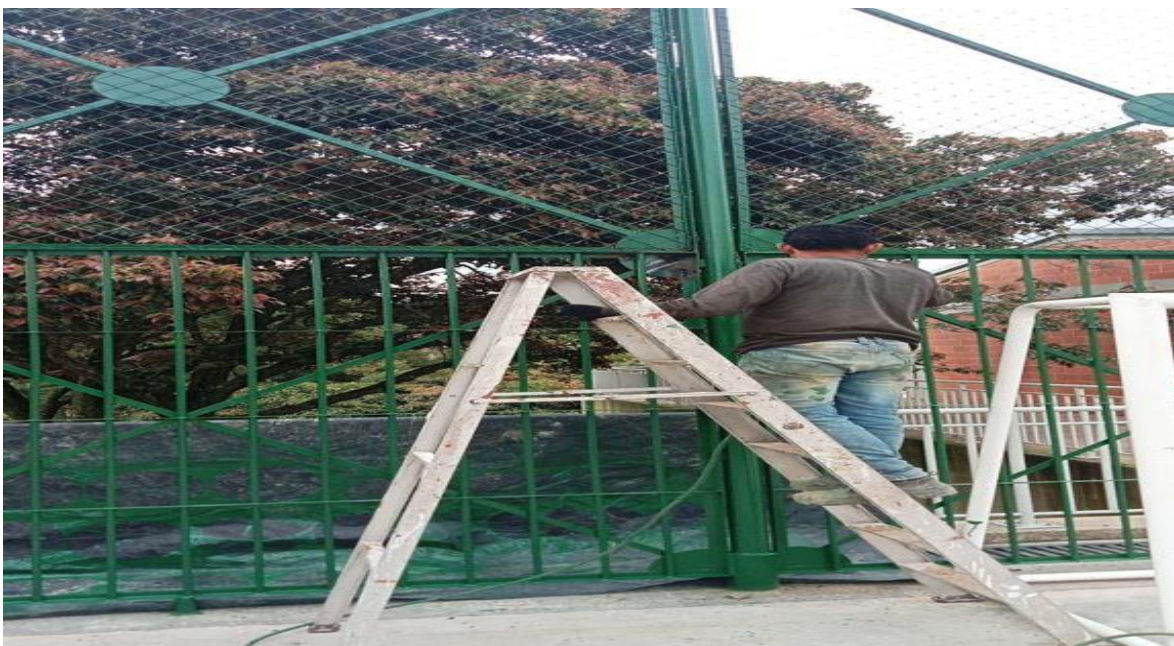
Figure 30 Aplicación de pintura en esmalte
