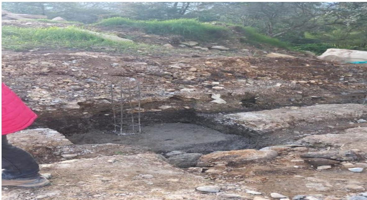
Figure 33 Construcción de zapata
