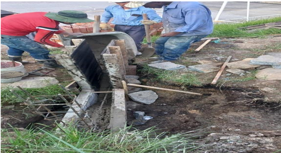
Figure 27 Fundición de viga de cimentación
