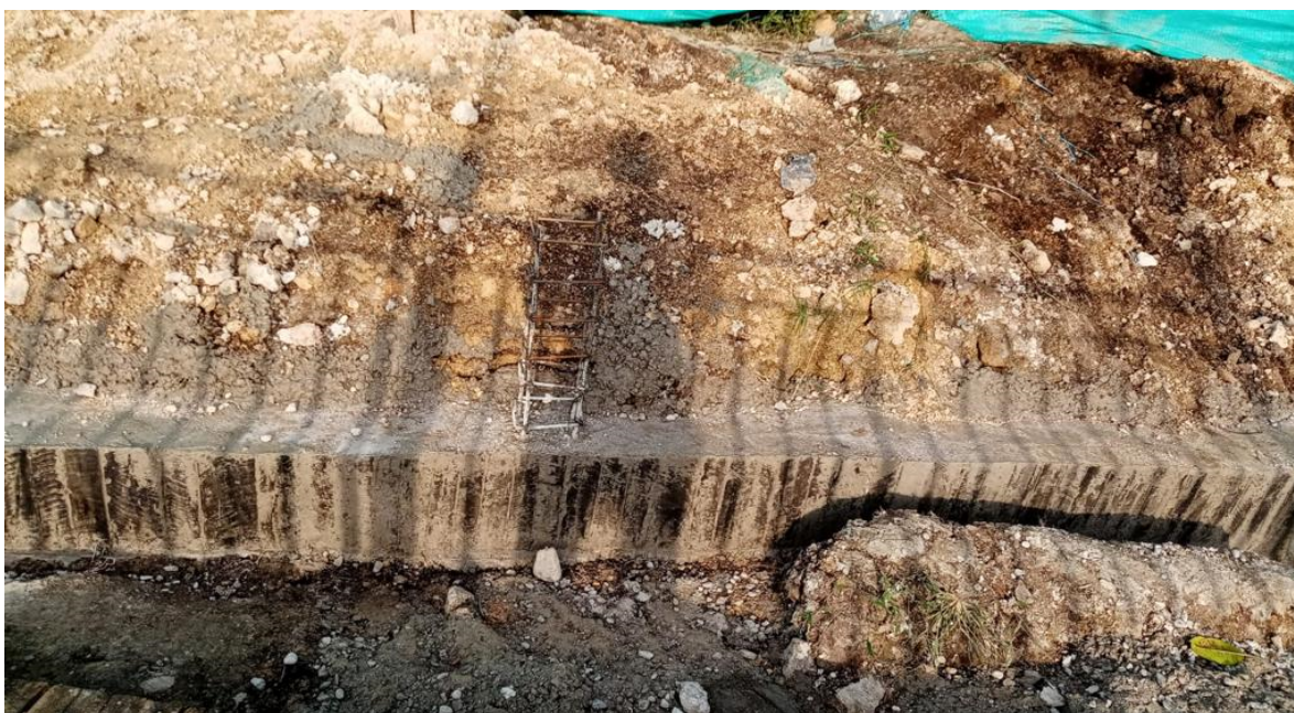
Figure 48 Viga de cimentación
