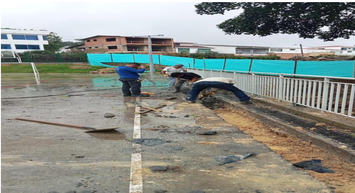
Figure 63 Demolición de placa maciza
