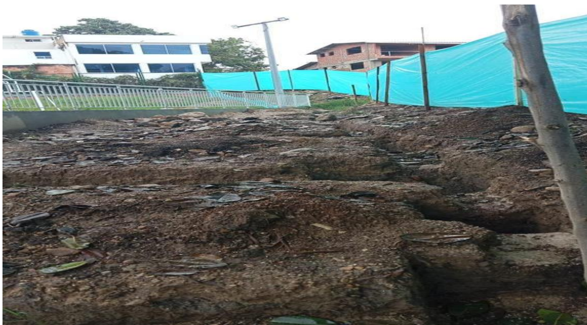
Figure 29 Excavación de vigas
