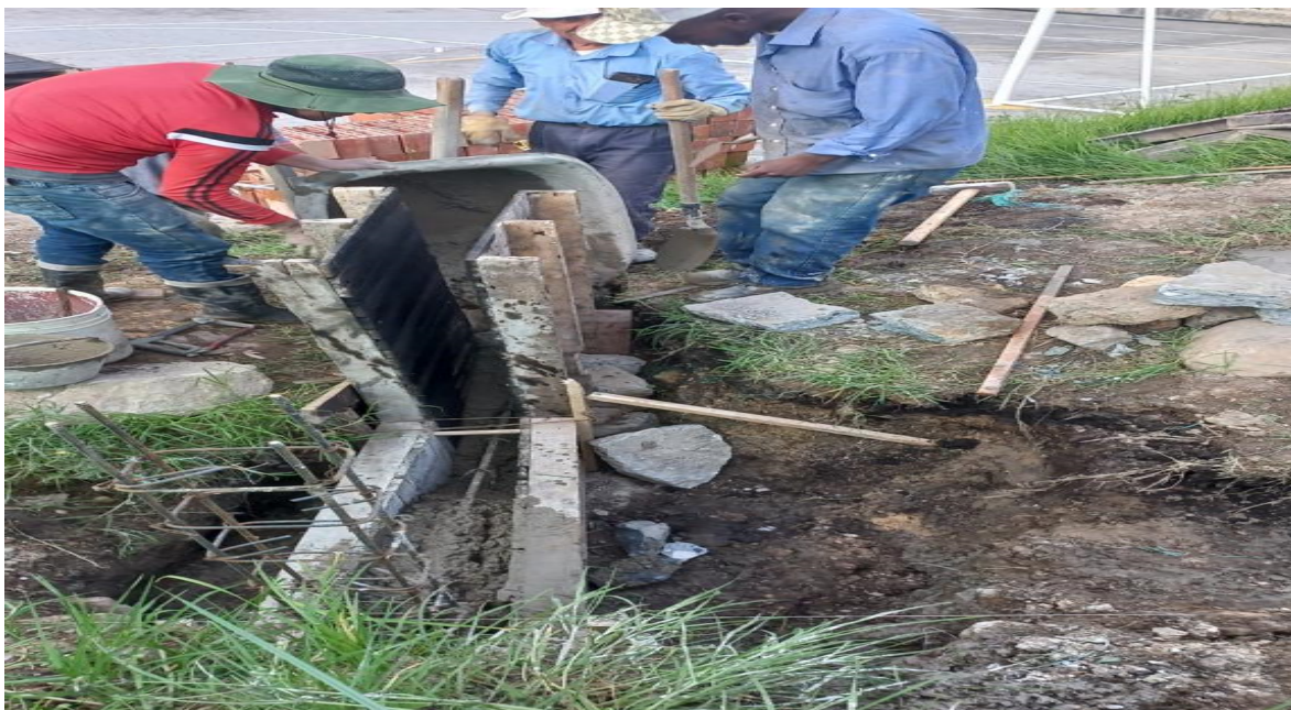
Figure 27 Fundición de viga de cimentación
