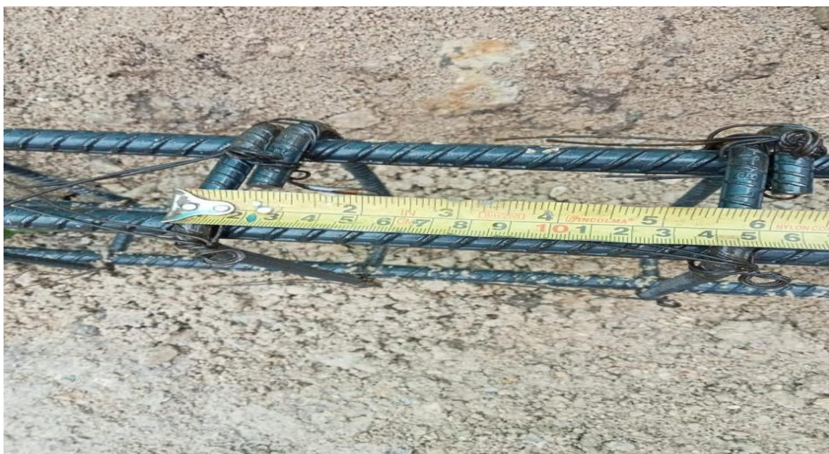
Figure 41 Distancia entre flejes
