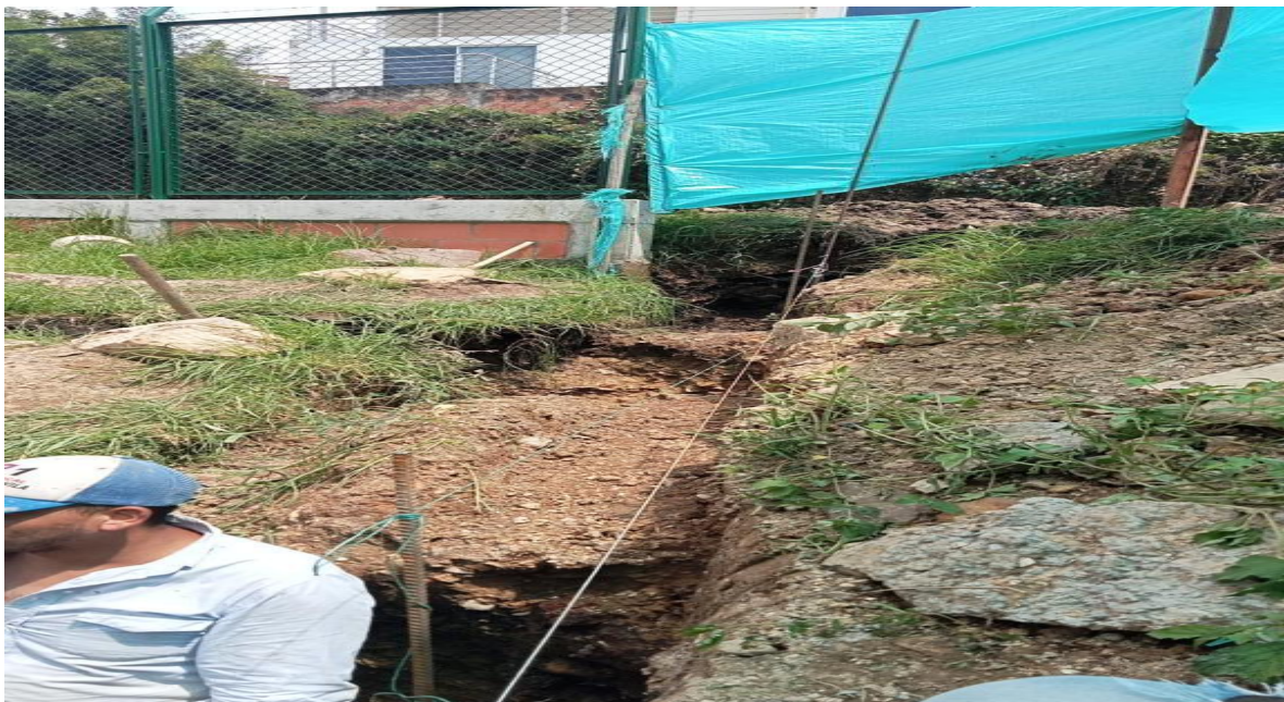
Figure 11 Excavación de vigas
