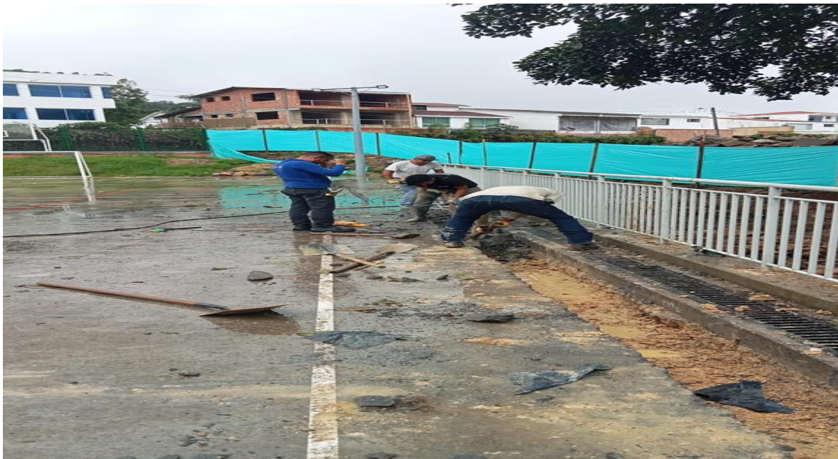
Figure 63 Demolición de placa maciza
