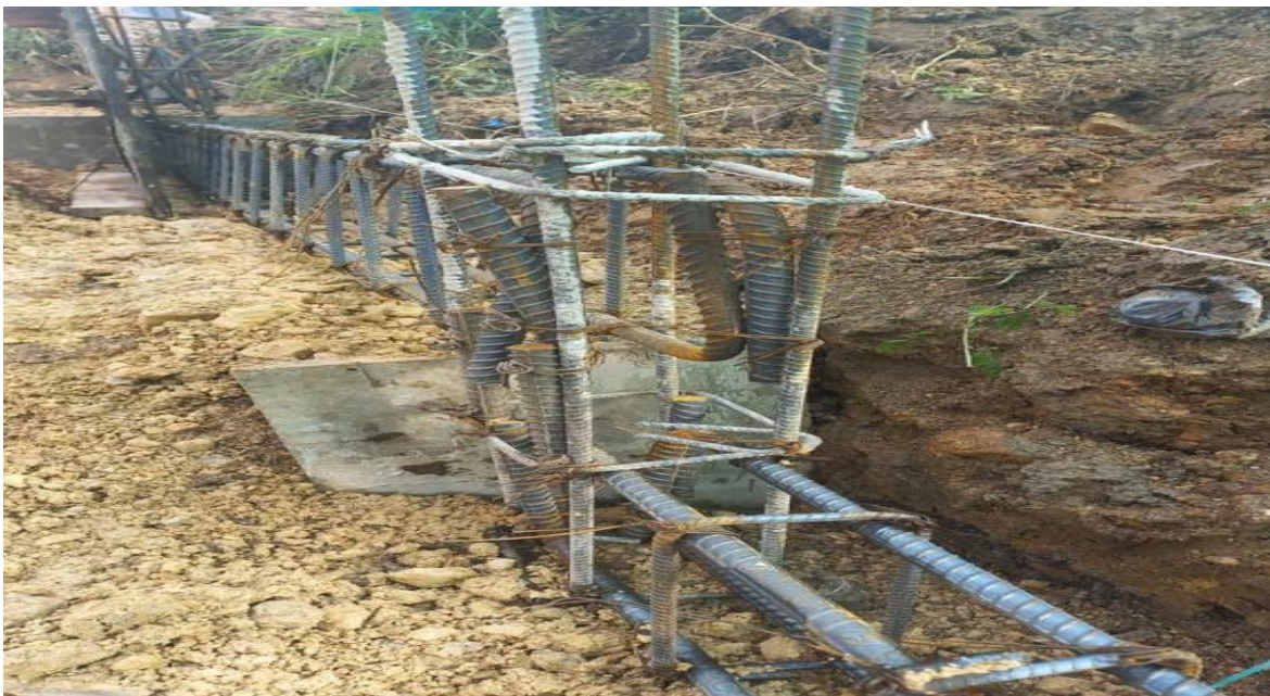
Figure 29 Estructura de viga
