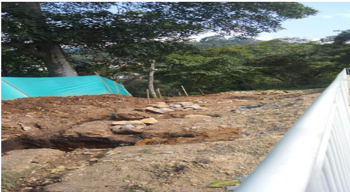
Figure 13 Excavación de zapatas
