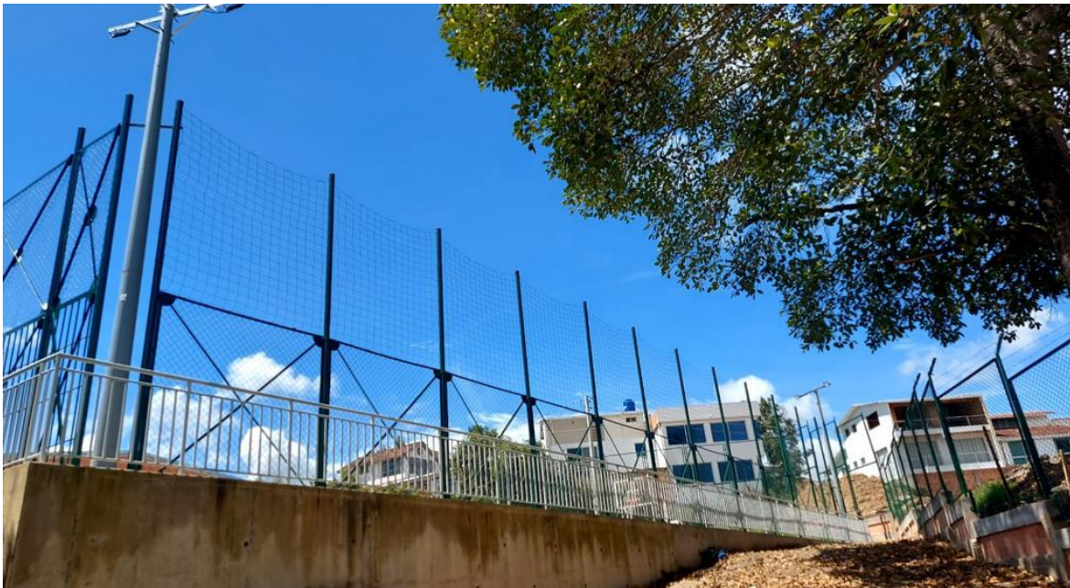
Figure 25 Cerramiento contra impacto instalado
