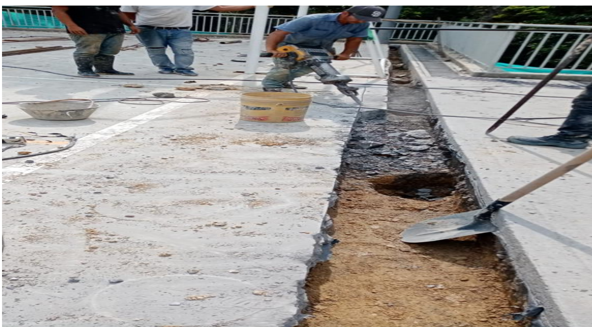
Figure 60 Demolición de placa maciza
