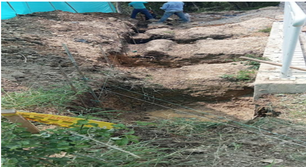
Figure 9 Excavación de dados y vigas
