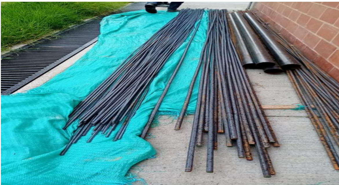
Figure 61 Almacenamiento de acero de refuerzo
