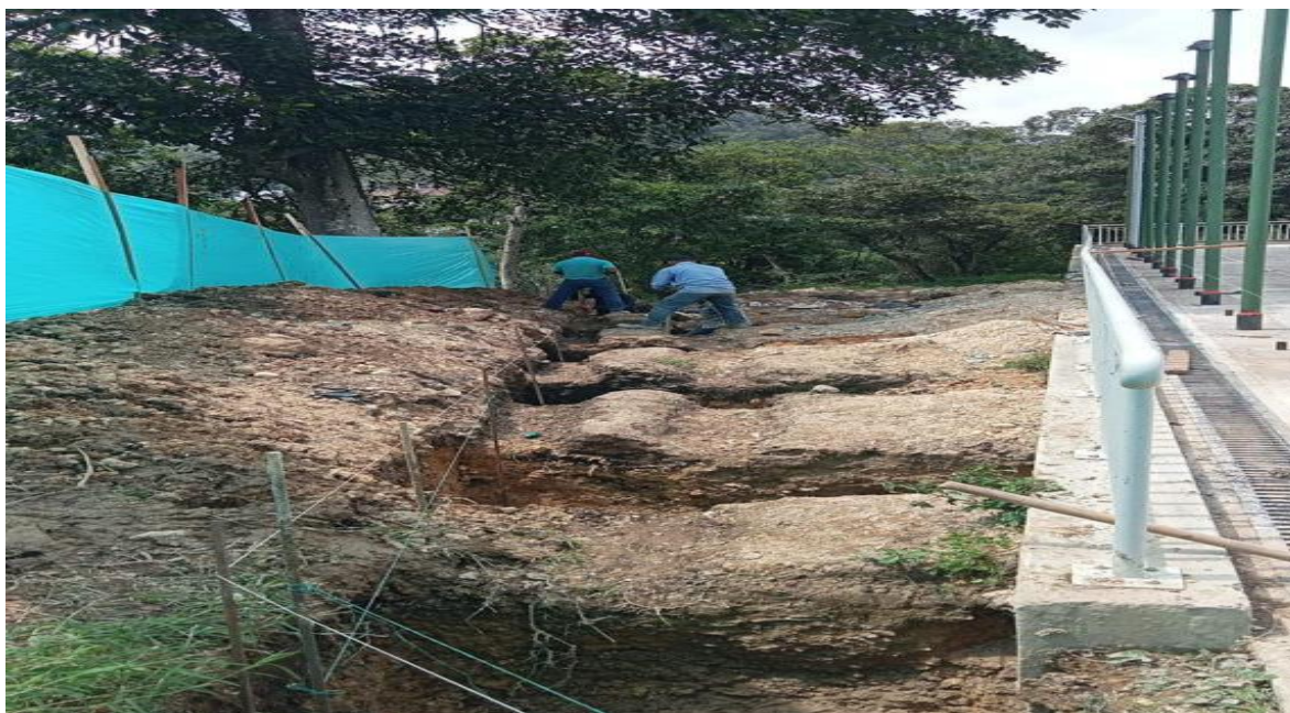
Figure 10 Excavación de dados y vigas
