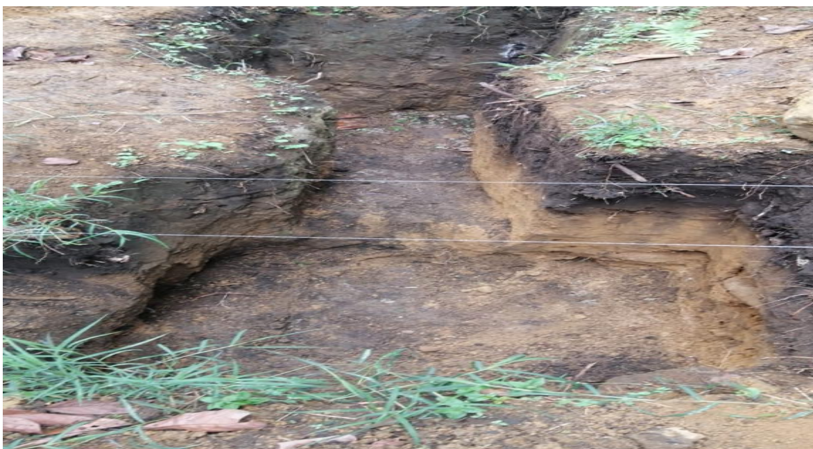
Figure 18 Excavación de viga
