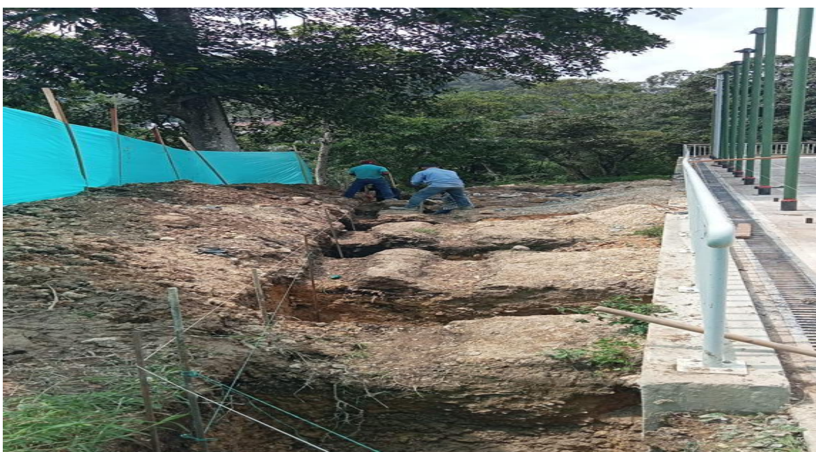
Figure 10 Excavación de dados y vigas
