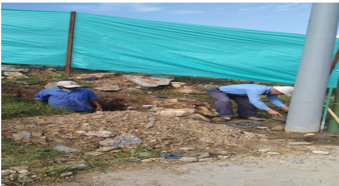
Figure 12 Excavación de dados
