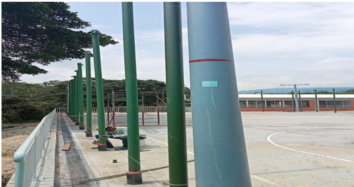
Figure 1 Instalación de cerramiento contra impacto
