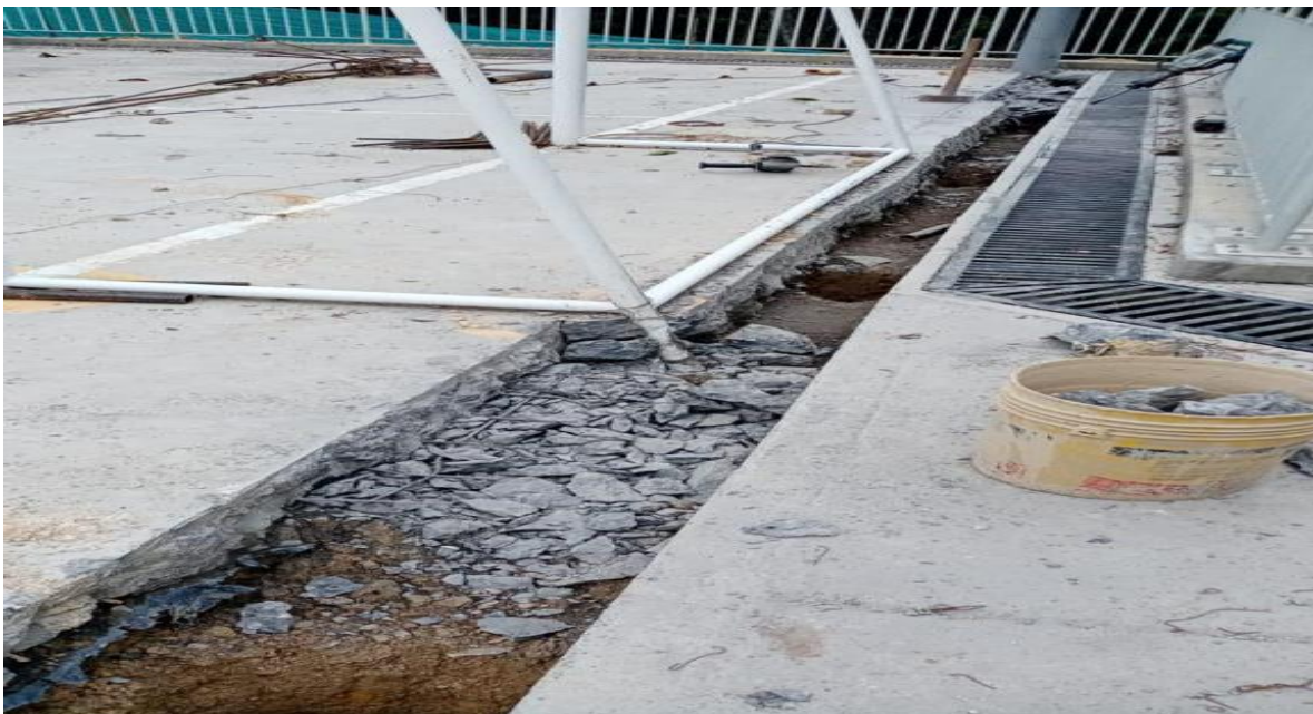
Figure 59 Demolición de placa maciza
