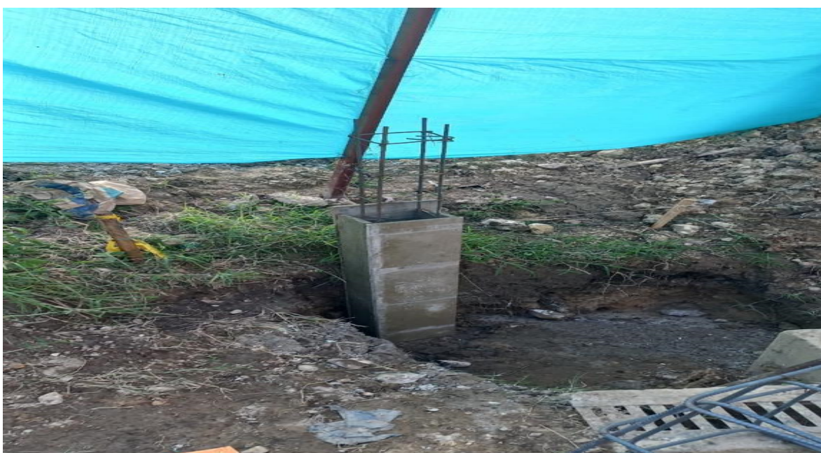
Figure 36 Fundida de columneta
