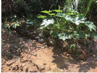
Muros y gaviones colmatados, cubiertos por la gran cantidad de sedimentos que arrastra la Quebrada Peña Lisa, Indicadores de la inutilidad de algunas obras hechas en el derrumbe.
