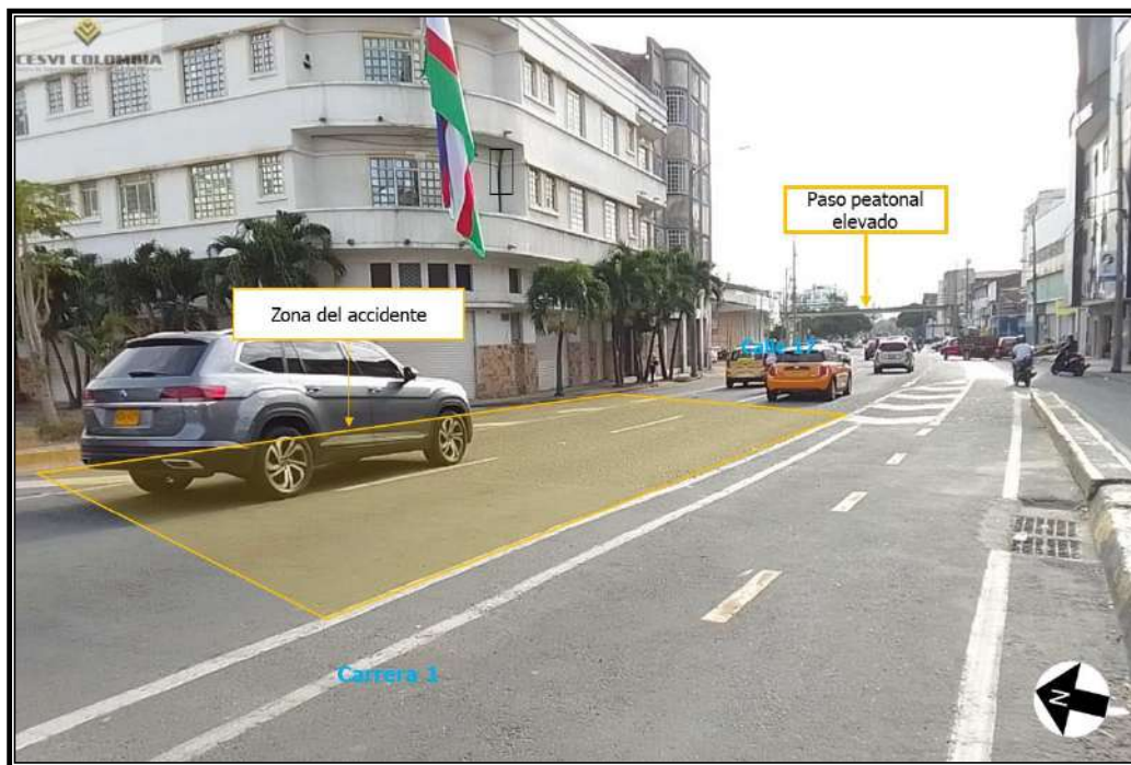
Imagen 4.12 Condiciones de la vía
