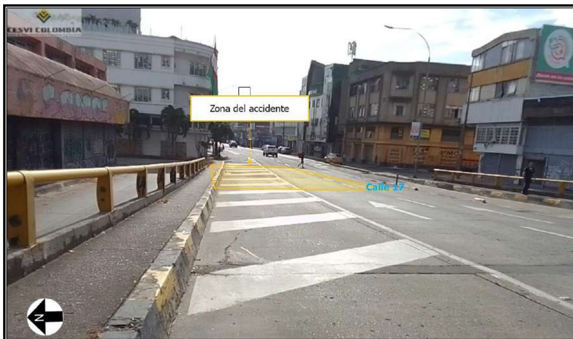
Imagen 2.4 Condiciones de la vía
