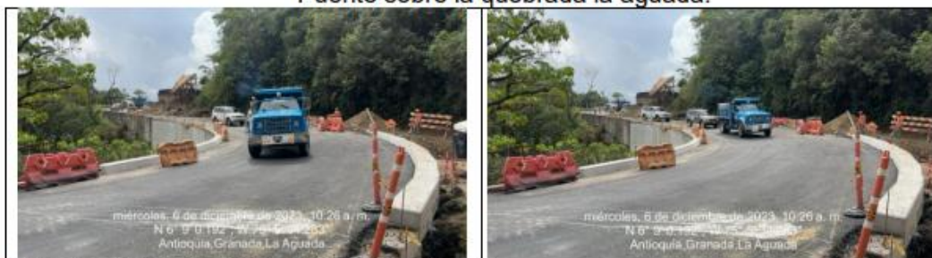
Imagen 6. Puente sobre la quebrada la aguada.
