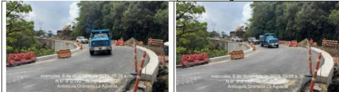
Imagen 6. Puente sobre la quebrada la aguada.
