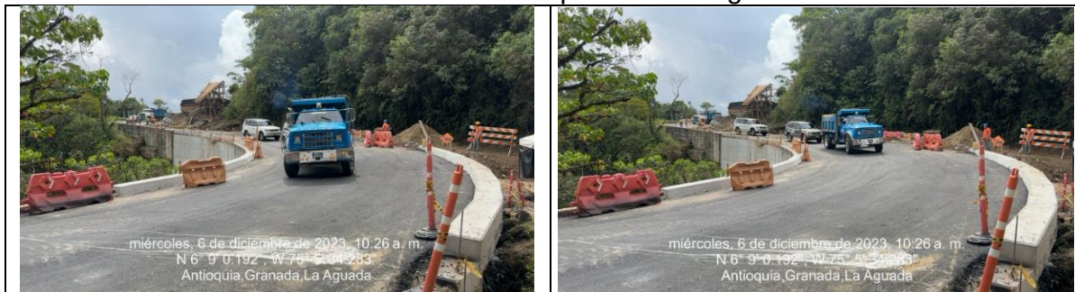
Imagen 6. Puente sobre la quebrada la aguada.
