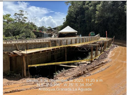
Losa superior terminada.
