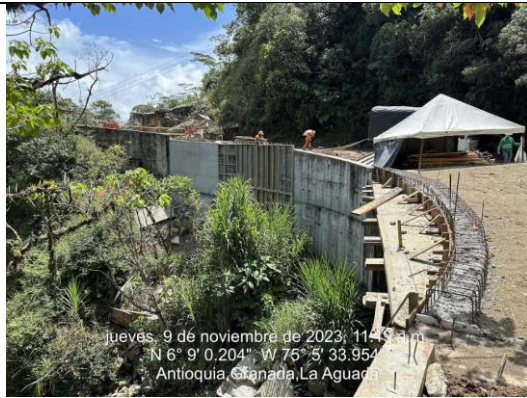
Muro de contención terminado.
