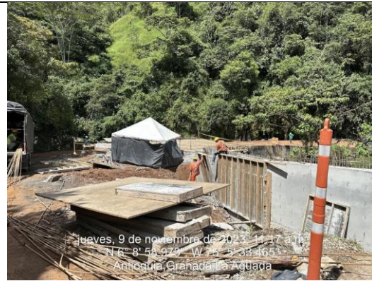
Llenos faltantes para la conformación de la vía.
