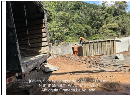
Desmonte de formaletas de muro de contención.
