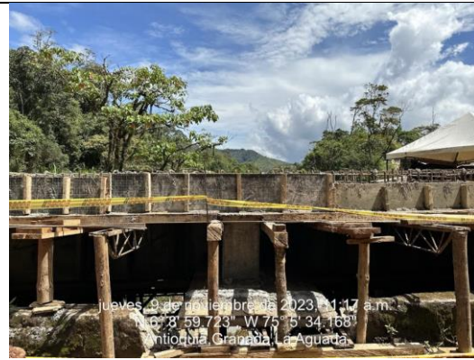
Formaletas y vaciado de losa superior.
