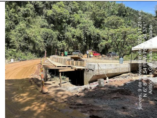
Estado del puente antiguo y nuevo.
