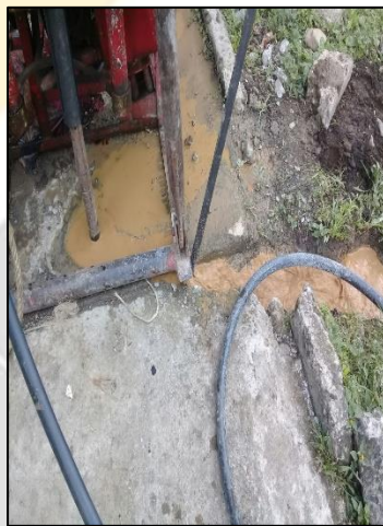
Fotografía 1: Exploración geotécnica realizada en el lote objeto de estudio, remoción de capa superficial y realización de sondeos, equipo de exploración mecánico.
