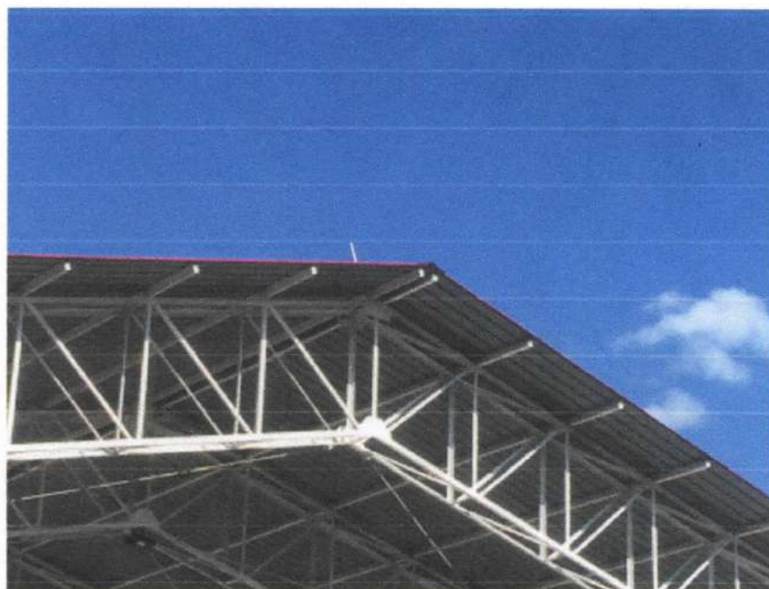
Foto No. 26. Punta captadora para apantallamiento
