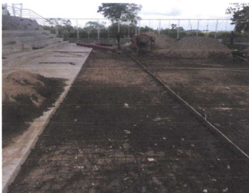
Foto No. 10. Malla electrosoldada para placa
