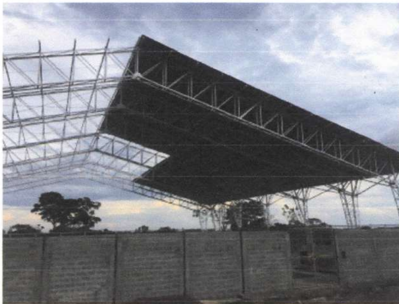
Foto No. 8. Instalaciones teja para cubierta
