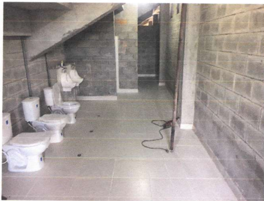
Foto No. 11. Instalación de aparatos sanitarios
