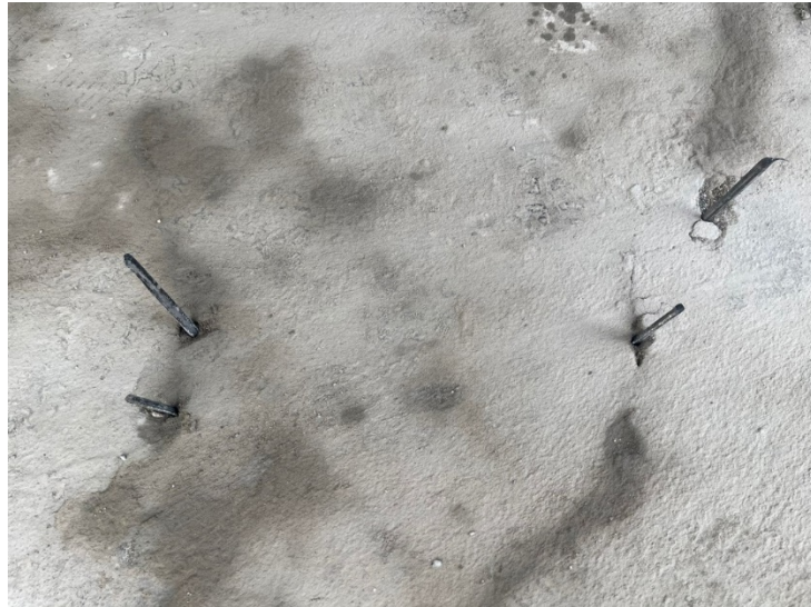
Perforaciones pasantes en placa de cubierta
