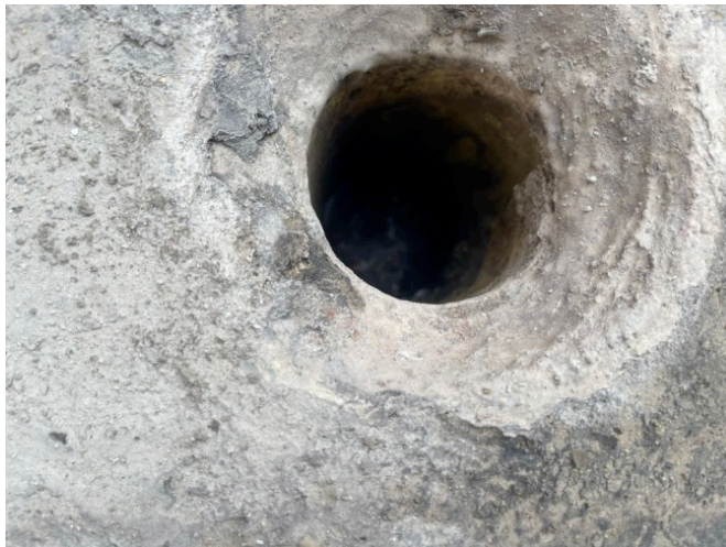
Sifón tapado con material asfáltico
