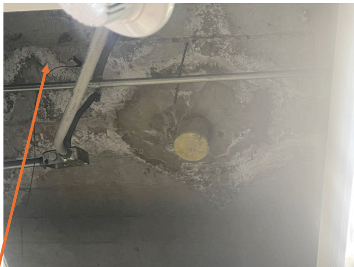
Fisuras en la placa de cubierta vista desde el nivel inferior
