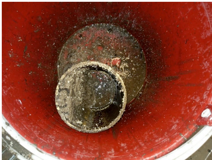
Tubería de sifón tapado con un material grasoso
