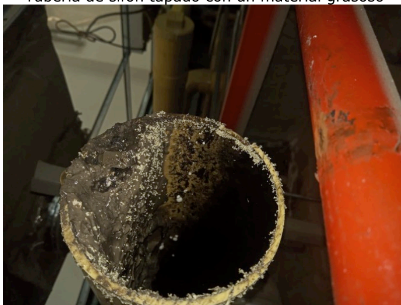
Tubería de sifón tapado con un material grasoso
