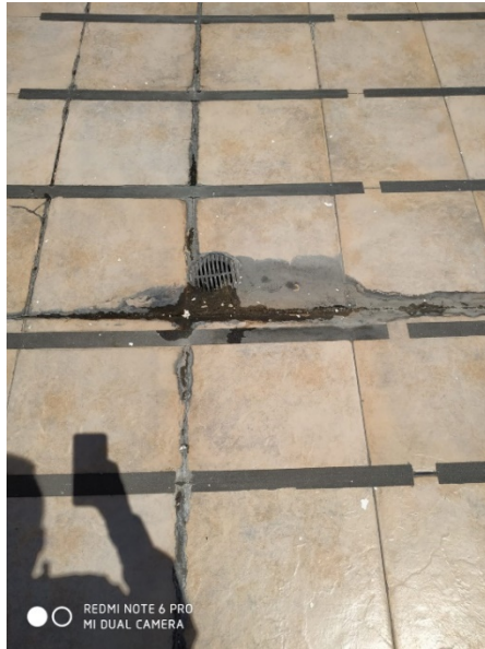
Fotos Costado Nor-occidental – Junio de 2019 Filtraciones sobre la zona del DATACENTER
