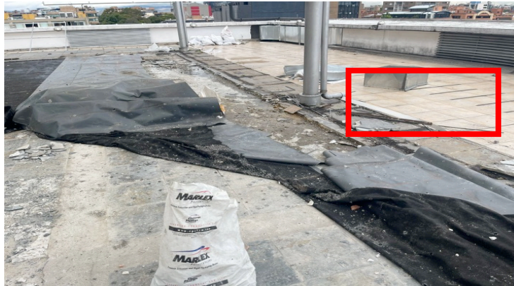
Tubería de bajante sin conexión y espesor de sobre piso
