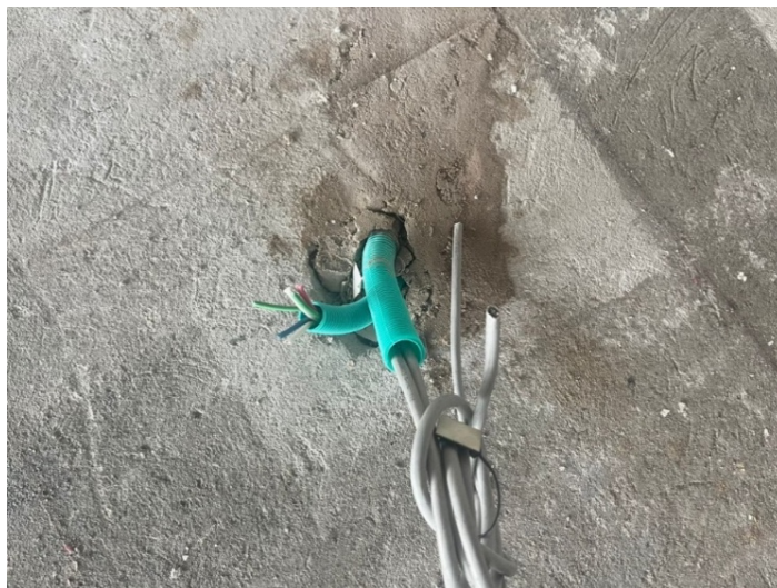
Perforaciones pasantes de piso en placa para cableado en otros pisos
