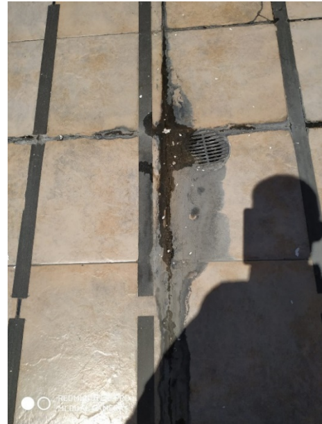
Fotos Costado Nor-occidental – Junio de 2019 Filtraciones sobre la zona del DATACENTER
