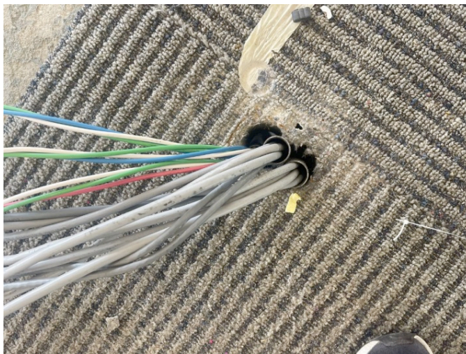
Perforaciones con pasantes de gran tamaño y cableado
