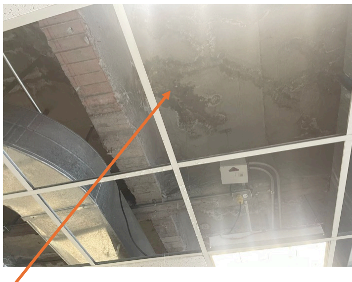
Fisuras en la placa de cubierta vista desde el nivel inferior
