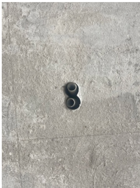
Perforaciones pasantes de piso en placa para cableado en otros pisos
