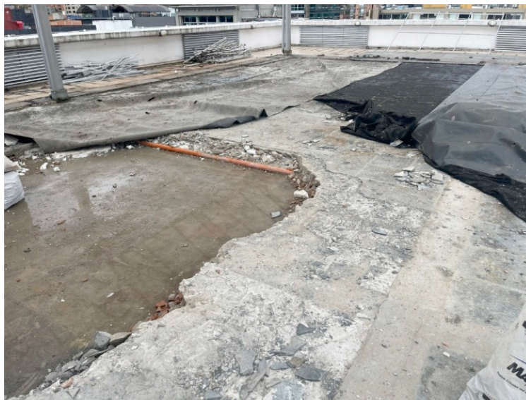
Espesor de sobre piso en cubierta 35 centímetros en el comedor y 20 cm en las terrazas
