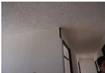
Comentarios: Vista de actividad pendiente de remate de muro área de acceso a alcoba.
