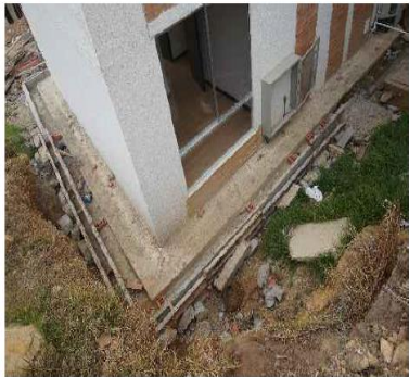
Comentarios: Vista de actividades exteriores de urbanismo pendientes en la torre G bloques 5, 6, 7 y 8. Se observa la instalación de formaleta para construcción de cunetas en concreto sobre las fachadas posteriores de la torre.
