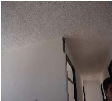
Comentarios: Vista de actividad pendiente de remate de muro área de acceso a alcoba.
