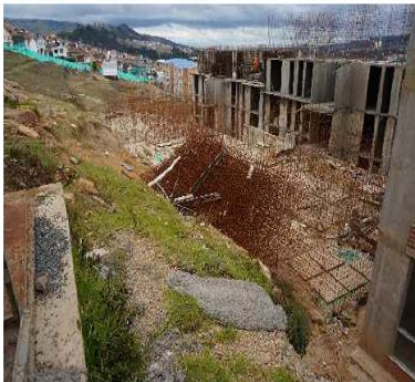
Comentarios: Vista general de los bloques 3 y 4 torre F, en construcción. Se observa el desarrollo de actividades en las viviendas a nivel de cimentación e inicio de estructuras en primer piso.
