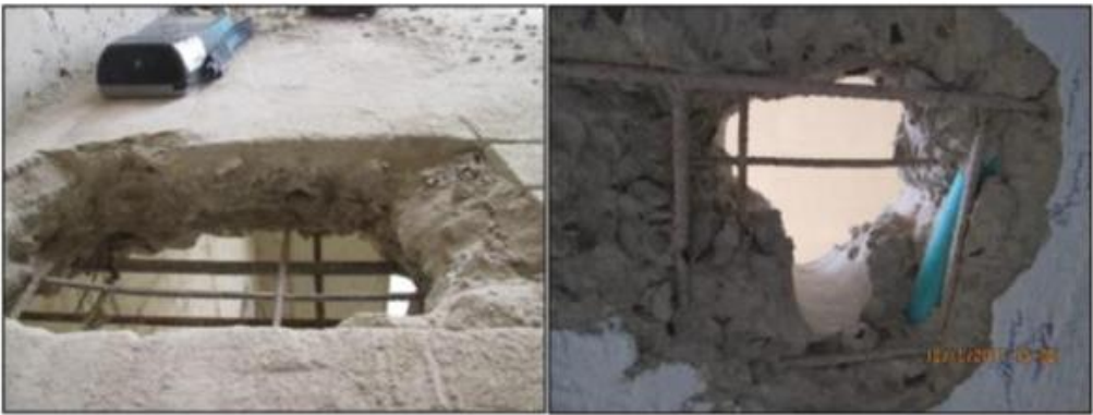
Ilustración 16 Calas para verificación de recubrimientos: cerca al apoyo (izquierda) y hacia el centro de la losa (derecha). Informe UPTC.
