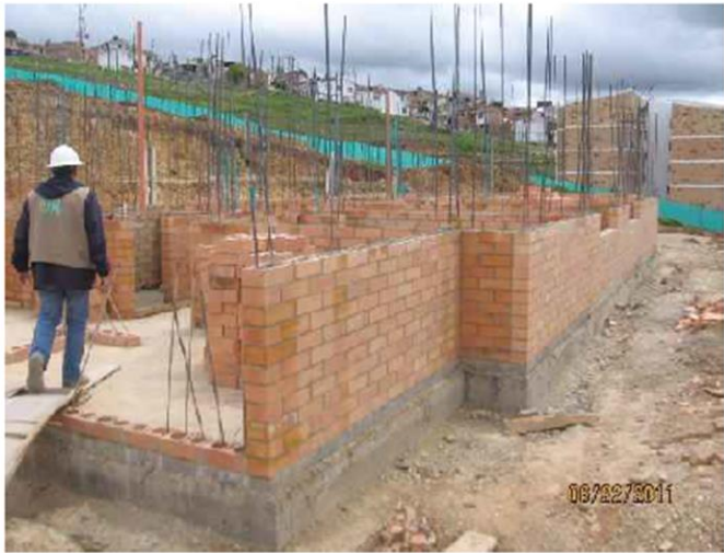
Comentarios: 3- Aspecto del avance de obras en torre E4
