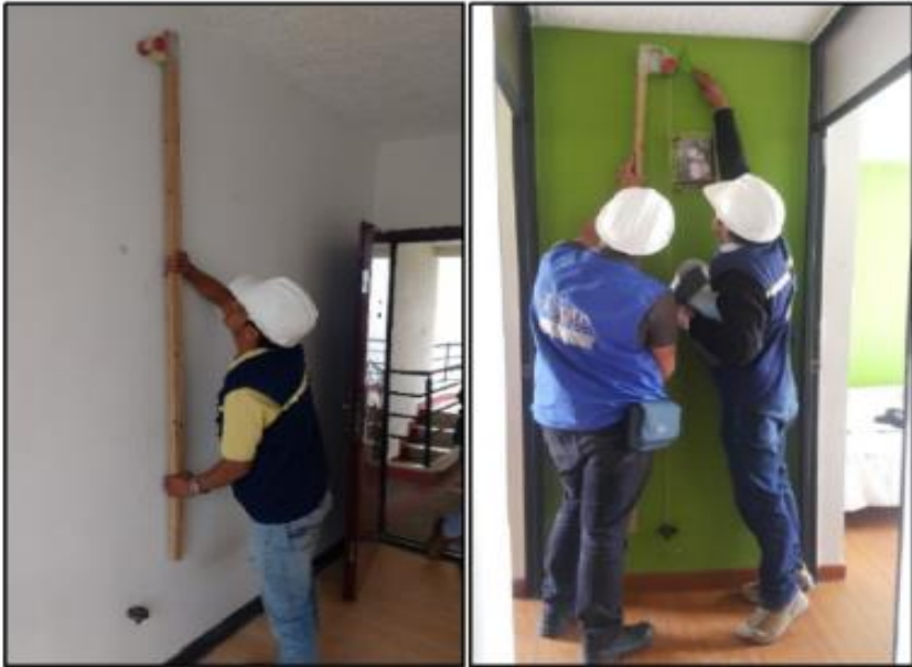
Ilustración 13 Medición de plomo de muros UPTC
