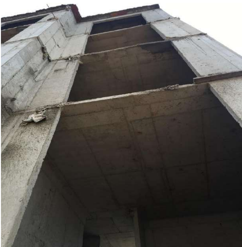
DEFLEXIONES EN PLACAS- ABOMBAMIENTOS EN MURO
