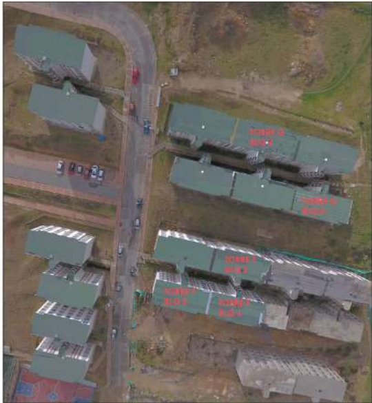
Ilustración 3 Cubiertas a intervenir
