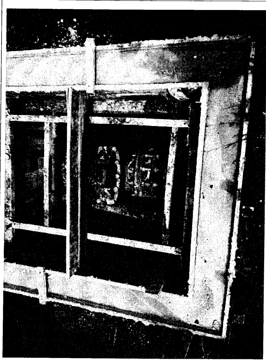
FOTOGRAFIA 29. VÁLVULA DE CORTE NO. 3.
