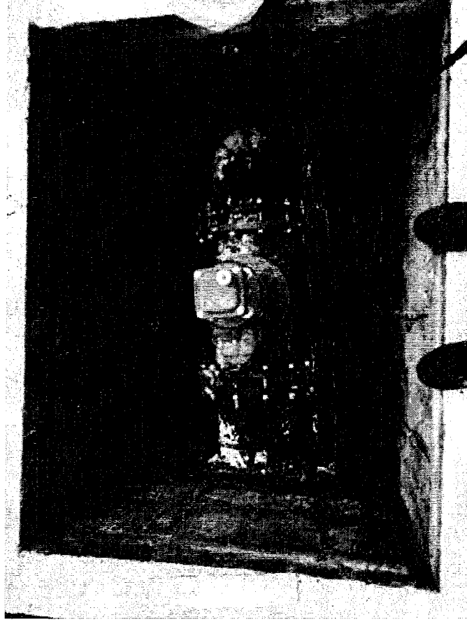
FOTOGRAFÍA 31. VÁLVULA VENTOSA NO. 5.
