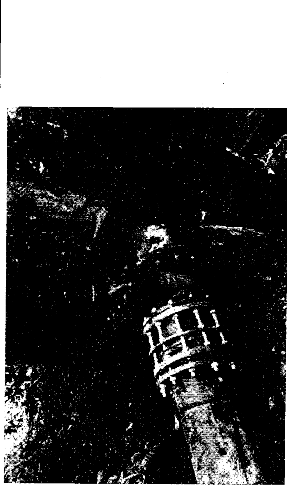
FOTOGRAFÍA 6. CONEXIÓN SALIDA DE DESARENADOR.
