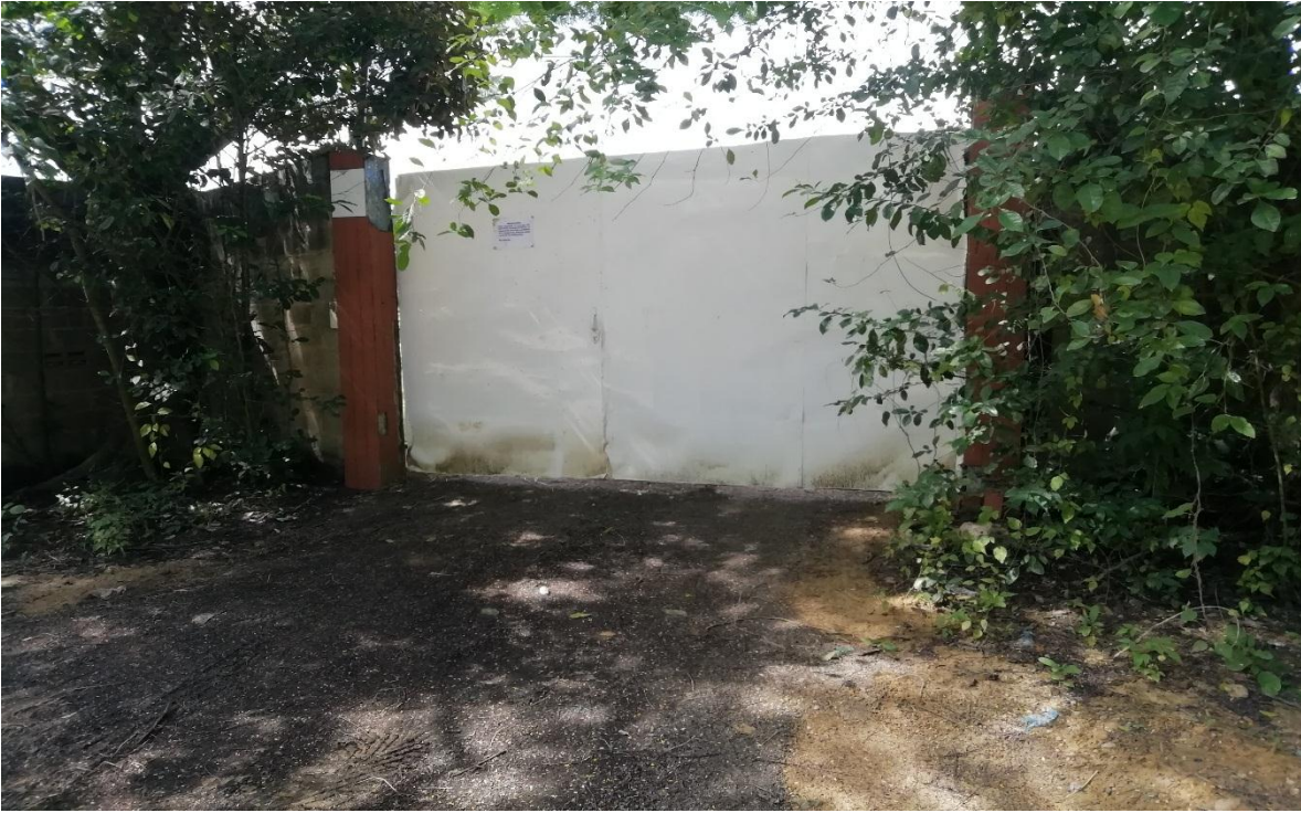
FOTOGRAFIAS PORTON DE ENTRADA CONDENADA.
