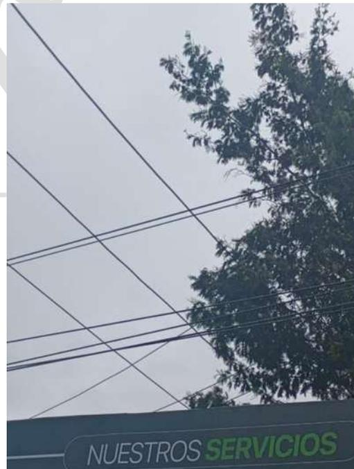
Fotos 11y 12 Red de media tensión cruzando por encima de la valla donde sucedió el accidente, vista frontal y posterior. Distancia vertical menor a dos metros.
