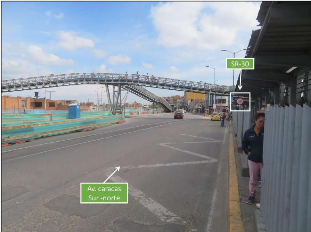
**Fotografía No.2 Plano General:** En esta fotografía tomada por el equipo de IRS Vial sobre la Avenida Caracas en sentido Sur – Norte en aproximación a la carrera 7 , se aprecian las características generales de la vía, en la cual se encuentra demarcación horizontal de líneas de borde blanca, con señalización vertical SR-30 (Velocidad máxima permitida 30 km/h); en este sentido se desplazaban los vehículos involucrados en el hecho.
