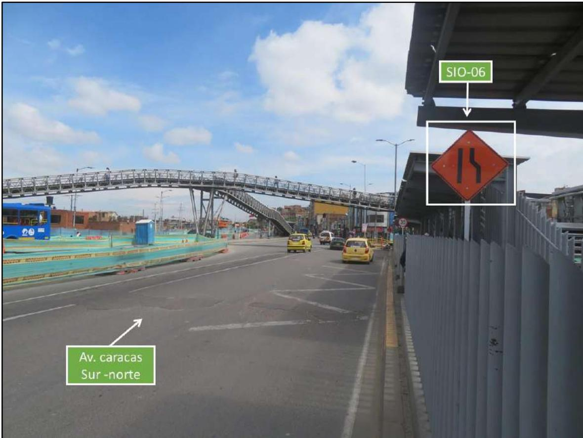
**Fotografía No.1 Plano General:** En esta fotografía tomada por el equipo de IRS Vial sobre la Avenida Caracas en sentido Sur – Norte en aproximación a la carrera 7, se aprecian las características generales de la vía, en la cual se encuentra demarcación horizontal de líneas de borde blanca, con señalización vertical SIO-06 (Angostamiento a la izquierda); en este sentido se desplazaban los vehículos involucrados en el hecho.
