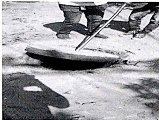
Fotografías 7 a 10. Cajas de inspección y cámaras de inspección
