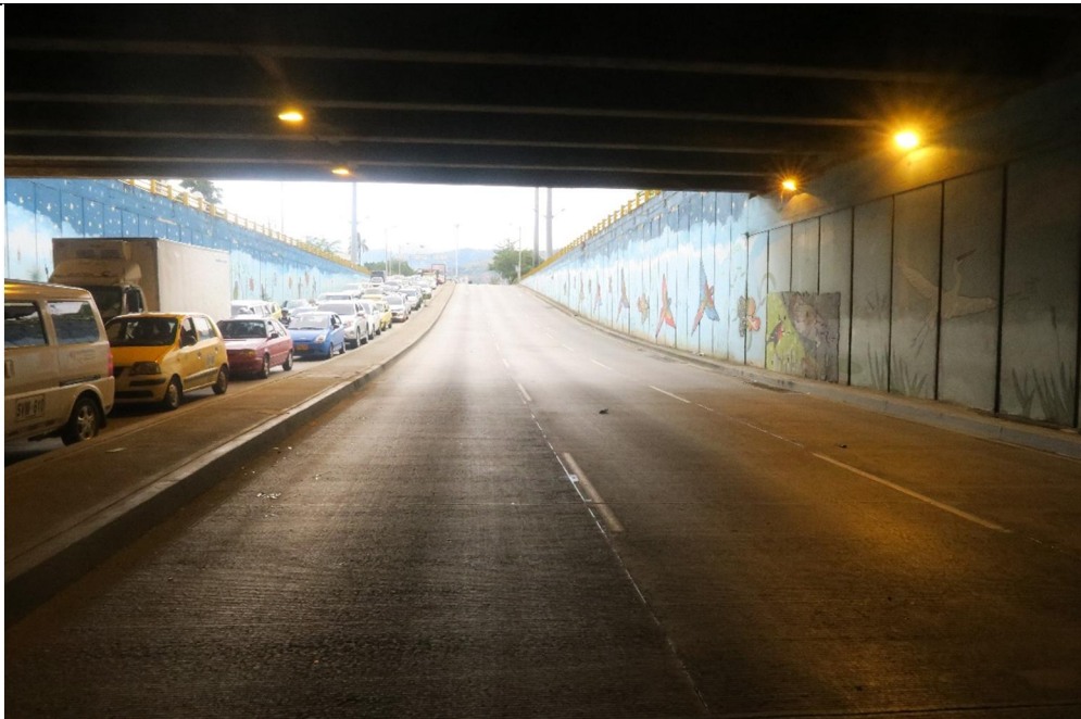
IMAGEN No. 01 Fijación fotográfica panorámica tomada en sentido oriente-occidente, en el hundimiento de la carrera 23, vía de tres carriles, demarcada con líneas blancas discontinuas, con una inclinación a la salida del túnel para llegar a la transversal 25 donde sucedieron los hechos.
