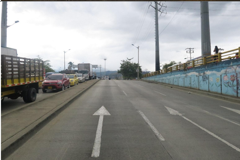
IMAGEN No. 02 Fijación fotográfica panorámica de la vía tomada en sentido oriente occidente sobre la carrera 23, vía de tres carriles con líneas blancas discontinuas, con demarcación de sentido vial, sobre cada carril, para llegar a la transversal 25.
