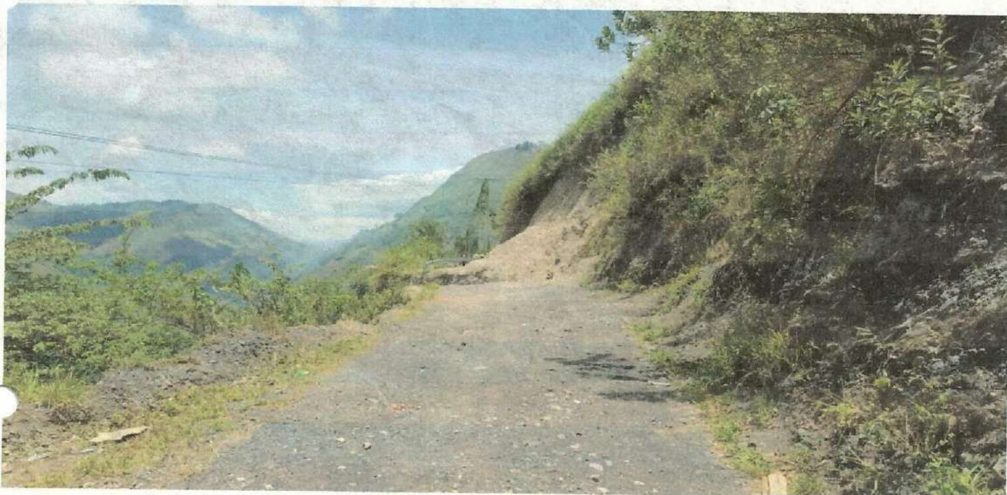
FOTOGRAFIA No 3 whatsapp image-2017-08-20 at 18.33.42 jpeg PLANO GENERAL: Donde se observa el diseño geométrico de la vía por donde transitaba el vehículo 1 motocicleta y se alcanza a observar por la mita de la vía donde transitaba la motocicleta, las condiciones climáticas como son tiempo normal, vía seca, luz natural buena; de igual manera se logra observar una huella de la trayectoria de la motocicleta la cual termina unos centímetros antes de la finalización de la vía. (Fotografía tomada en sentido vial Caparrapi-Guaduas)
