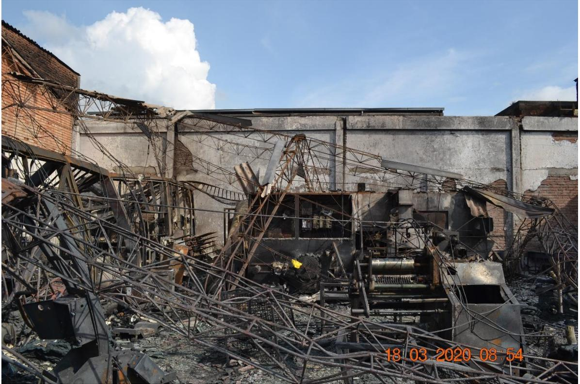
**Se aprecia el estado de la máquina engomadora.**
