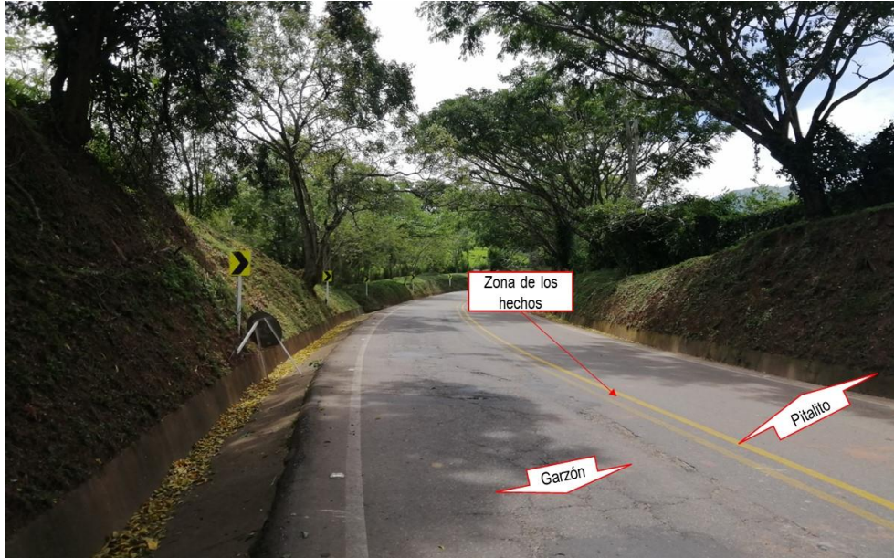
Fotografía No.3 Plano General: fotografía tomada sentido Garzón - Pitalito, donde se observan las características generales del tramo de vía. En este sentido se desplazaba el vehículo No 1 Motocicleta.
