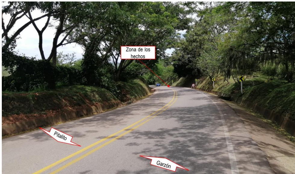
Fotografía No.4 Plano General: fotografía tomada sentido Pitalito - Garzón, donde se observan las características generales del tramo de vía: curva, pendiente, estado bueno, asfalto, una calzada, doble sentido de circulación, demarcación horizontal línea central doble continua amarilla y mixta. En este sentido se desplazaba el vehículo No 2 Camión.
