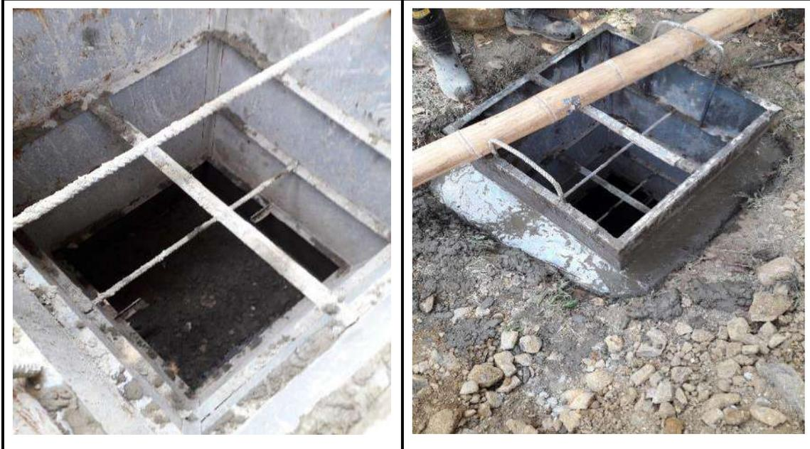
**F38. PROTECCION DE ROTURA TUBERIA DE CEMENTO AGUAS PLUVIALES.**
