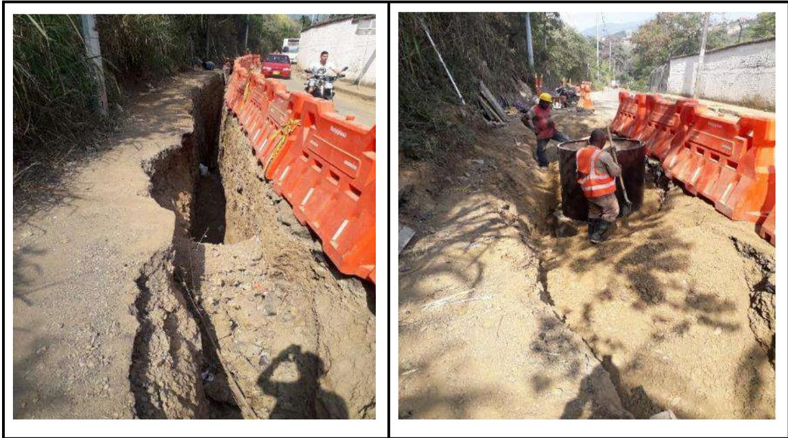
**F40. EXCAVACION MANUAL EN EL TRAMO 39 A 38.**
