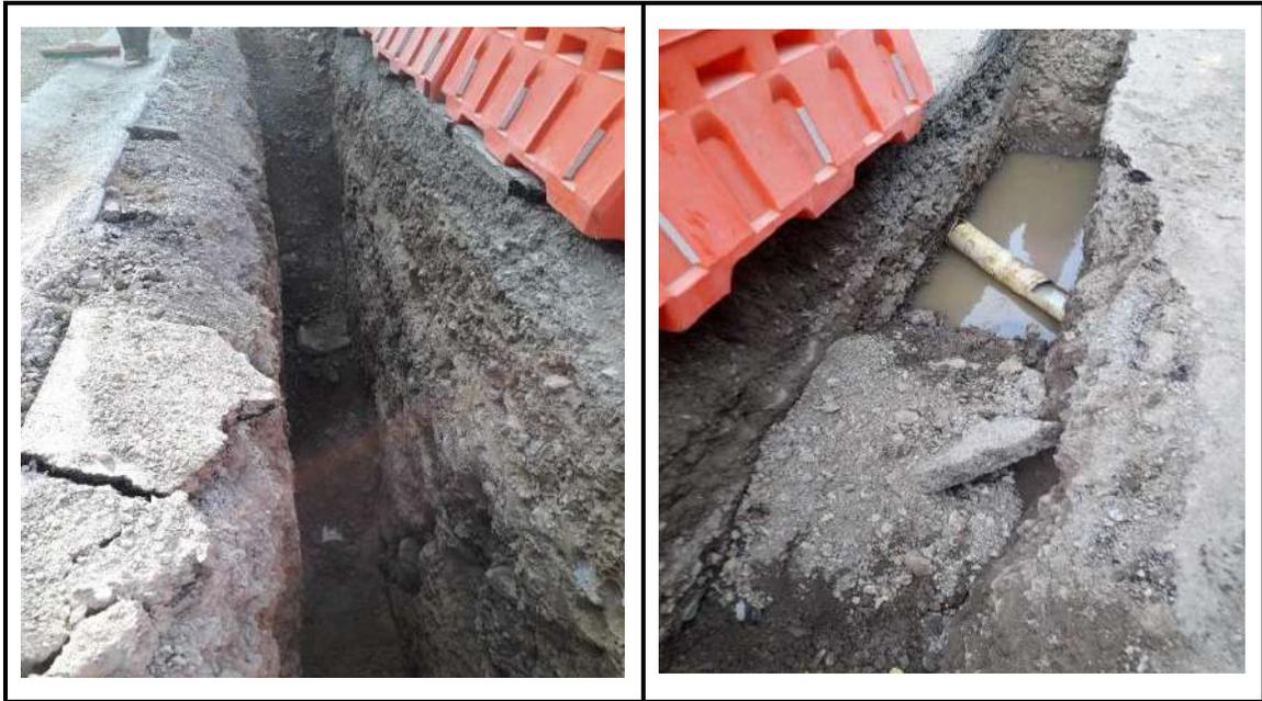
**F46. RELLENO EN LAS EXCAVACIONES DE LA RED DE ALCANTARILLADO .**
