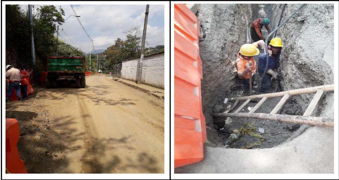
**F23. LIMPIEZA DE DEMOLICION Y FUNDIDA ULTIMO ANILLO Y TAPA CAMARA 43.**
