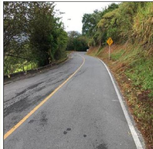
**PR 1+0310.** Imágenes de la señalización vertical cercana al sitio del accidente, se observa la señal preventiva SP-08, donde indica proximidad de curvas sucesivas iniciando la primera a la derecha, adicionalmente se aprecia el estado de la señalización horizontal, la cual presenta línea amarilla de restricción para adelantar.
