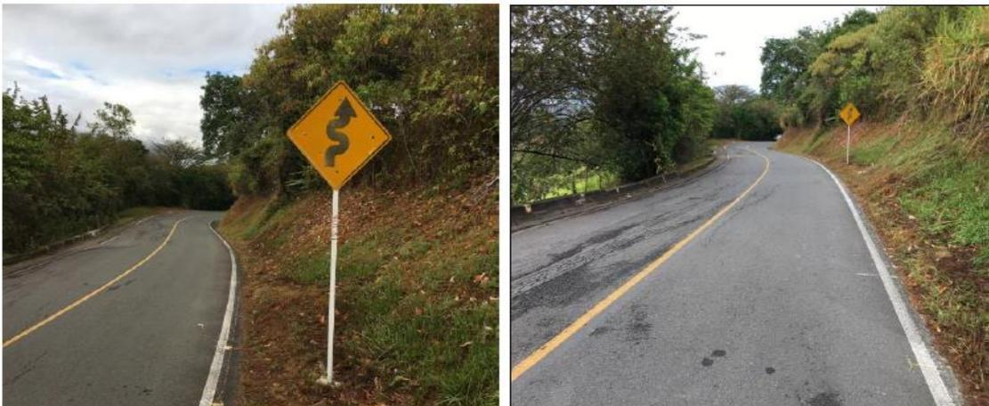
**PR 1+0310.** Imágenes de la señalización vertical cercana al sitio del accidente, se observa la señal preventiva SP-08, donde indica proximidad de curvas sucesivas iniciando la primera a la derecha, adicionalmente se aprecia el estado de la señalización horizontal, la cual presenta línea amarilla de restricción para adelantar.
