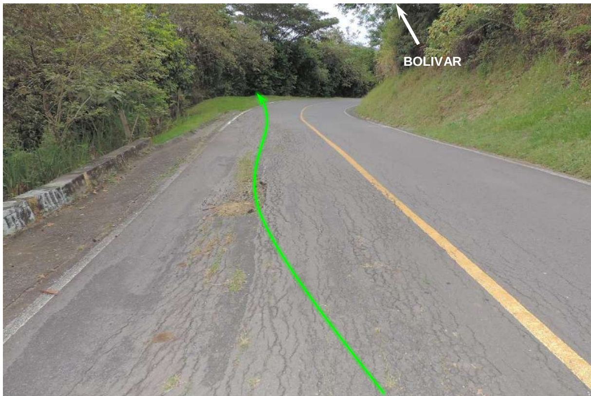
Fotografía N° 4: En esta imagen en sentido El Bordo-Bolívar, se observa la flecha de color verde la cual indica que una vez las llantas del vehículo cayo en el hueco, sufrió una rotura de la hoja de resorte anterior izquierda, lo que generó que el operador del vehículo perdiera el control del mismo.
