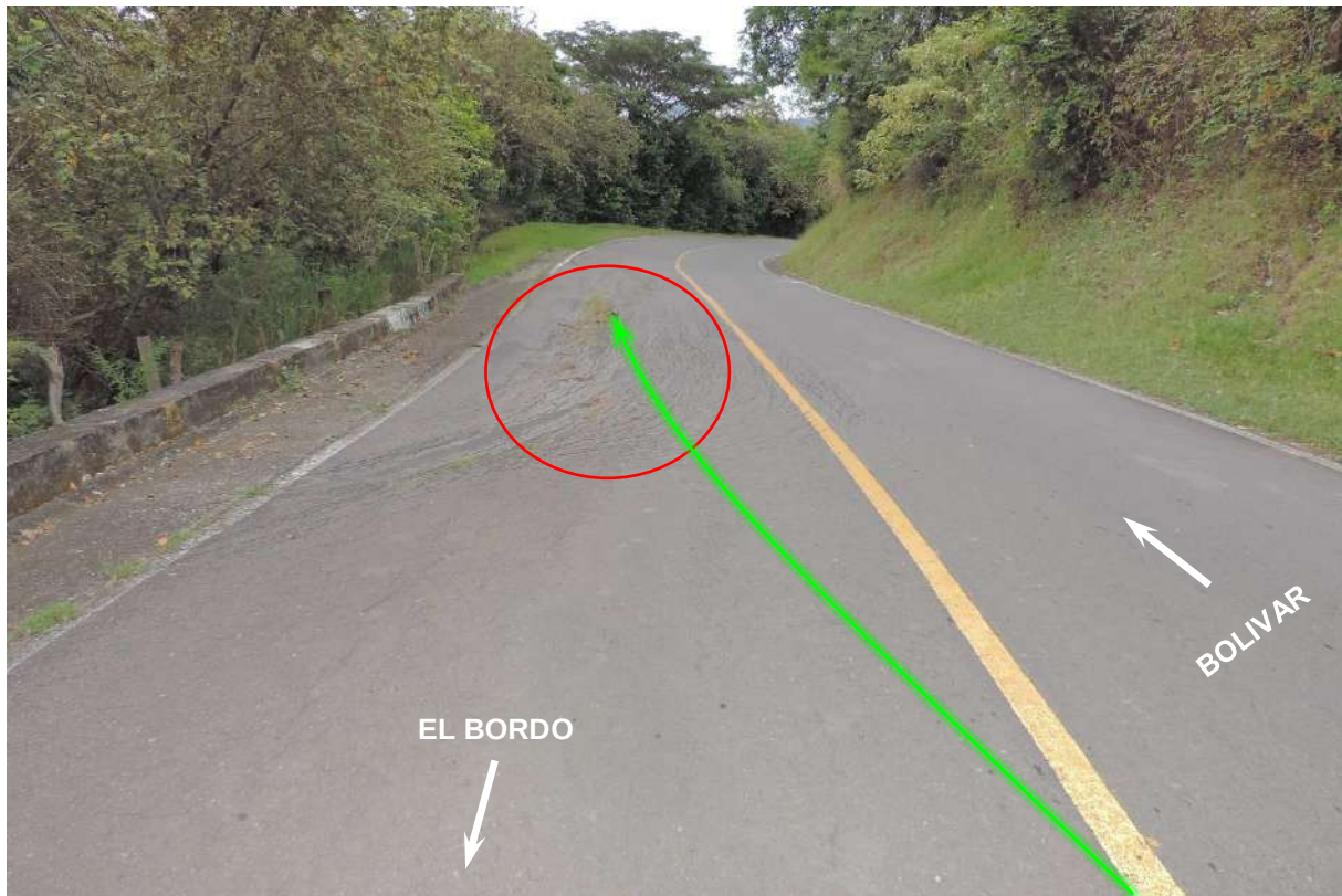
Fotografía N° 3: En esta imagen en sentido El Bordo-Bolívar, se observa la flecha de color verde la cual indica que las llantas del costado izquierdo caen al hueco o bache presente en el carril se sentido Bolívar-El Bordo
