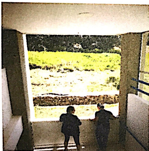
Ilustración 7. Caída del ventanal.
