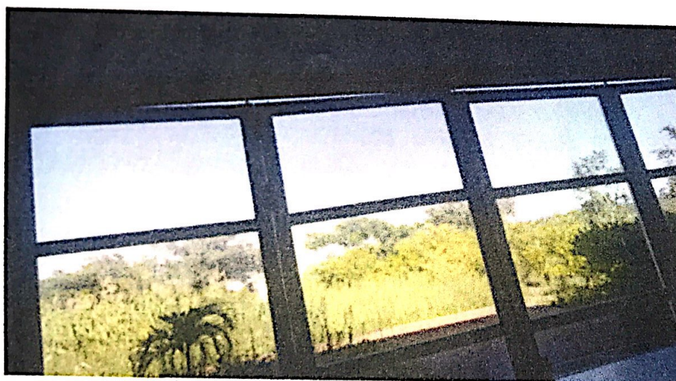
Ilustración 11- Puertas de la fachadas desprendidas.
