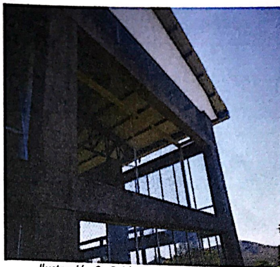
Ilustración 6. Caída Ventanal Superior.
