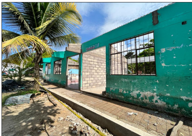
DESMONTE DE CUBIERTAS, VENTANAS Y PUERTAS I.E. SIMON BOLIVAR SEDE COAYARE
