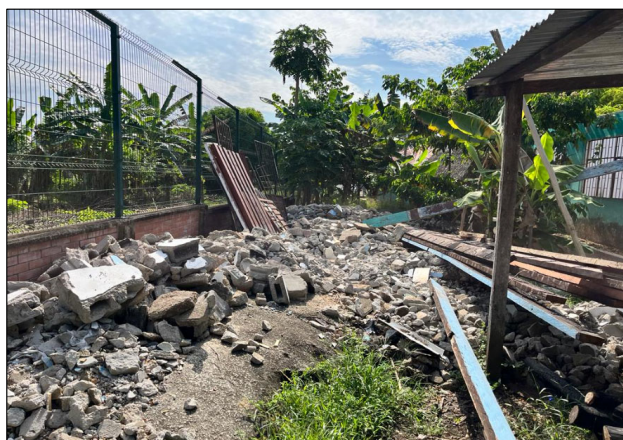
MANEJO INADECUADO DE ESCOMBROS DE DEMOLICIONES I.E. SIMON BOLIVAR SEDE COAYARE
