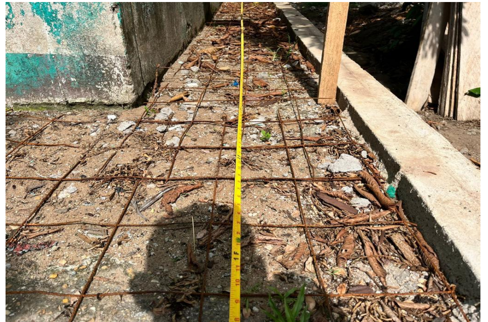
VERIFICACION DE CANTIDADES MALLA ELECTROSOLDADA PARA PLACA DE CONTRAPISO ANDENES PERIMETRALES
