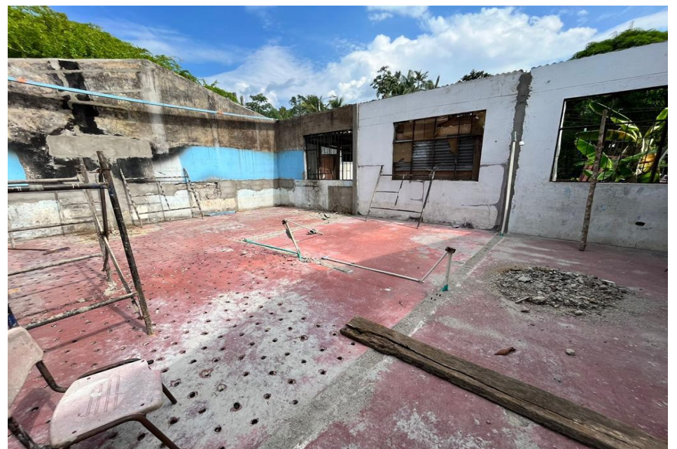
DESCARIFICADO DE PLACA DE CONTRAPISO
