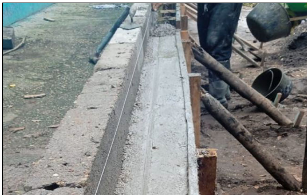
VACIADO DE CONCRTO 3000 PSI CONSTRUCCION DE SARDINEL I.E. SIMON BOLIVAR SEDE COAYARE
