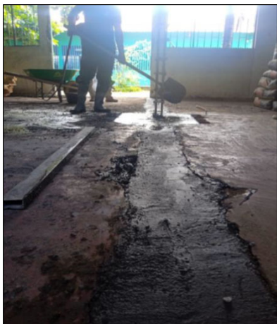
INSTALACION CONCRETO 3000 PSI VIGA I.E. SIMON BOLIVAR SEDE COAYARE
