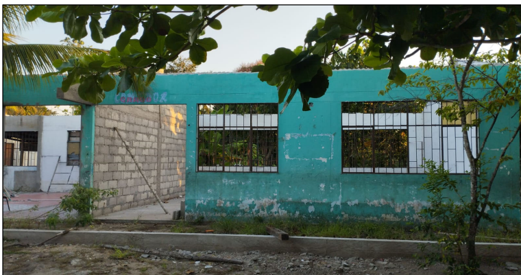
MURO EN BLOQUE DE CONCRETO - DIVISION DE AULAS
