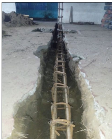
INSTALACION ACERO DE REFUERZO VIGA CIMENTACION I.E. SIMON BOLIVAR SEDE COAYARE
