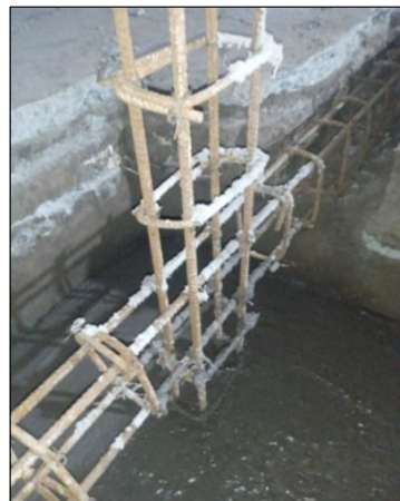
INSTALACION ACERO DE REFUERZO COLUMNA I.E. SIMON BOLIVAR SEDE COAYARE
