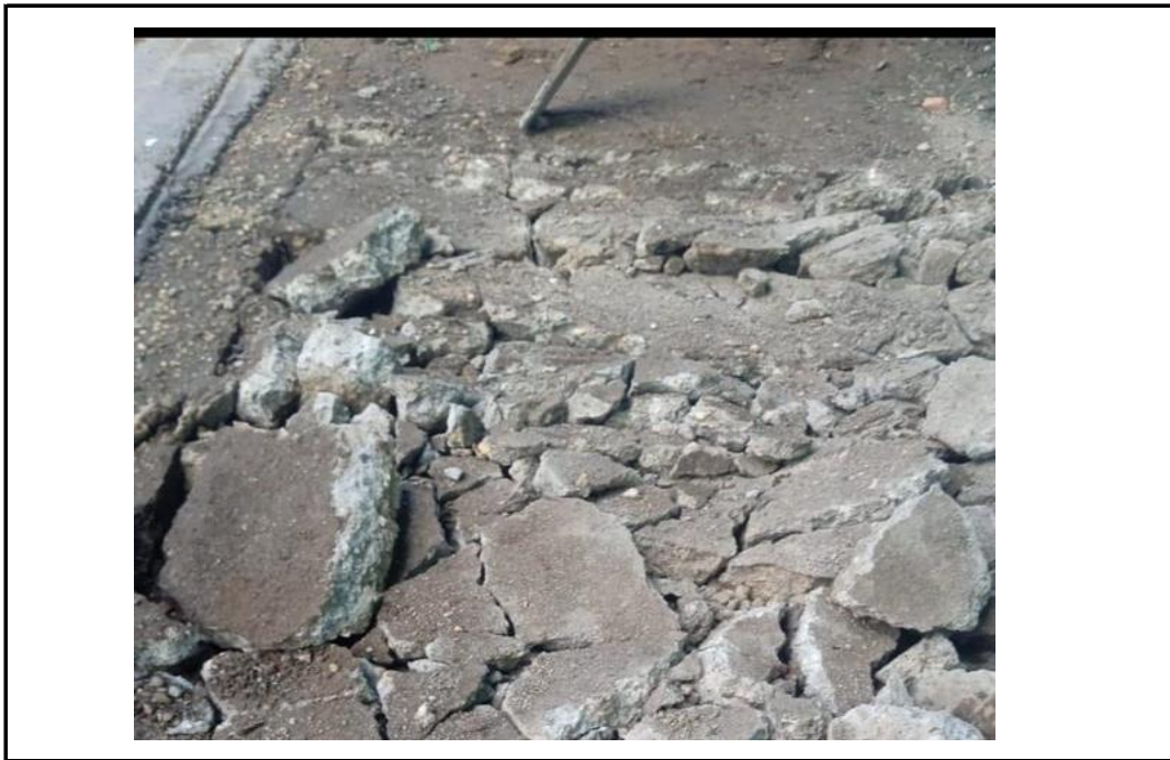
DEMOLICION DE PLACA DE CONTRAPISO
