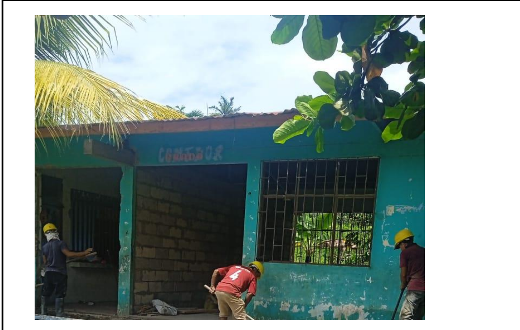
DEMOLICION DE MURO MAMPOSTERIA
