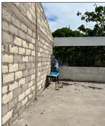
MURO DIVISORIO EN BLOQUE DE CONCRETO LEVANTAMIENTO DE CANTIDADES I.E. SIMON BOLIVAR SEDE COAYARE
