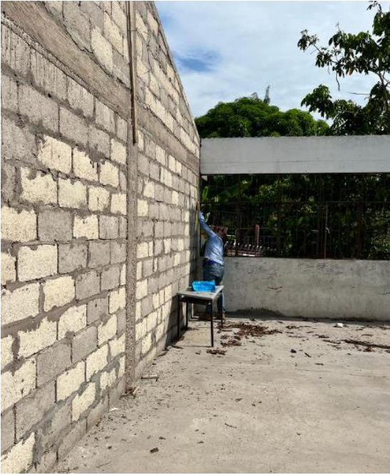
LEVANTE DE MURO EN BLOQUE DE CONCRETO
