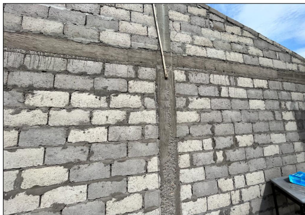
VIGA AEREA Y COLUMNA EN CONCRETO 3000 PSI I.E. SIMON BOLIVAR SEDE COAYARE
