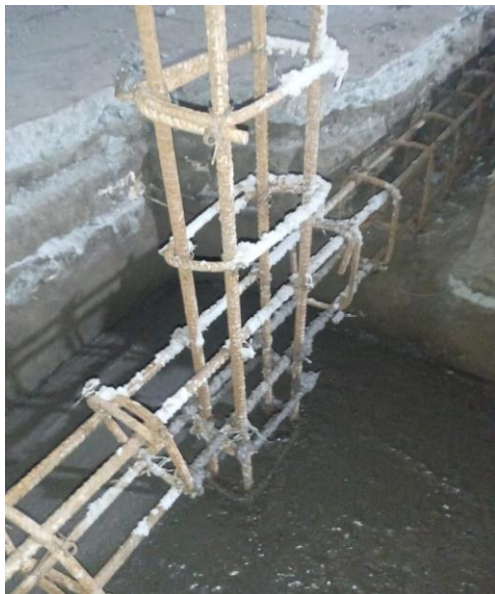
ACERO DE REFUERZO PARA VIGAS Y ZAPATAS
