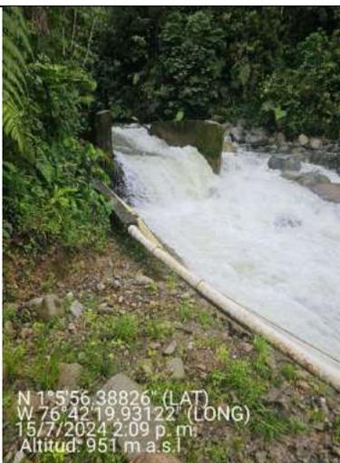
**Imagen 59** Tubería de aducción bocatoma.
