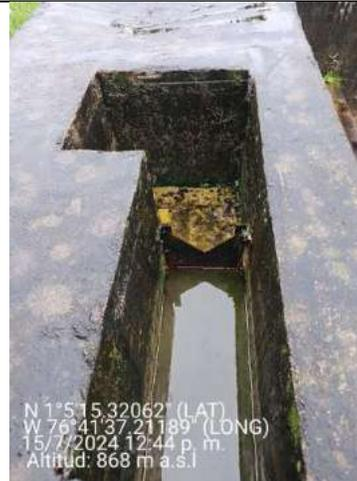
**Imagen 19** Entrada planta de tratamiento de agua potable – Cámara de igualación.
