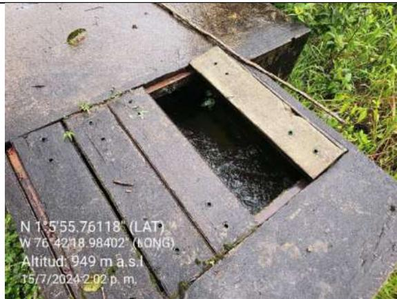
**Imagen 51** Evidencia de entrada de agua al desarenador.
