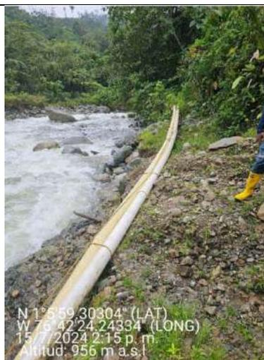
**Imagen 60** Tubería de aducción bocatoma.
