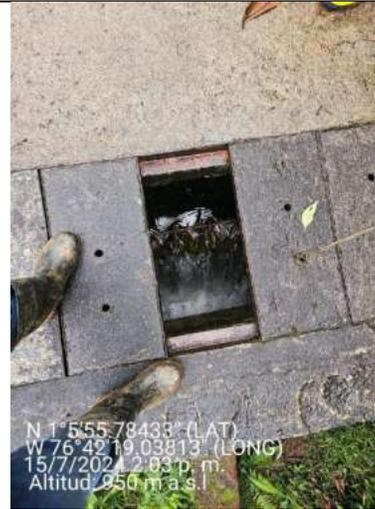
**Imagen 56** Evidencia salida de agua al desarenador.
