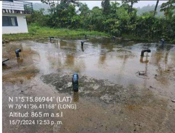
**Imagen 37** Vista superior, Tanque PTAP con tubería de aireación.
