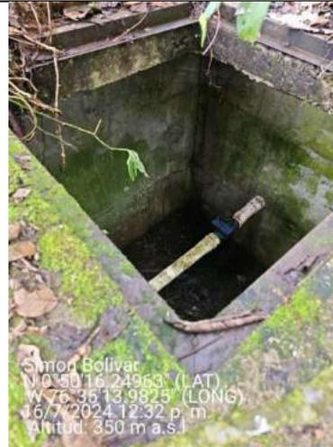
**Imagen 98** Válvula de corte tanque Simón Bolívar.
