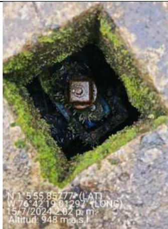
**Imagen 21** Válvula de corte desarenador.
