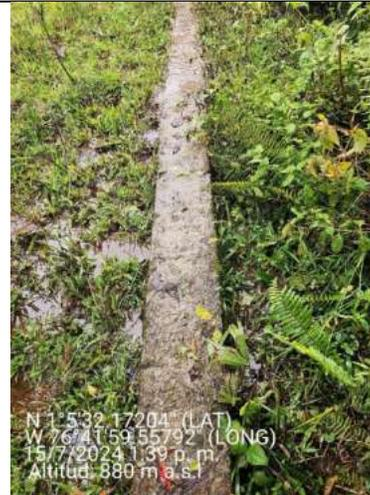
**Imagen 46** Tubería recubierta con concreto.
