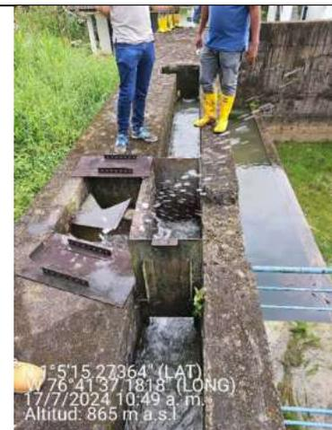
**Imagen 120** Cámara de igualación, canal de entrada y compuertas.
