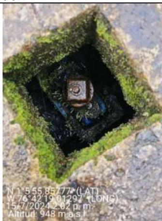
**Imagen 53** Válvula de corte desarenador.
