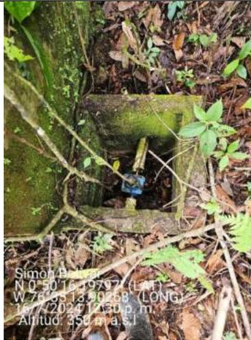
**Imagen 97** Válvula de corte tanque Simón Bolívar.
