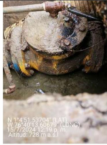
**Imagen 14** Válvula de quiebre con falta de mantenimiento.
