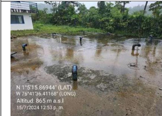
**Imagen 45** Vista superior, Tanque PTAP con tubería de aireación.
