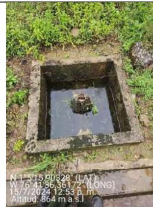
**Imagen 46** Válvula de corte PTAP.
