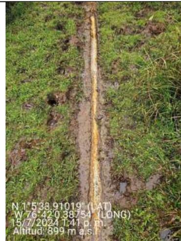
**Imagen 48** Tubería recubierta con concreto.
