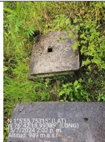
**Imagen 20** Caja válvula de corte desarenador.
