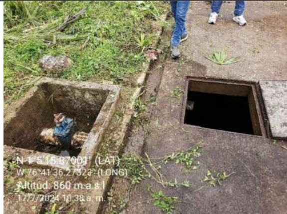
**Imagen 115** Válvulas de corte, cajas y compuertas PTAP.
