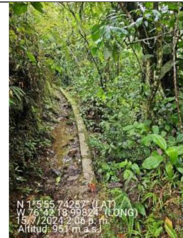
**Imagen 58** Tubería recubierta con concreto.
