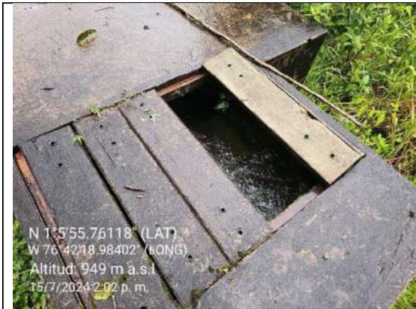
**Imagen 19** Evidencia de entrada de agua a desarenador.
