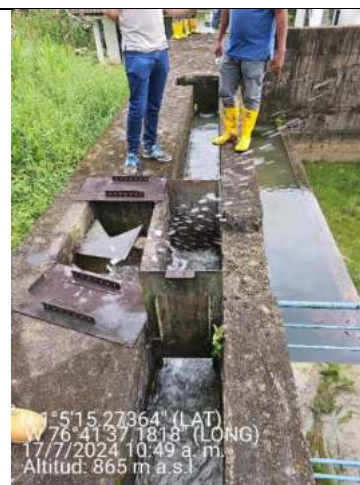
Imagen 120 Cámara de igualación, canal de entrada y compuertas.
