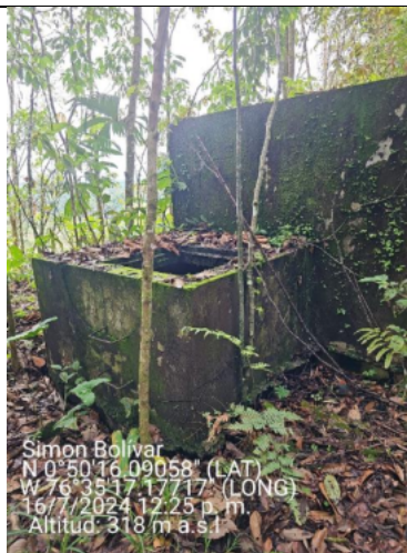
Imagen 86 Tanque Simón Bolívar.
