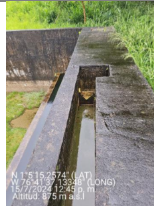
Imagen 32 Vertedero de aforo de caudal PTAP.
