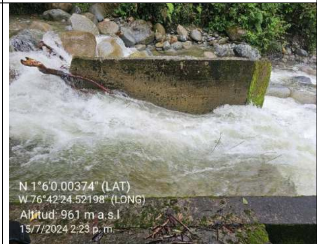
Imagen 64 Cámara de ingreso bocatoma.
