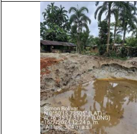
Imagen 93 Tubería rota por construcción de piscinas – Sector Simón Bolívar.
