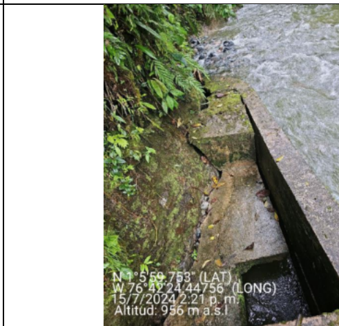
Imagen 64 Cámara de ingreso bocatoma.
