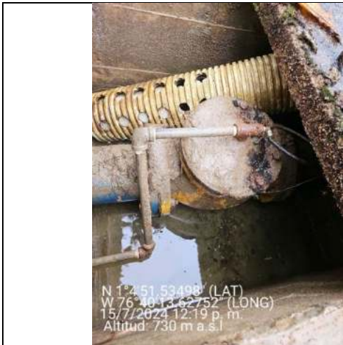
Imagen 7 Válvula de quiebre.
