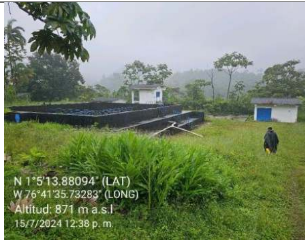
Imagen 25 Vista general planta de tratamiento de agua.
