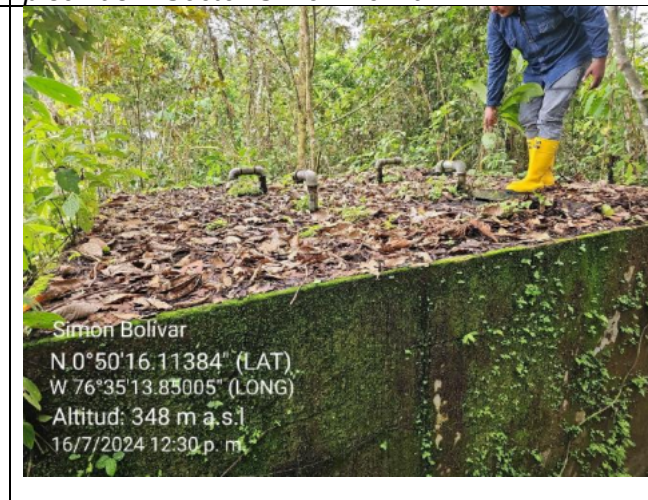
Imagen 96 Tanque Simón Bolívar.
