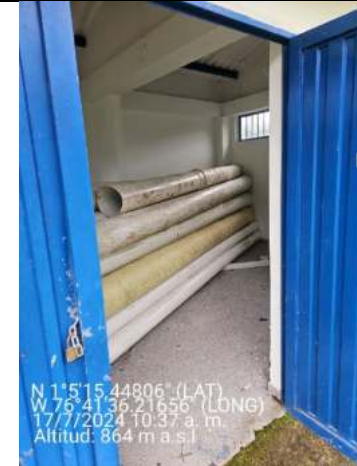
Imagen 114 Cuarto de almacenamiento PTAP.
