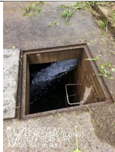
Imagen 116 Evidencia entrada de agua al tanque PTAP.
