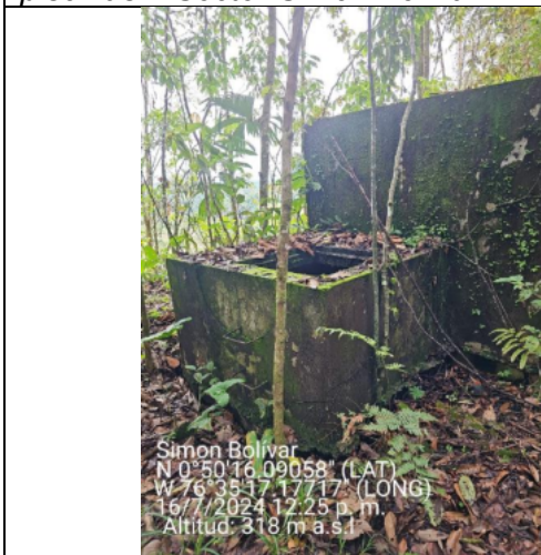
Imagen 95 Tanque Simón Bolívar.
