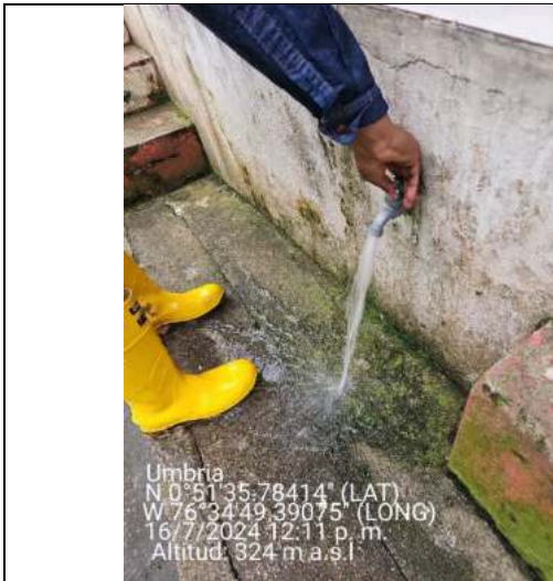
Imagen 91 Evidencia suministro de agua sector Umbria.
