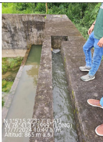
Imagen 119 Ingreso de agua por la canaleta de entrada.
