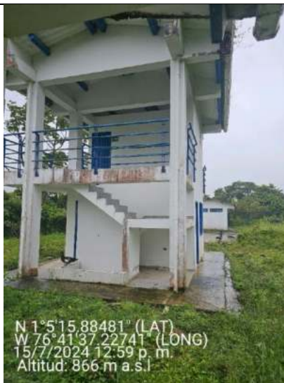
Imagen 41 Cuarto de cloración.
