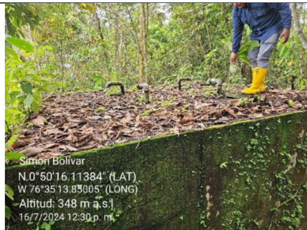
Imagen 87 Tanque Simón Bolívar.
