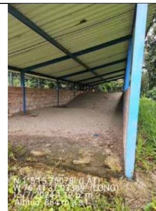
Imagen 52 Zona de acopio de material – Arena de río.
