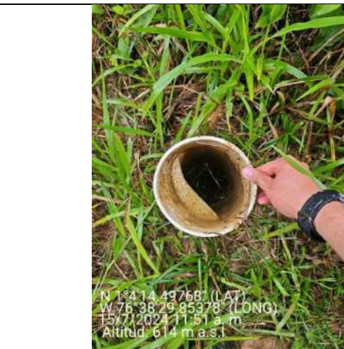
Imagen 12 Tubo con abolladura reemplazado por la Alcaldía.
