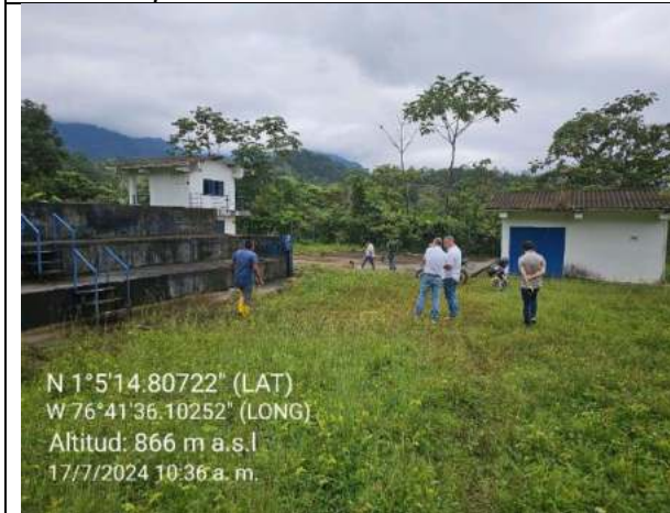
Imagen 113 Vista general PTAP.
