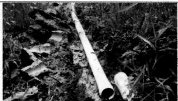
Foto 8. Afectación de tubería de conducción en la vereda La Tebaida por deslizamientos de terreno.
