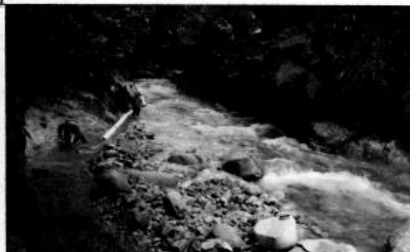
Foto 3. Estado de la bocatoma del Macroacueducto Villagarzón – La Joya. Se evidencia la socavación y el desvío del cauce, afectando la entrada de agua por la rejilla de la bocatoma.
