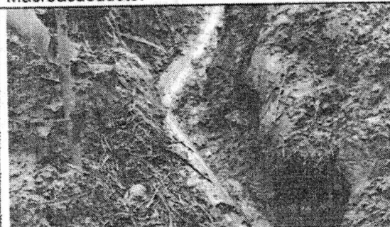
Foto 7. Afectación de la tubería por daños ocasionados por malas prácticas constructivas, reduciendo el caudal, en el sector Las Toldas, finca de la familia Benavides.
