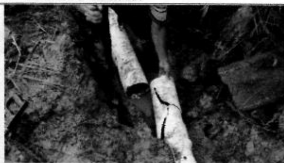
Foto 9. Afectación de tubería de conducción en la vereda La Tebaida por deslizamientos de terreno.
