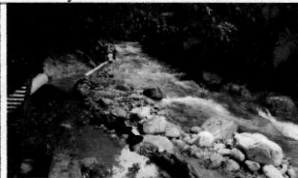
Foto 2. Estado de la bocatoma del Macroacueducto Villagarzón – La Joya. Después de las fuertes lluvias ocurridas en los días 12 agosto de 2021. Se evidencian los trabajos realizados con personal de adscrito a Aguas la Cristalina para restablecer el servicio.
