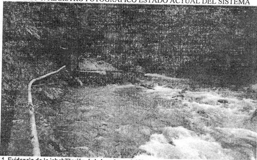
Foto 1. Evidencia de la inhabilitación de la bocatoma del Macroacueducto Villagarzón - La Joya. Tomada el 14/08/2021
