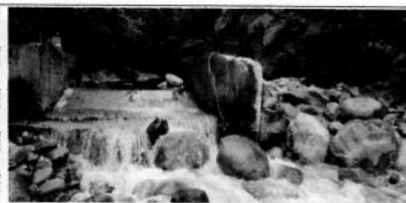
Foto 35. Captación adecuada con un enrocado que ha soportado a la fecha una gran creciente del río Dorado.
