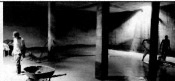
Foto 30. Evidencia de lavado de tanques de almacenamiento en la planta de tratamiento vereda La Tebaida.
