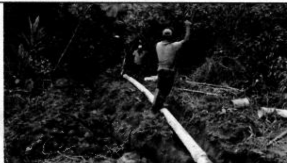
Foto 6. Reposición de tubería que fue afectada por un deslizamiento en el sector vereda Las Toldas, finca de la familia Benavides.
