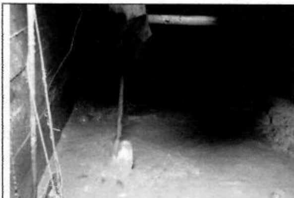
Foto 4. Lavado del desarenador después de la creciente del día 12 de agosto de 2021, que dejó colmatado el desarenador.
