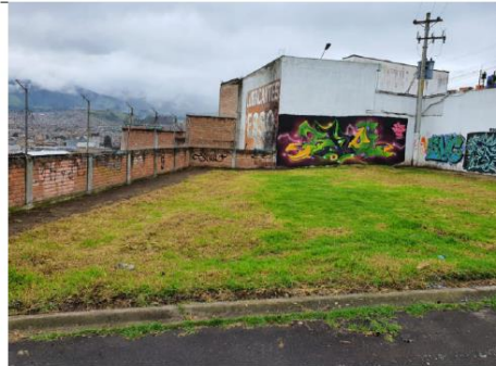
Instalación de Base para pista Perimetral de atletismo
