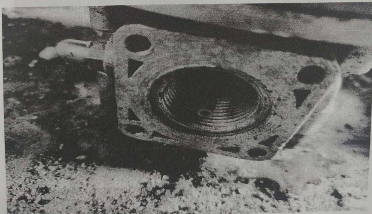
Regulador sin continuidad de conexión a equipos en la zona de producción.
