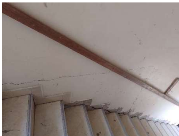
Muro afectado, se requiere ser demolido.
