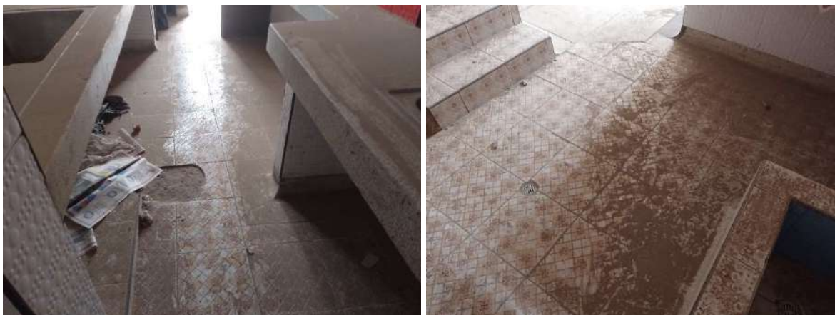
Pisos en cocina en mal estado después de la explosión y levantamiento de escombros.
