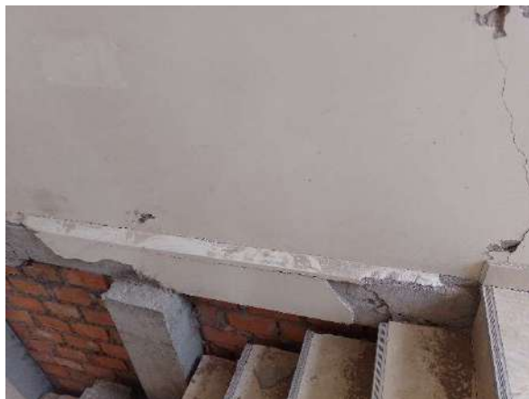
El muro sufrió lesiones tras la explosión y debe ser demolido igual que la viga que lo sostiene.
