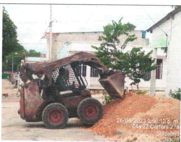
Acarreo de base granular desde el campamento de obra hasta el sitio donde se construirán los andenes
