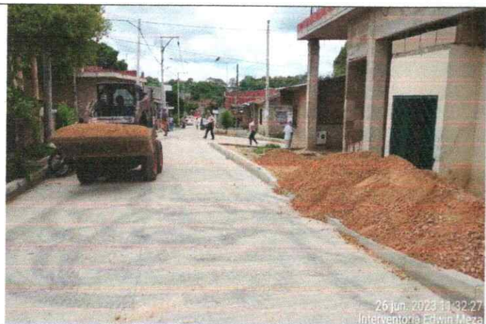
Acarreo de base granular desde el campamento de obra hasta el sitio donde se construirán los andenes
