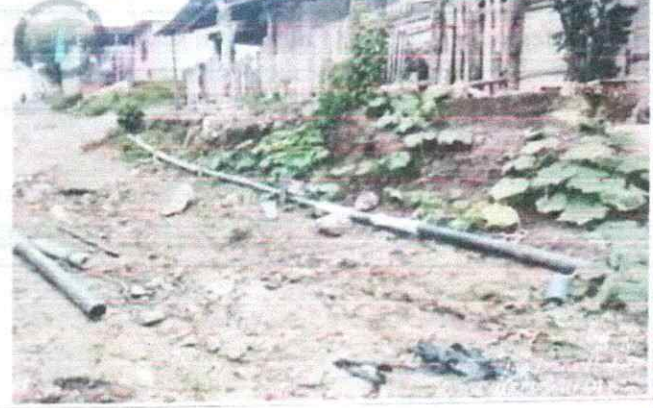
Imagen 1. Reparación con uniones de reparación de la fuga en la tubería de acueducto que se encuentra sobre la vía entre la carrera 24B y 24A
