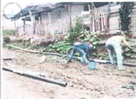
Imagen 1. Reparación con uniones de reparación de la fuga en la tubería de acueducto que se encuentra sobre la vía entre la carrera 24B y 24A
