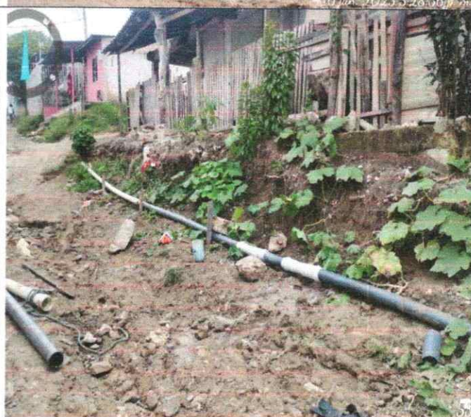
Reparación con uniones de reparación de la fuga en la tubería de acueducto que se encuentra sobre la vía entre la carrera 24B y 24A
