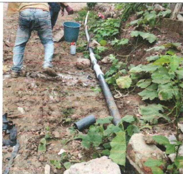
Reparación con uniones de reparación de la fuga en la tubería de acueducto que se encuentra sobre la vía entre la carrera 24B y 24A
