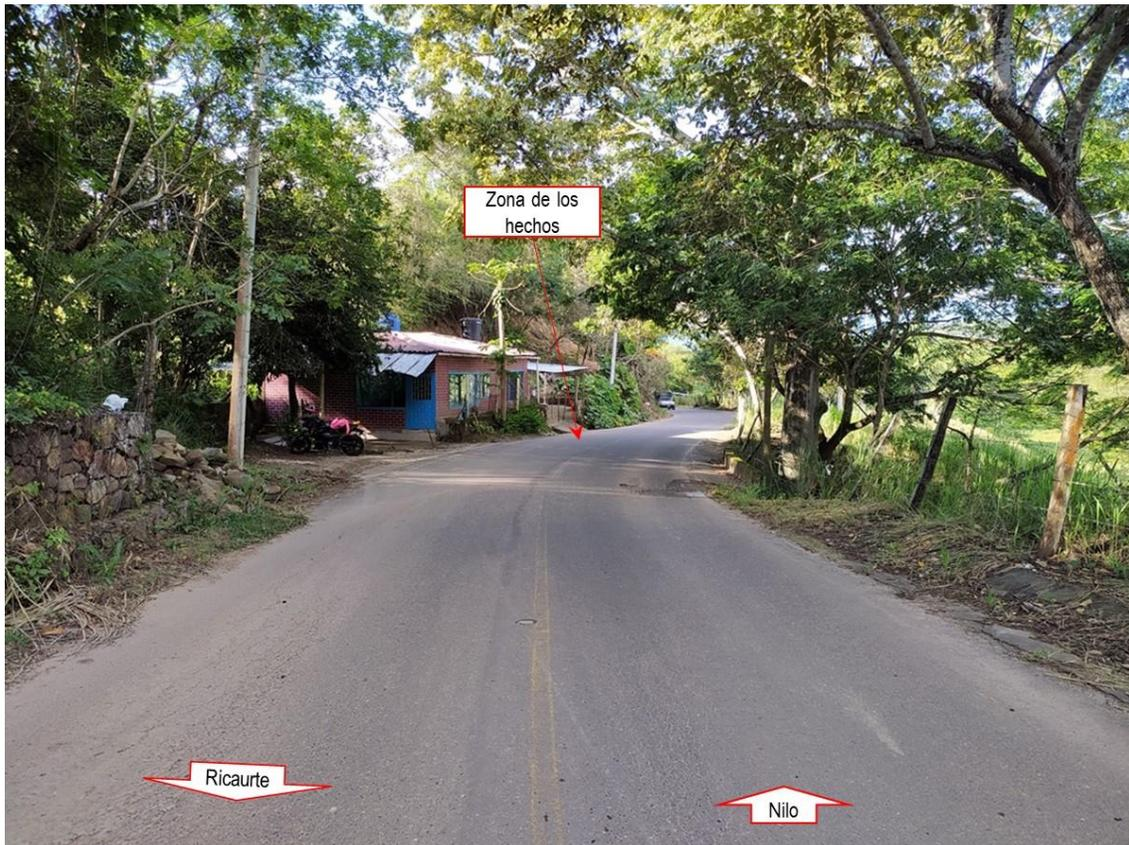
**Fotografía No.6 Aérea:** fotografía tomada en sentido Ricaurte – Nilo, donde se observan las características generales del tramo de vía curva, pendiente, estado bueno, doble sentido de circulación, sin demarcación horizontal línea central continua amarilla y sin señalización vertical. En este sentido se desplazaba el Vehículo No 1 AUTOMÓVIL.
