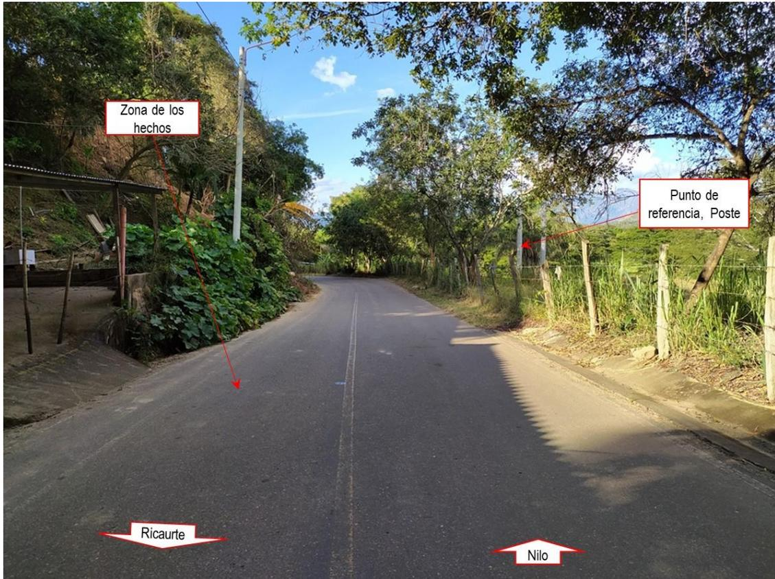
**Fotografía No.8 Plano General:** fotografía tomada en sentido Ricaurte – Nilo, donde se observan las características generales del tramo de vía curva, pendiente, estado bueno, doble sentido de circulación, sin demarcación horizontal línea central continua amarilla y sin señalización vertical. En este sentido se desplazaba el Vehículo No 1 AUTOMÓVIL.
