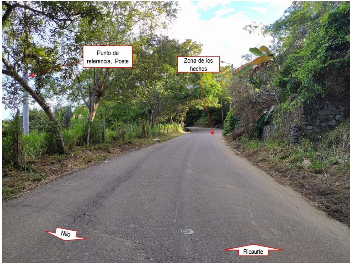
**Fotografía No. 1 Plano General** fotografía tomada en sentido Nilo - Ricaurte, donde se observan las características generales del tramo de vía curva, pendiente, estado bueno, doble sentido de circulación, sin demarcación horizontal línea central continua amarilla y sin señalización vertical. En este sentido se desplazaba el Vehículo No 2 MOTOCICLETA.
