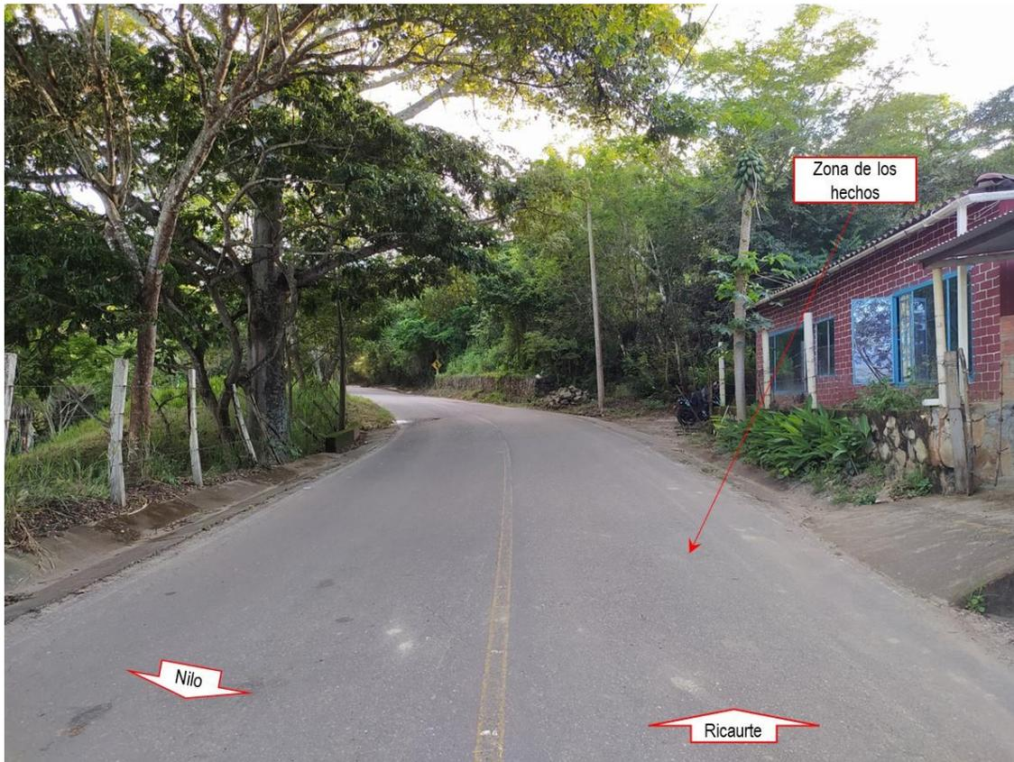
**Fotografía No.3 Plano General:** fotografía tomada en sentido Nilo - Ricaurte, donde se observan las características generales del tramo de vía curva, pendiente, estado bueno, doble sentido de circulación, sin demarcación horizontal línea central continua amarilla y sin señalización vertical. En este sentido se desplazaba el Vehículo No 2 MOTOCICLETA.
