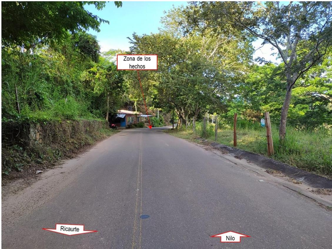
**Fotografía No.5 Plano General:** fotografía tomada en sentido Ricaurte – Nilo, donde se observan las características generales del tramo de vía curva, pendiente, estado bueno, doble sentido de circulación, sin demarcación horizontal línea central continua amarilla y sin señalización vertical. En este sentido se desplazaba el Vehículo No 1 AUTOMÓVIL.
