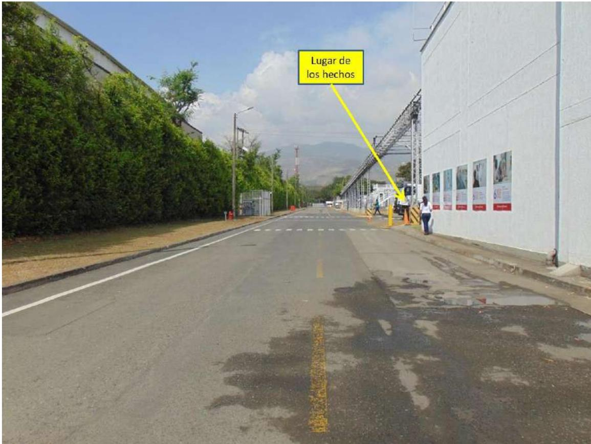
**FOTOGRAFÍA No. 1 PANORÁMICA:** En esta fotografía tomada por el equipo de IRS Vial en el parqueadero interno Johnson & Johnson, se aprecian las características generales de la vía, en la cual se encuentra demarcación horizontal de línea amarilla segmentada y líneas de borde, sin señalización vertical.
