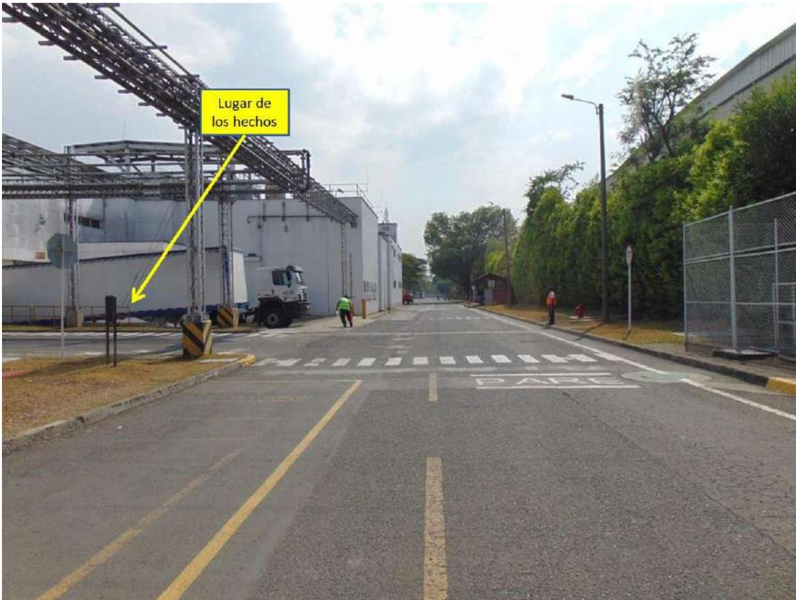
**FOTOGRAFÍA No. 3 PANORÁMICA:** En esta fotografía tomada por el equipo de IRS Vial en el parqueadero interno Johnson & Johnson, se aprecian las características generales de la vía, en la cual se encuentra demarcación horizontal de línea amarilla segmentada, líneas de borde y paso peatonal (cebra), sin señalización vertical.
