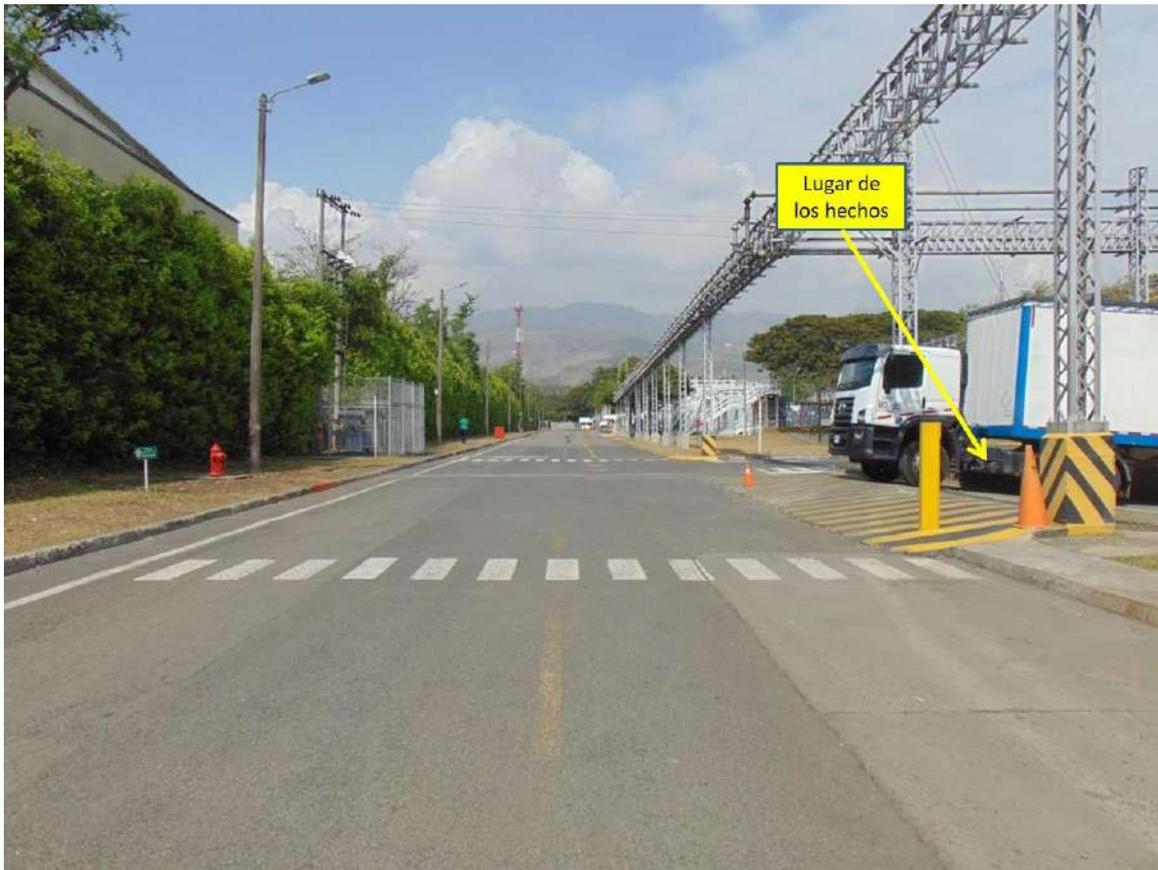
**FOTOGRAFÍA No. 2 PANORÁMICA:** En esta fotografía tomada por el equipo de IRS Vial en el parqueadero interno Johnson & Johnson, se aprecian las características generales de la vía, en la cual se encuentra demarcación horizontal de línea amarilla segmentada, líneas de borde y paso peatonal (cebra), sin señalización vertical.
