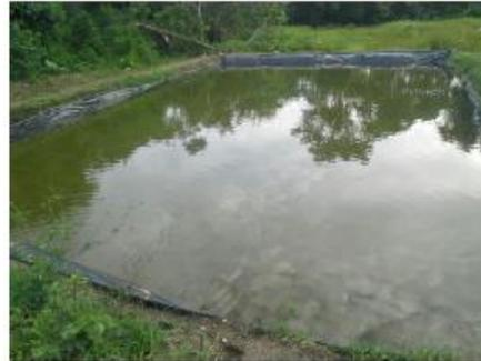
*Como se observa en el registro fotográfico se ejecutaron las actividades de reforzamiento del dique y el acondicionamiento de la superficie con lona plástica para mejorar la capacidad de estanqueidad del área del estanque para la producción de peces, se verificó que se contaba con disponibilidad de abastecimiento de agua para su funcionamiento.*
