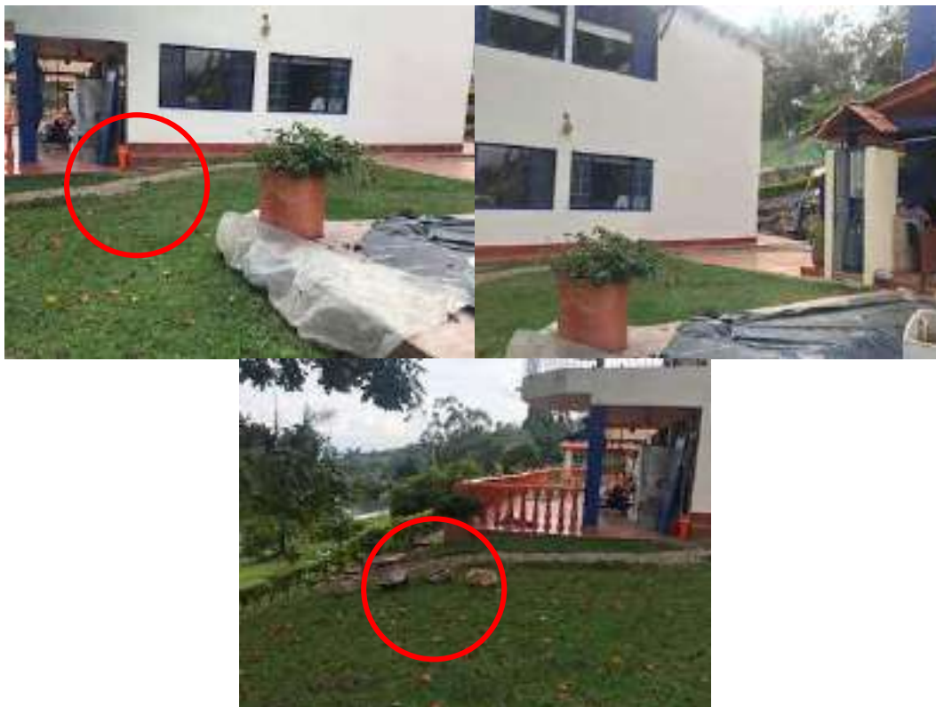
Filtro perimetral a la estructura.
