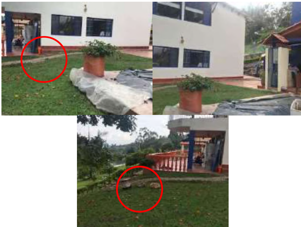
Filtro perimetral a la estructura.
