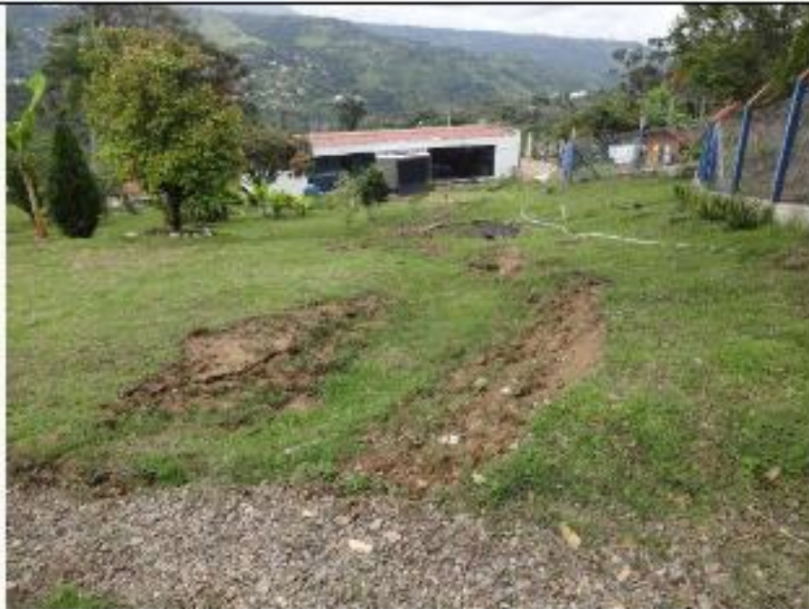
Foto No 1 : Ubicación de la casa Asegurada en terreno Montañoso de ladera, Parte Posterior de la Casa Asegurada, Costado Norte (Fuente Inspección FGR-SIS junio 17 de 2021)
