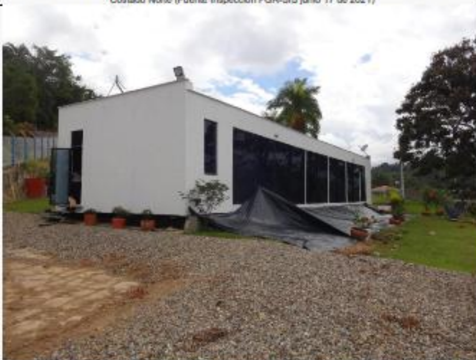
Foto No 2 : Parte anterior de la casa Asegurada, Costado Sur, (Fuente Inspección 17 junio de 2021 FGR-SIS)
