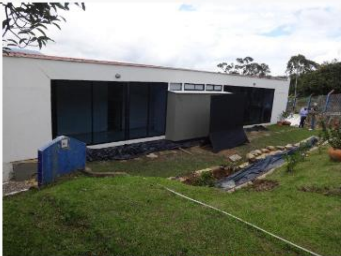
Foto No 3: Fachada Posterior de la casa. Costado Norte de la casa
