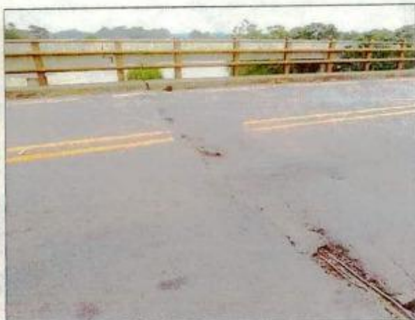
FOTOGRAFÍA No.5 y 6: Fotografía tomada en el área de impacto en sentido La Lizama- San Alberto, sobre el puente que cruza el Rio Sogamoso. Una calzada con dos carriles, vía en mal estado de conservación, con hundimiento, fisuras transversales y grietas en las juntas. Tramo vial recto, con señalización horizontal líneas de borde y línea central continua amarilla, con andenes en los costados con un ancho de 0,60 metros y bermas de 0,70 metros, sitio despoblado. Sentido vehicular de la motocicleta de placas WIF 31E
