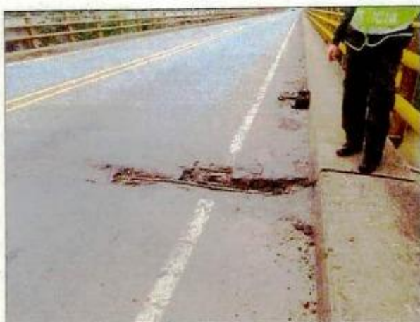
FOTOGRAFÍA No.5 y 6: Fotografía tomada en el área de impacto en sentido La Lizama- San Alberto, sobre el puente que cruza el Rio Sogamoso. Una calzada con dos carriles, vía en mal estado de conservación, con hundimiento, fisuras transversales y grietas en las juntas. Tramo vial recto, con señalización horizontal líneas de borde y línea central continua amarilla, con andenes en los costados con un ancho de 0,60 metros y bermas de 0,70 metros, sitio despoblado. Sentido vehicular de la motocicleta de placas WIF 31E
