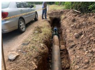
Ilustración 5. instalación tubería
