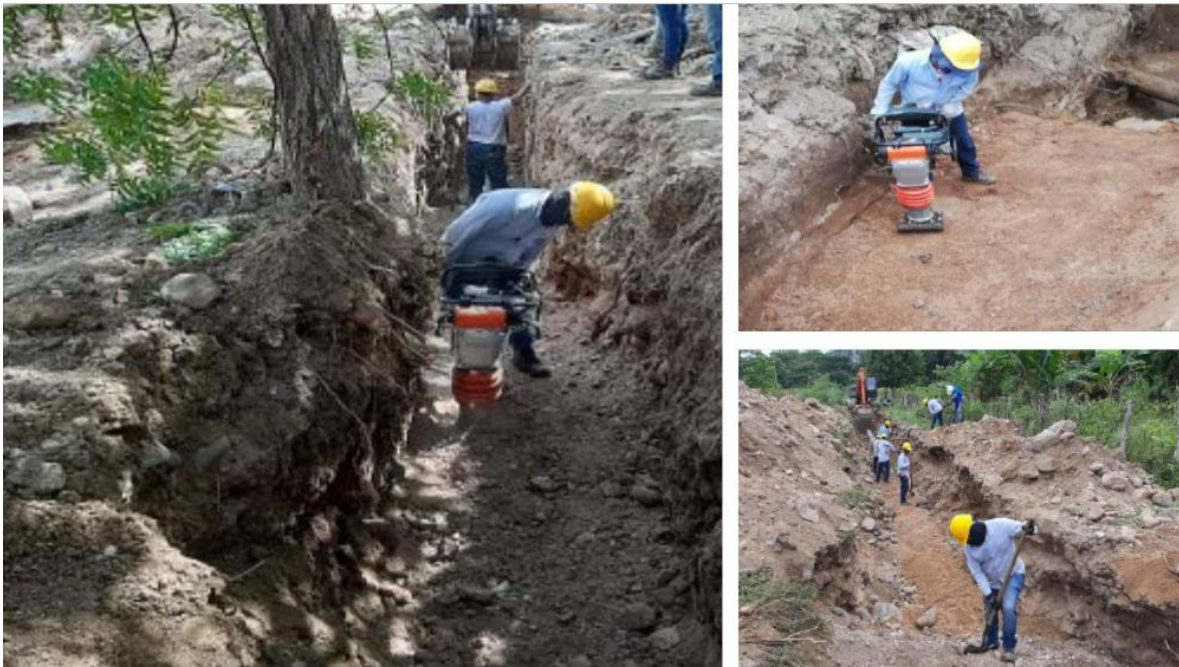
Ilustración 4. Rellenos
