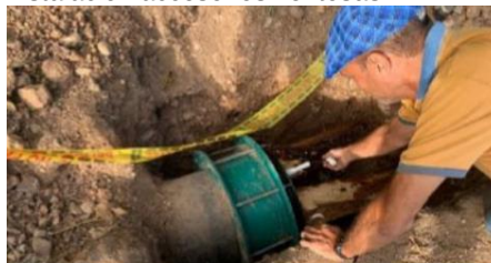
Ilustración 6. Instalación accesorios ventosas
